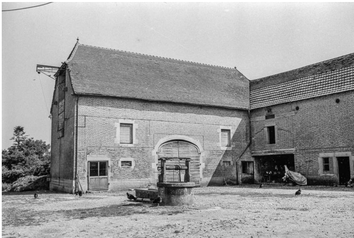
Bâtiment d'exploitation : vue rapprochée..
