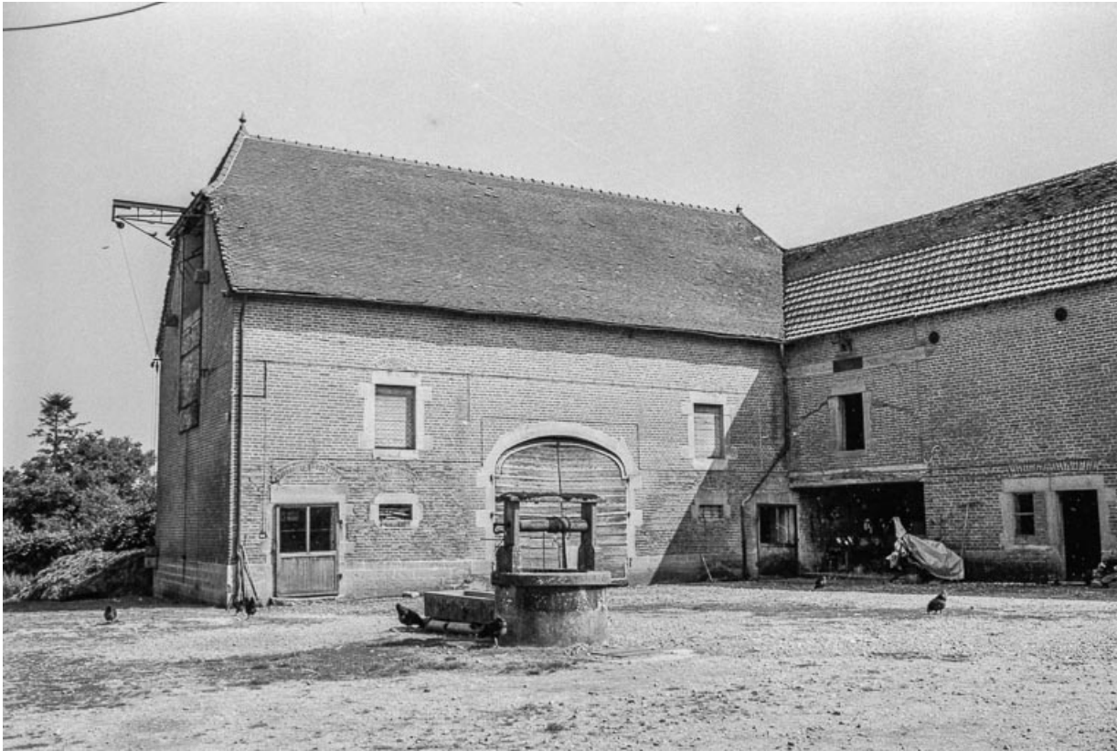
Bâtiment d'exploitation : vue rapprochée..
