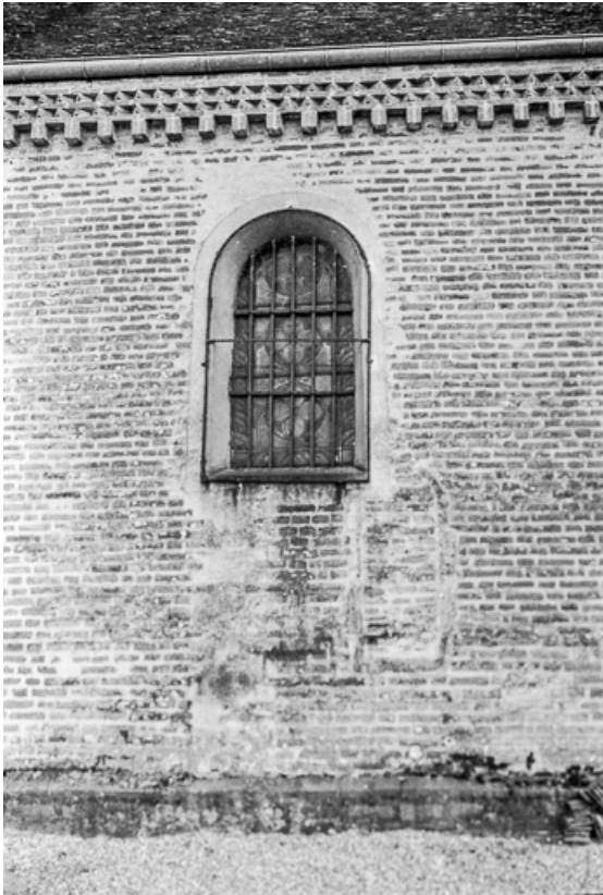
Extérieur : baie latérale.
