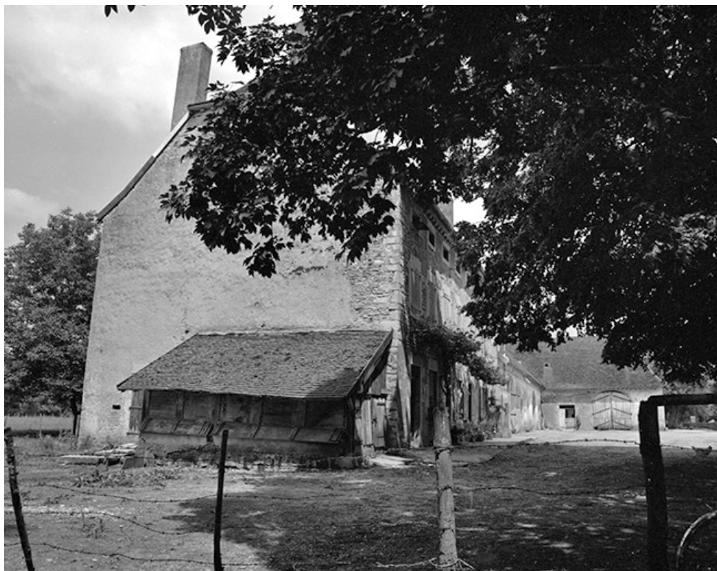
La ferme, vue générale de trois quarts gauche.
