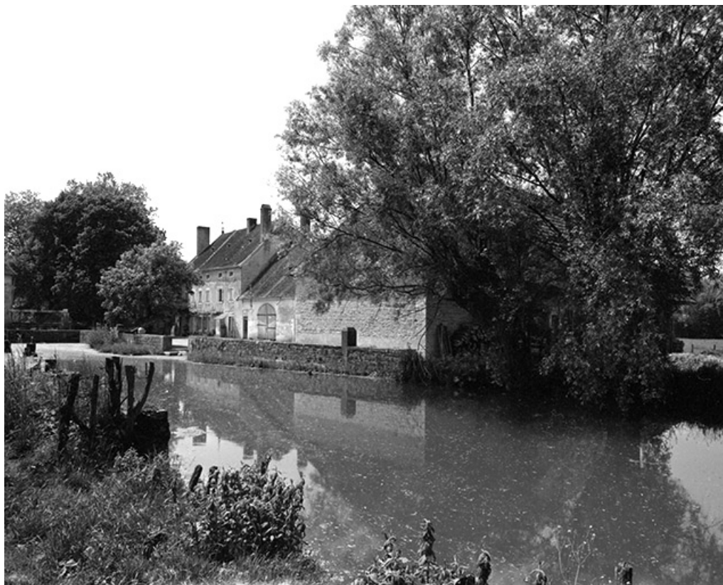
La ferme, vue générale de trois quarts droit.
