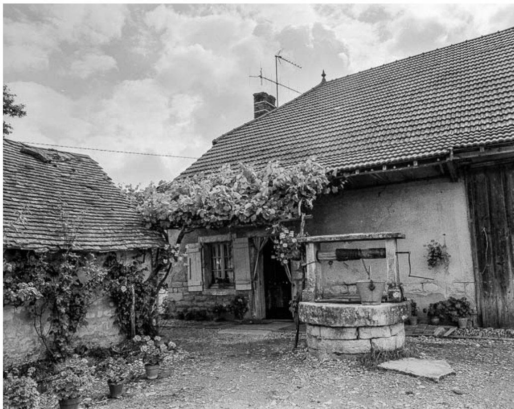
Façade antérieure de l'habitation.
