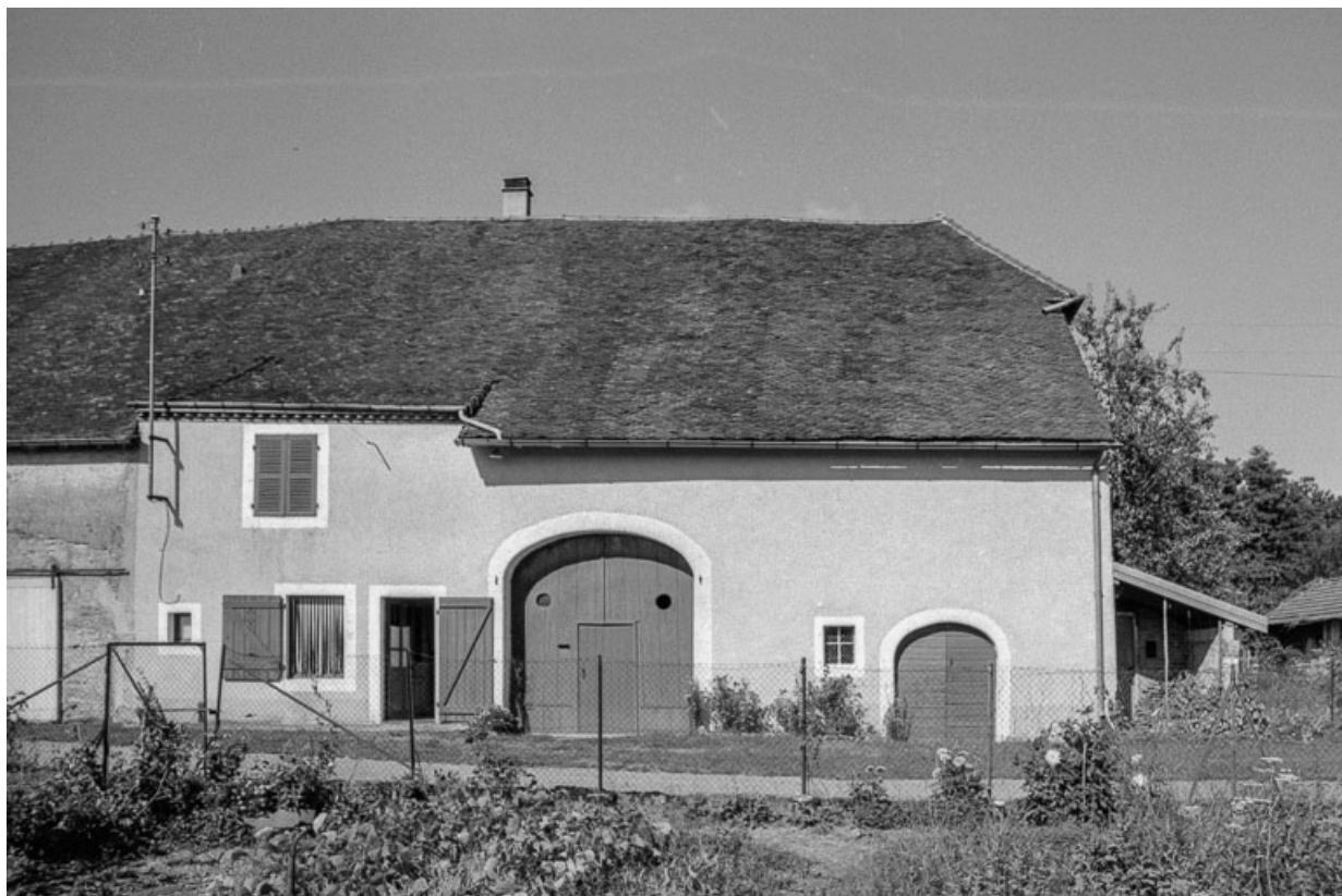
Ferme : façade antérieure.
