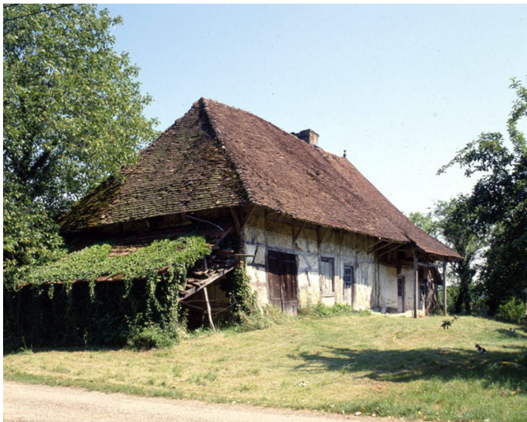
Façades antérieure et latérale gauche en 1990.
