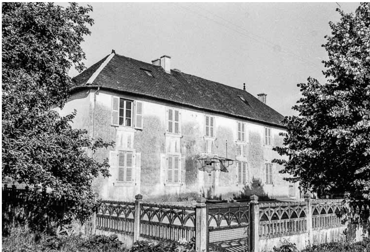
Demeure cadastrée 1969 AD 39 : façade antérieure.
