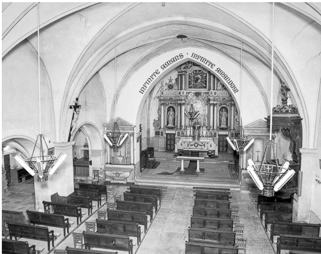
Nef, élévation gauche et chœur vus de la tribune.
