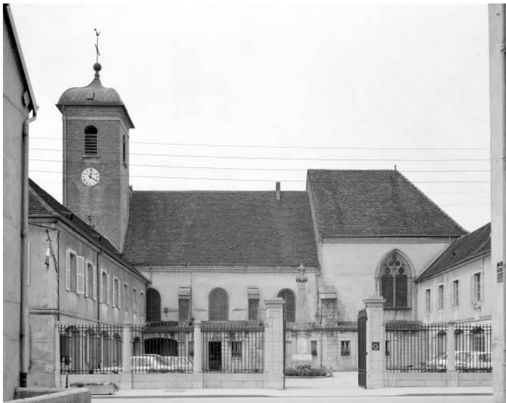
Façade latérale droite.
