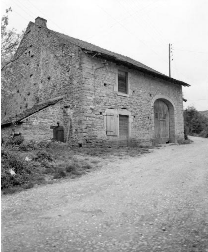
Façade antérieure : vue de trois-quarts gauche. 39, Arlay rue du Couriot, lieudit : Arlay-Saint-Vincent
