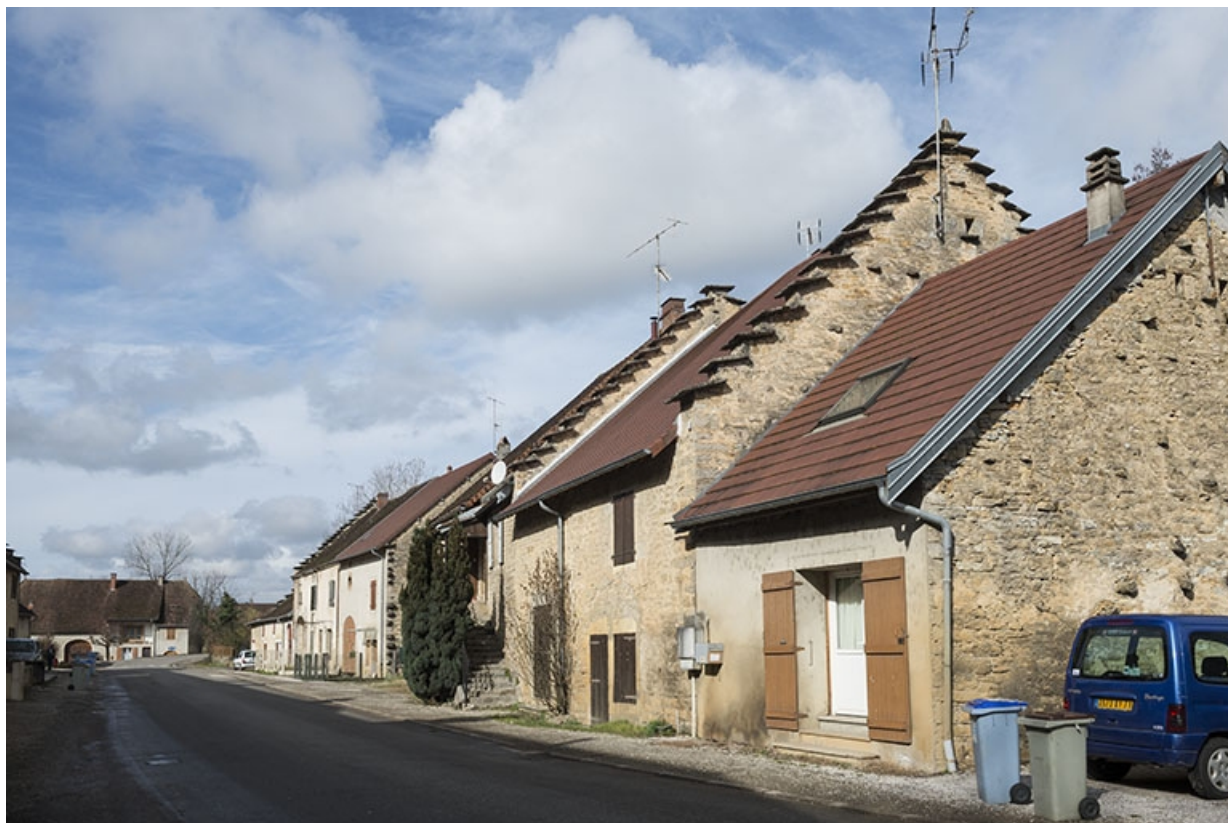
Maisons situées au centre du village (2015). A noter les pignons à redents. 39, Arlay, lieudit : Arlay-le-Bourg
