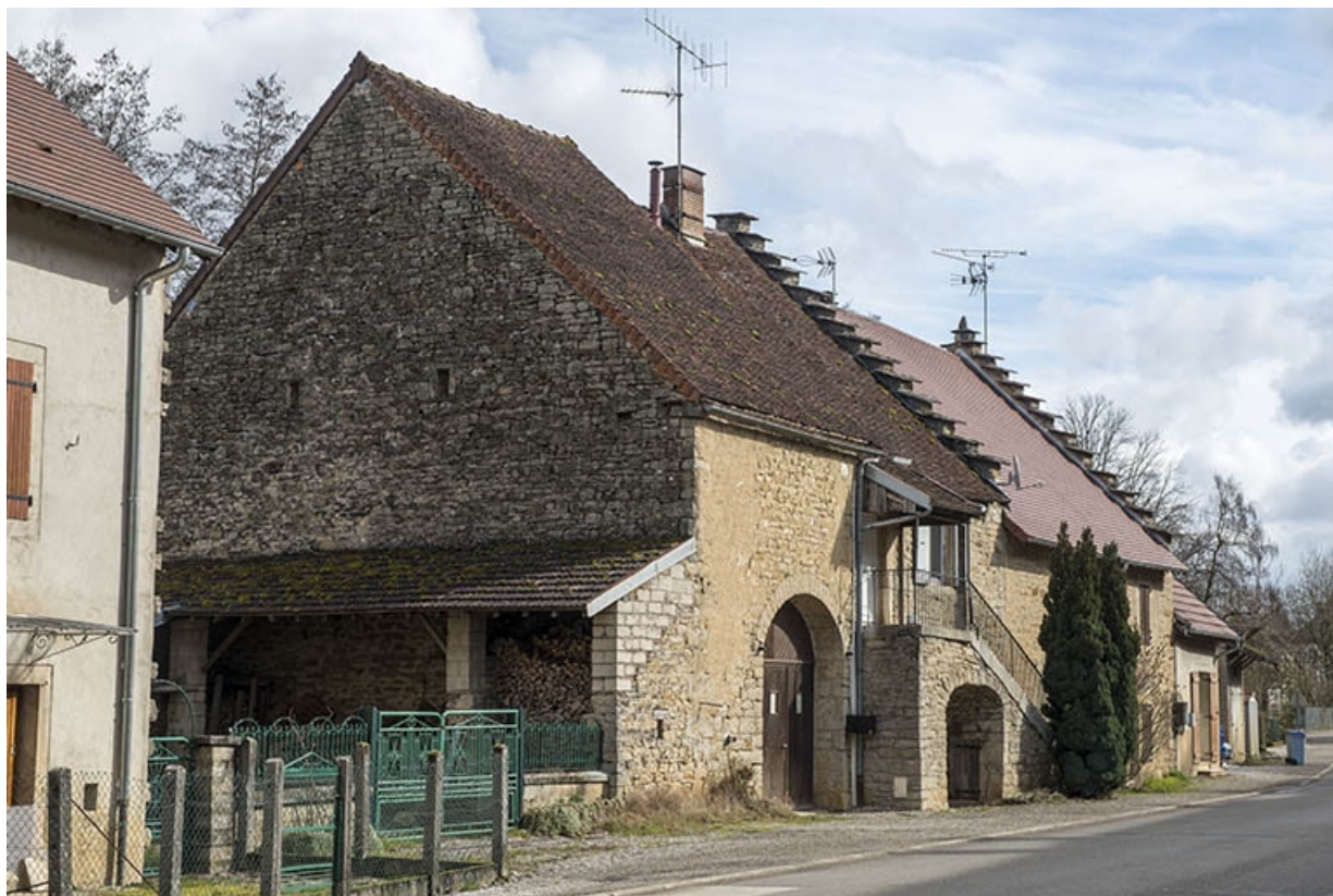
Maisons situées au centre du village (1990). A noter les pignons à redents.
