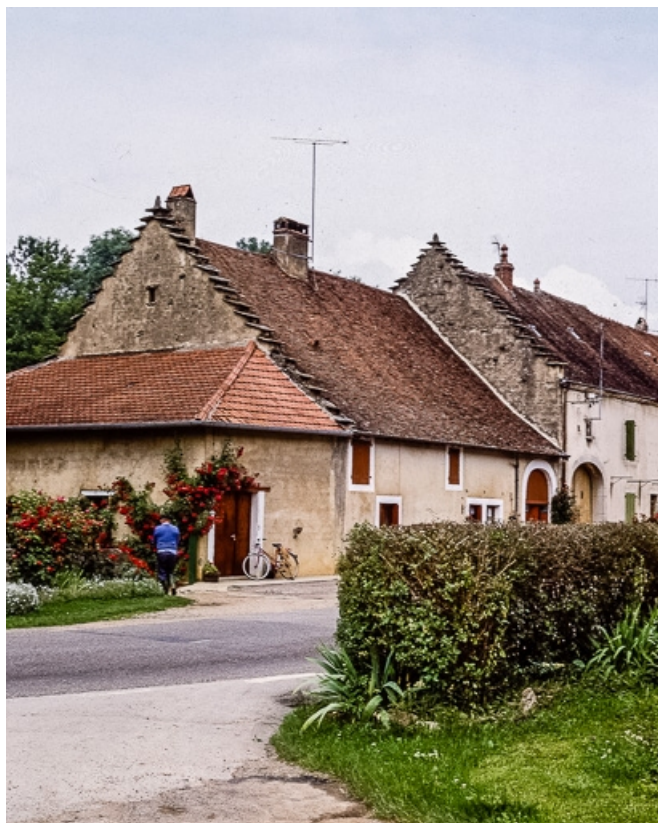
Maisons situées au centre du village. A noter les pignons à redents.
