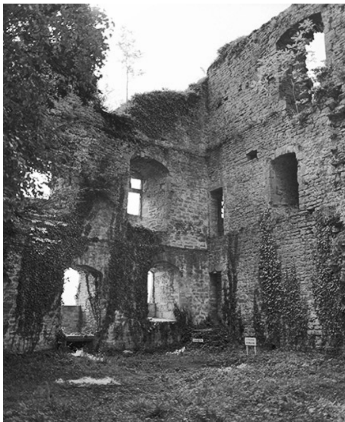
Le donjon, vue intérieure de l'angle sud-est.
