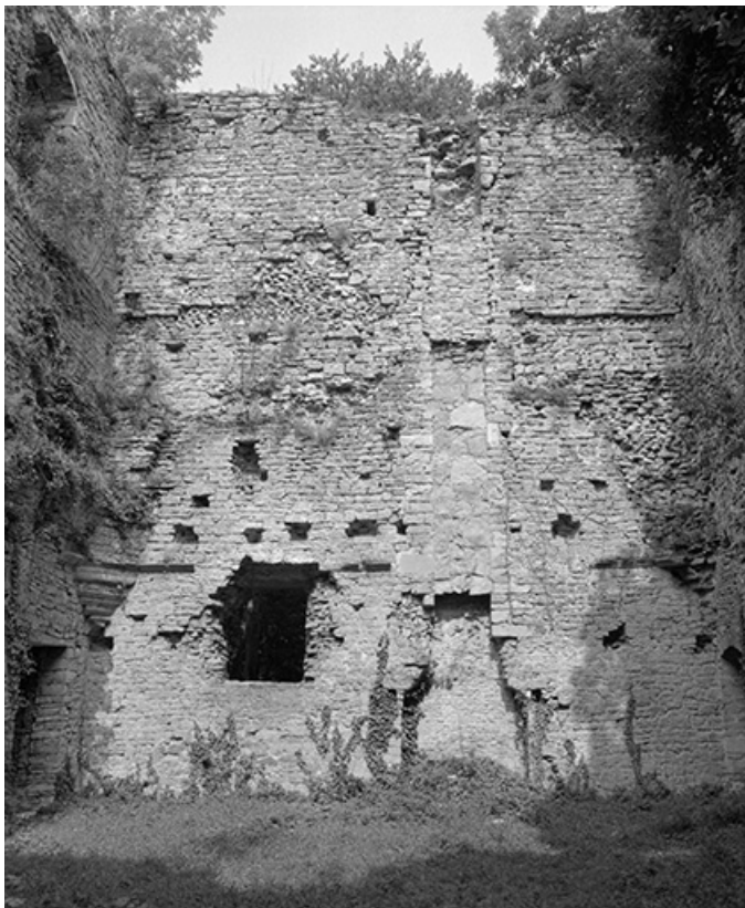
Le donjon, vue intérieure.
