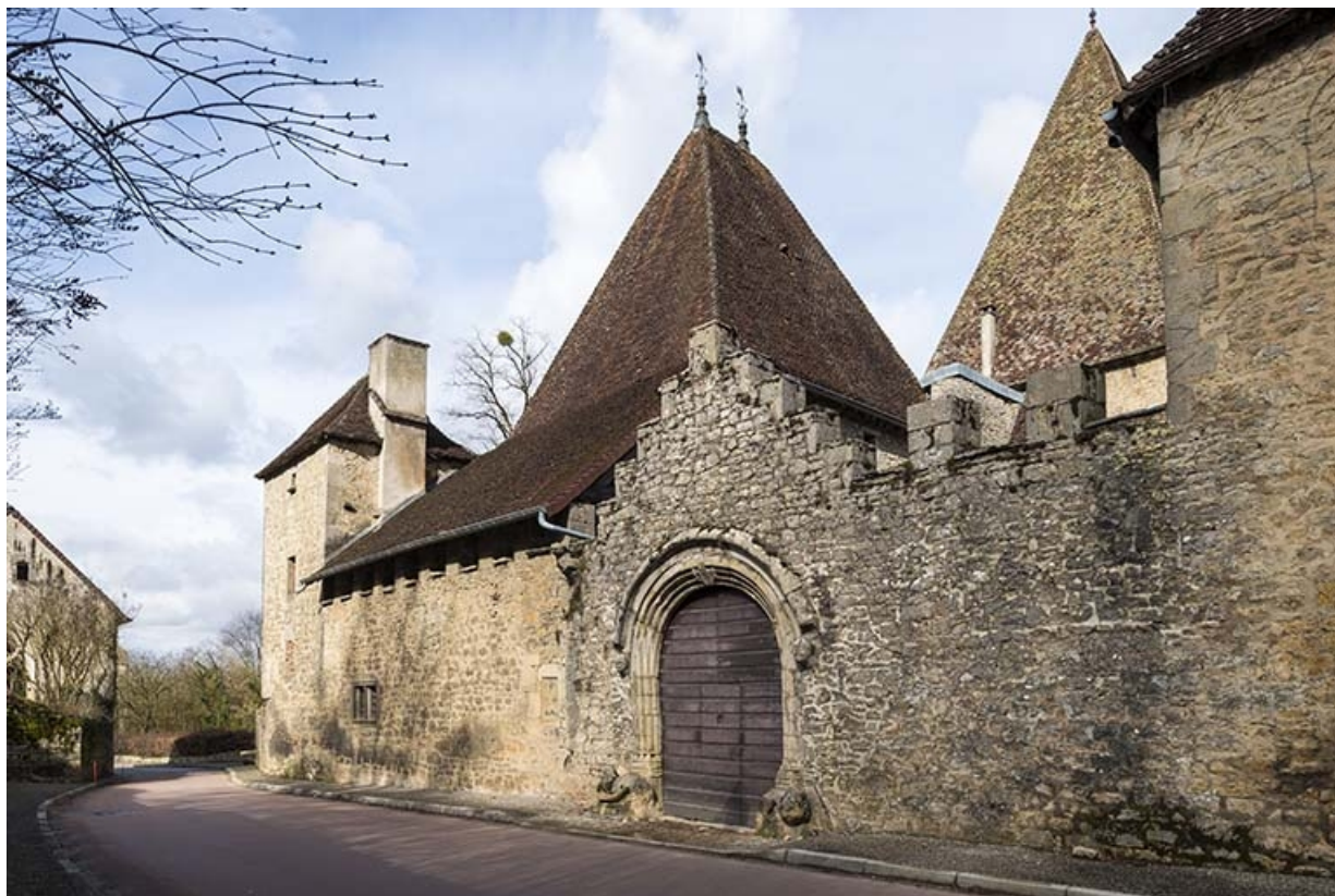
Portail d'entrée et mur d'enceinte en 2015.
