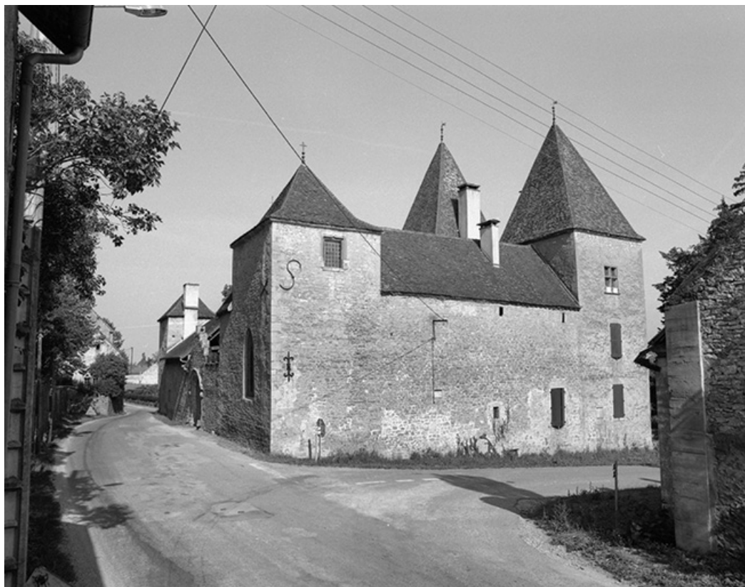
Façades antérieure et latérale droite en 1990.
