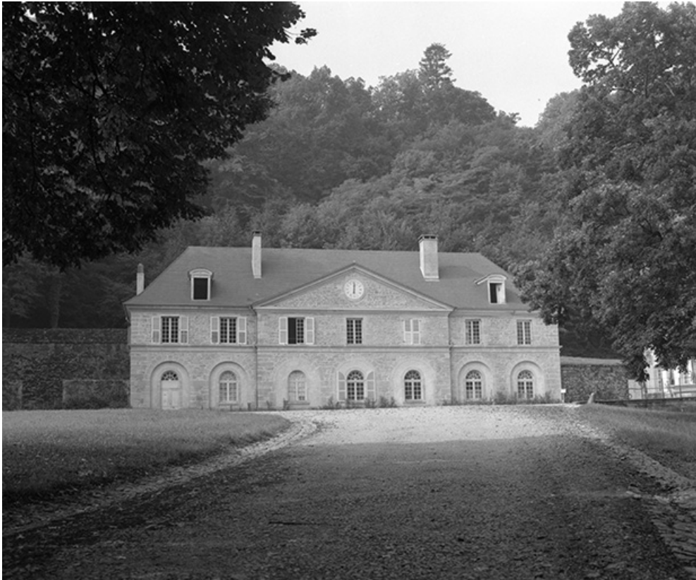
Pavillon gauche, façade antérieure.
