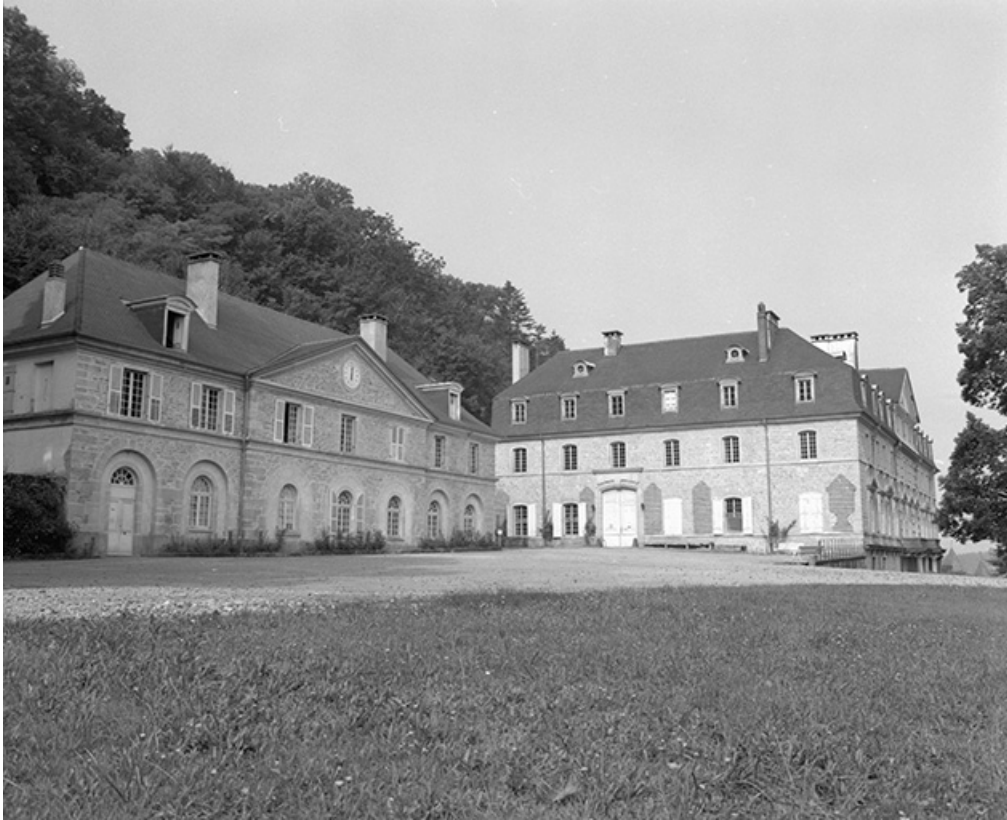
Pavillon gauche et bâtiment principal.
