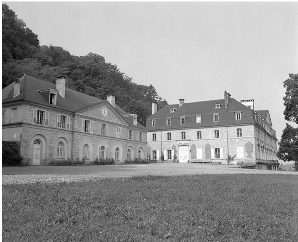
Pavillon gauche et bâtiment principal.
