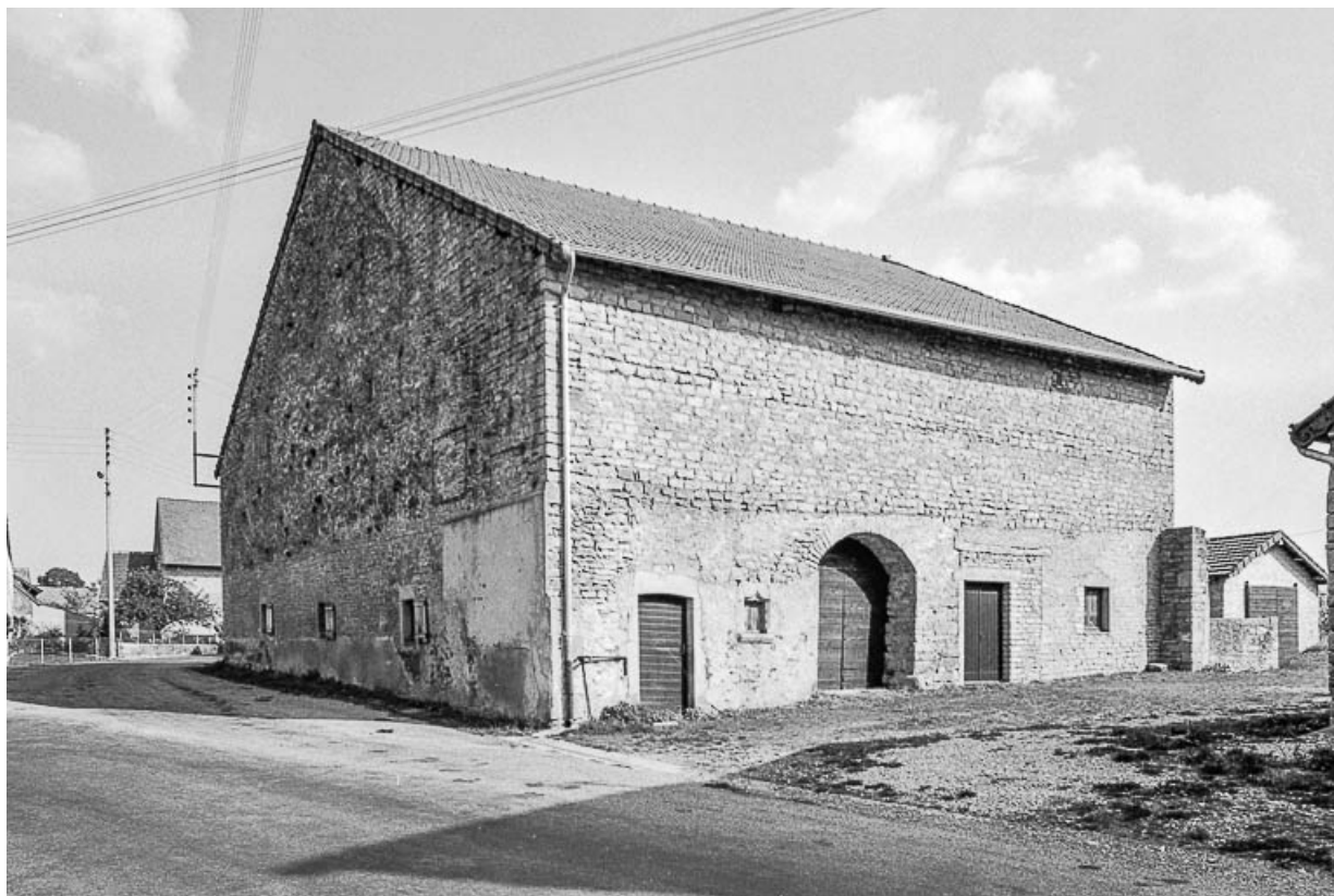
Ferme cadastrée A3 206 : façade postérieure. 39, Vevy
