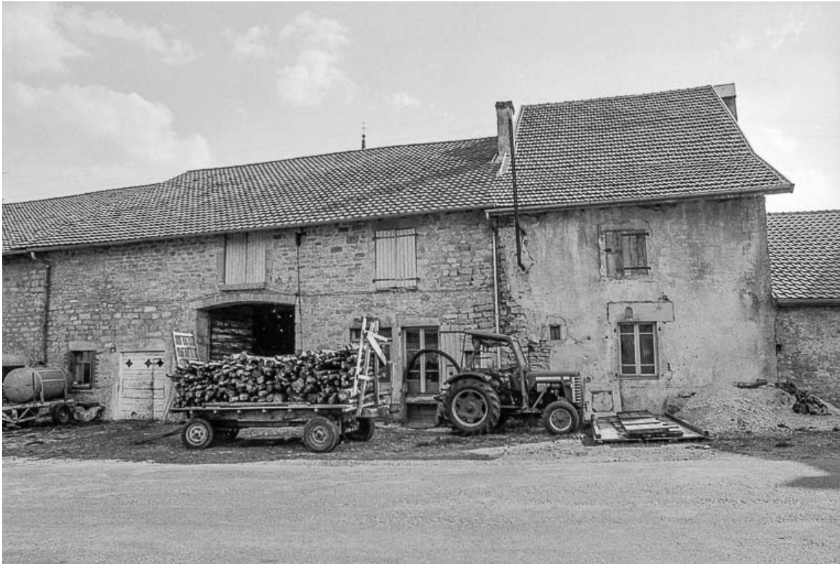
Ferme cadastrée A3 194 : façade antérieure. 39, Vevy
