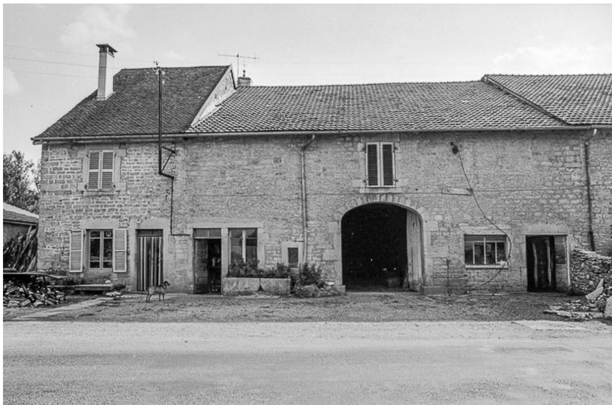
Ferme cadastrée A3 195 : façade antérieure.
