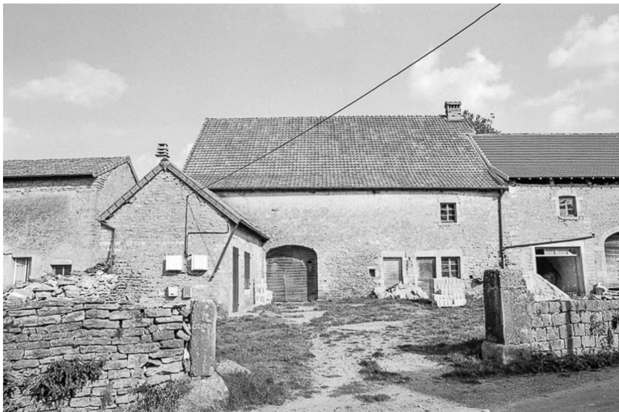
Ferme cadastrée B3 272 : façade antérieure et mur d'enclos. 39, Vevy
