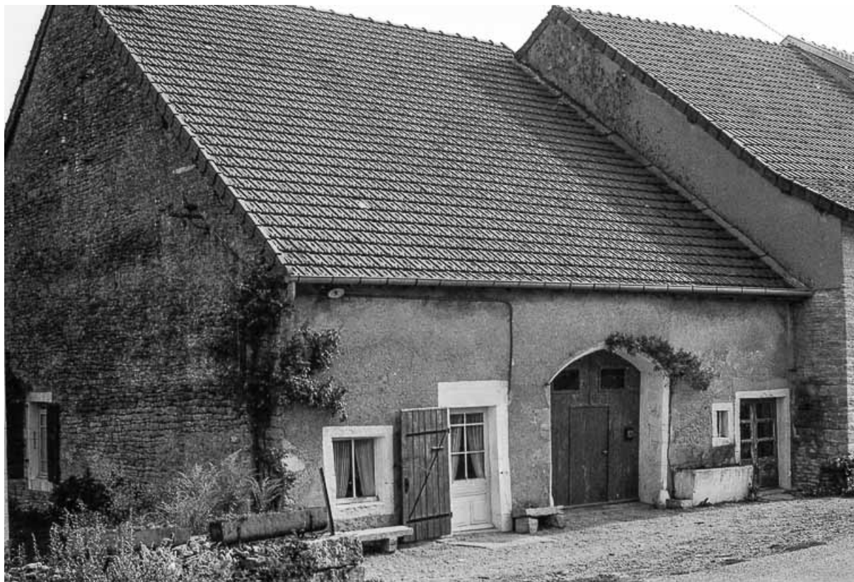
Ferme cadastrée A3 170 : façade antérieure. 39, Vevy
