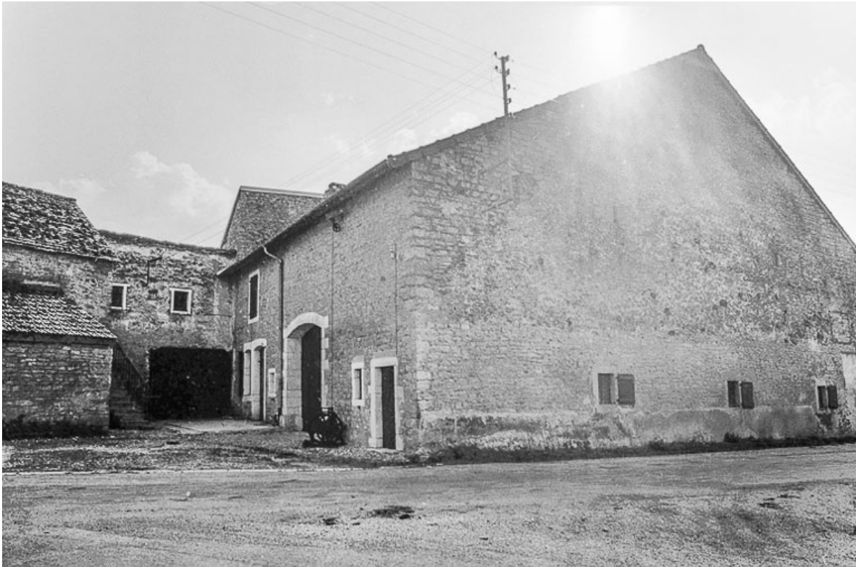
Ferme cadastrée A3 206 : façade antérieure. 39, Vevy
