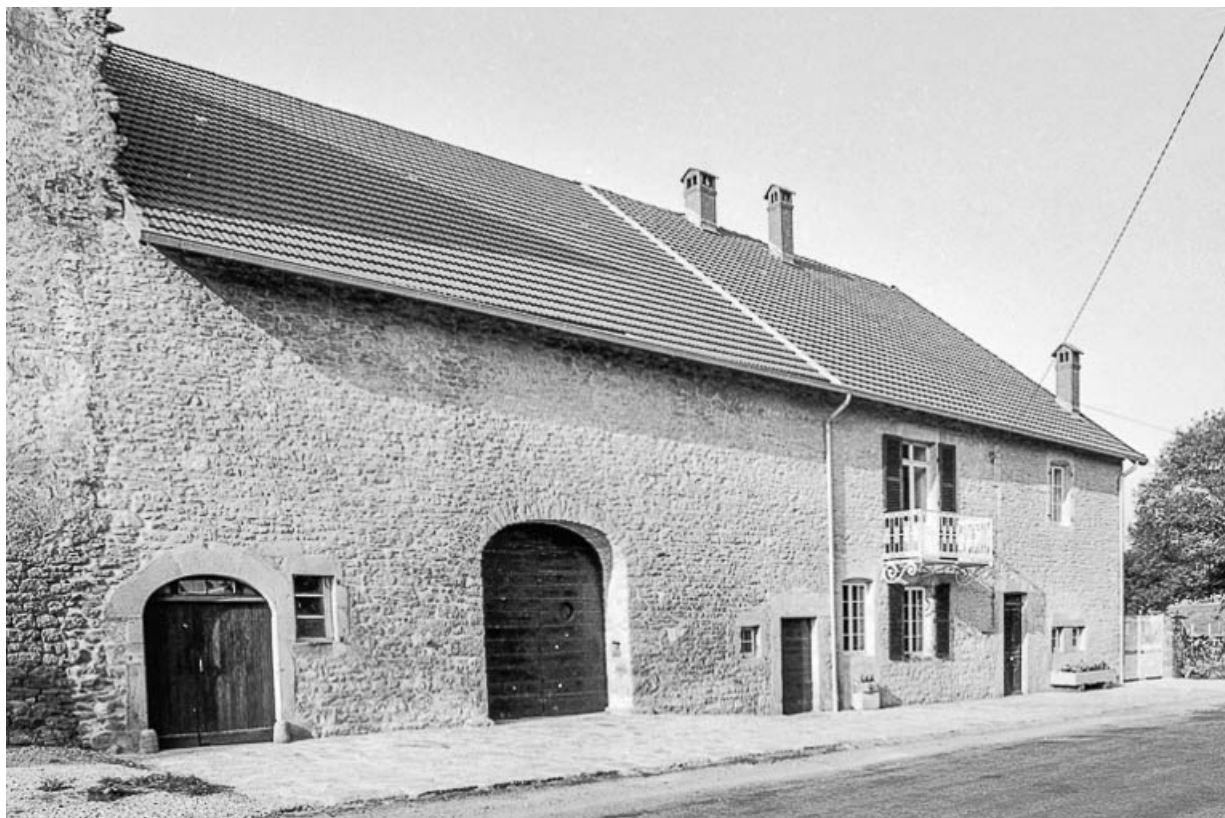
Ferme cadastrée A3 218 : façade antérieure. 39, Vevy
