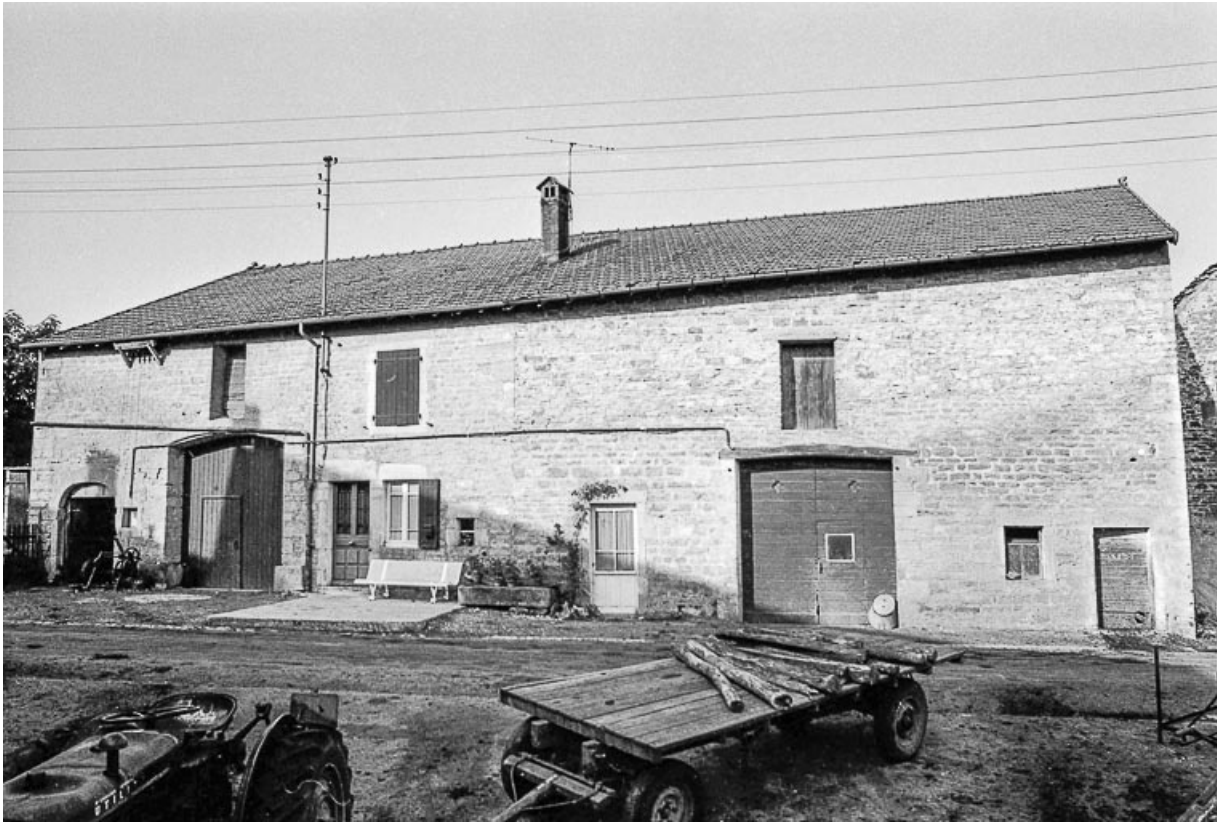
Ferme cadastrée A3 204 : façade antérieure. 39, Vevy
