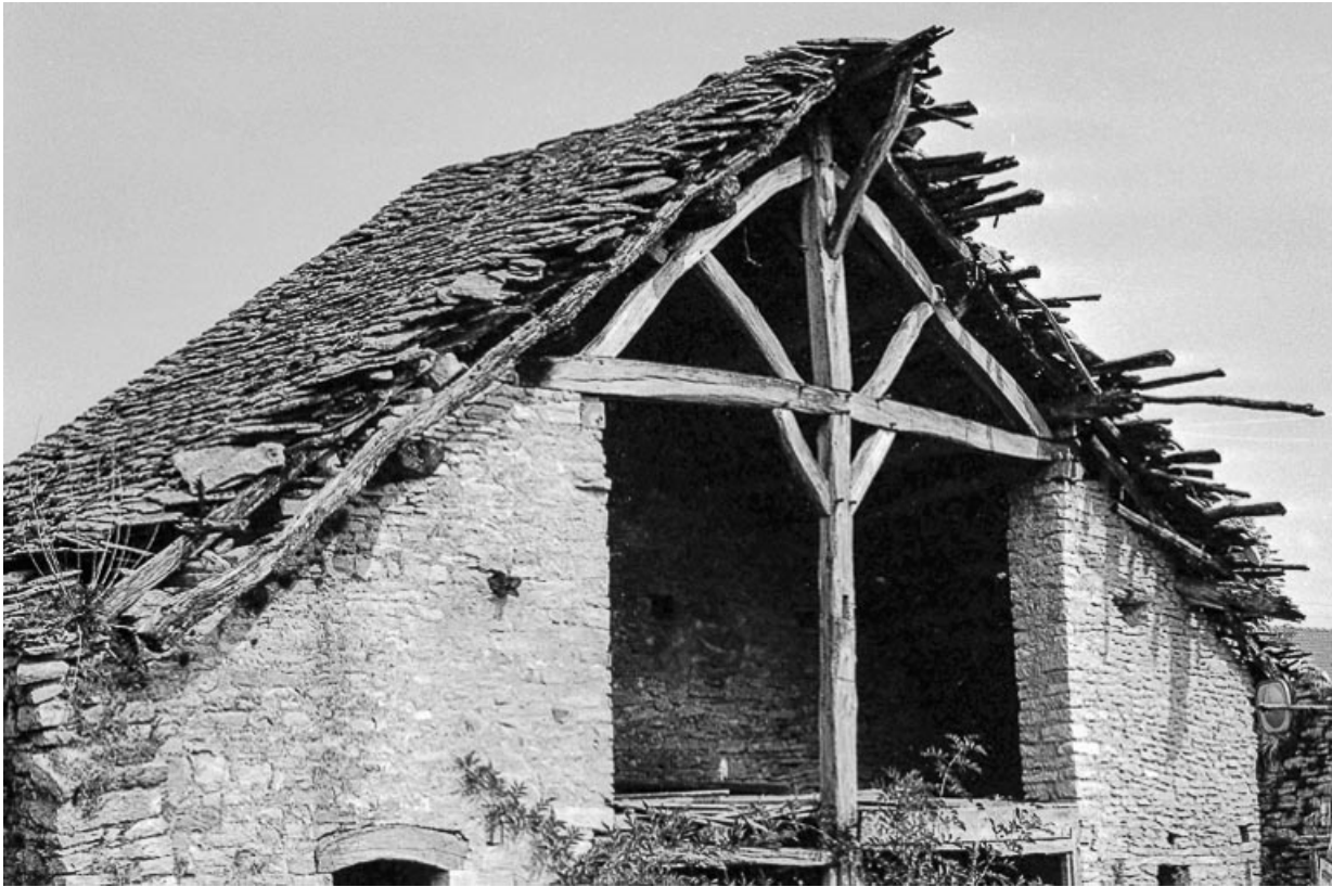
Ferme cadastrée B3 256 : toiture. 39, Vevy
