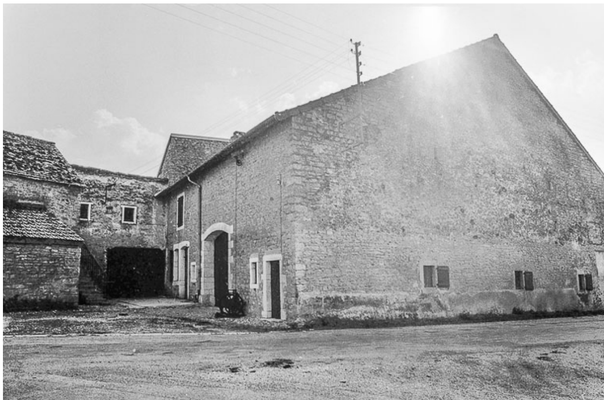
Ferme cadastrée A3 206 : façade antérieure.
