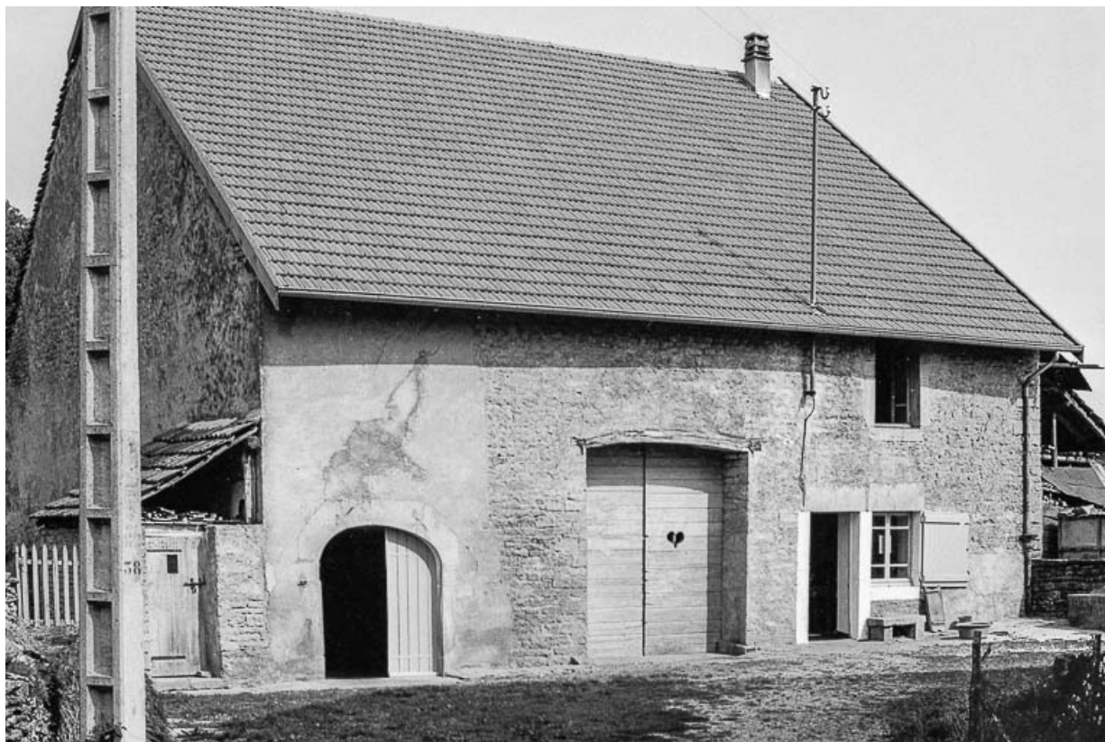
Ferme cadastrée B3 274 : façade antérieure. 39, Vevy
