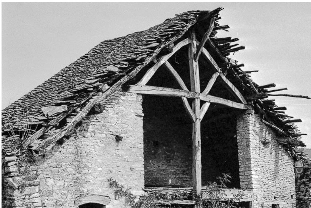
Ferme cadastrée B3 256 : toiture.
