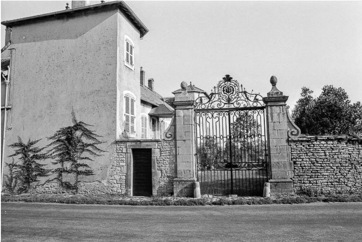
Portail d'entrée sur la cour et façade antérieure.
