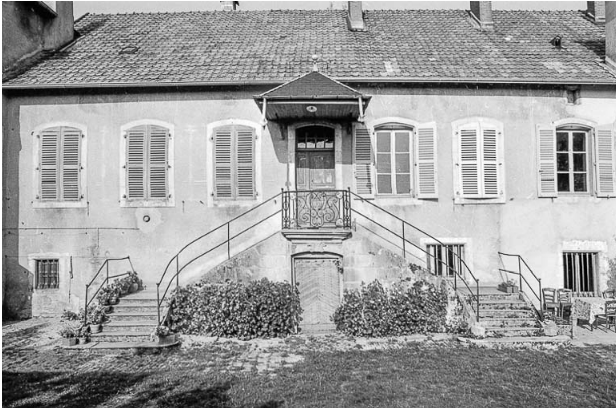
Façade antérieure et escalier à double volée.
