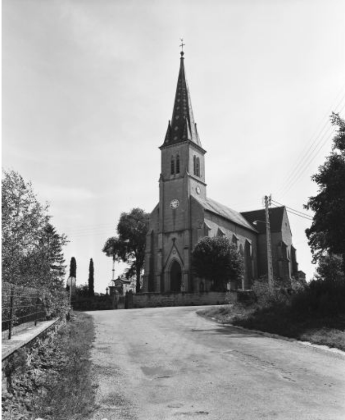
Façades antérieure et latérale droite.
