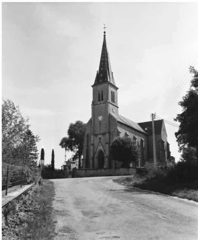
Façades antérieure et latérale droite.
