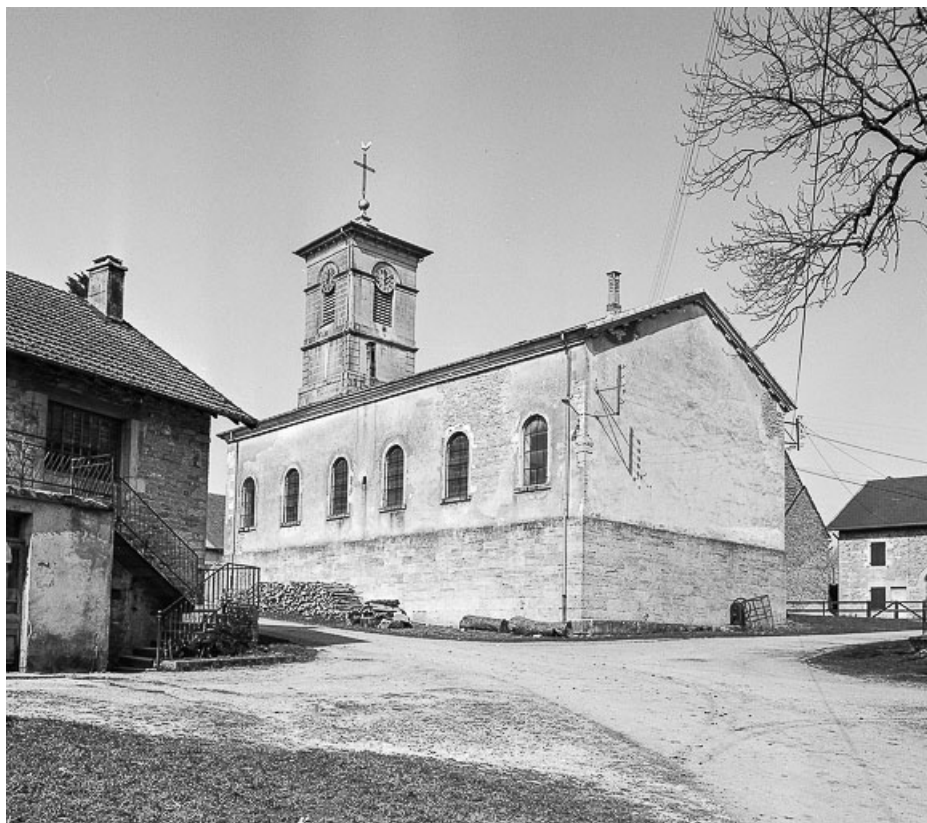
Extérieur : face latérale droite et chevet.
