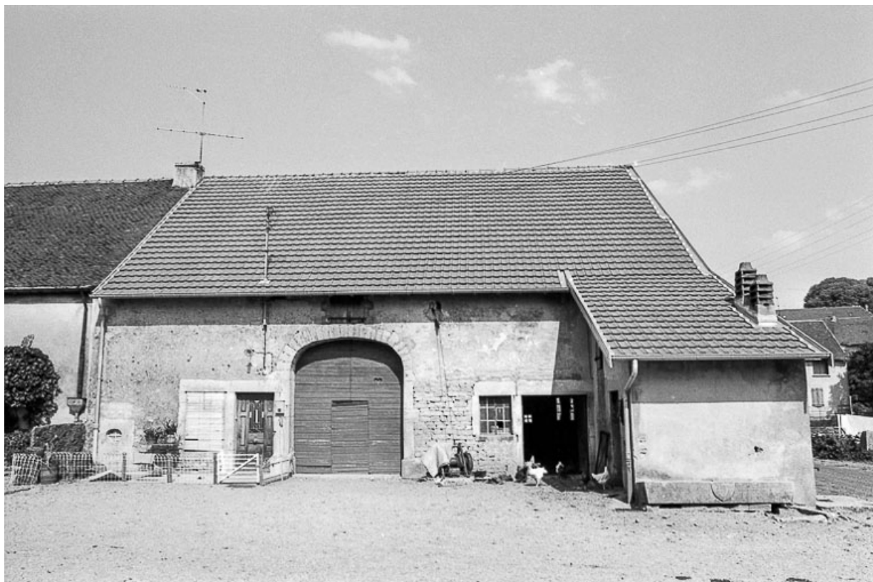
Ferme cadastrée D2 214 : façade antérieure.
