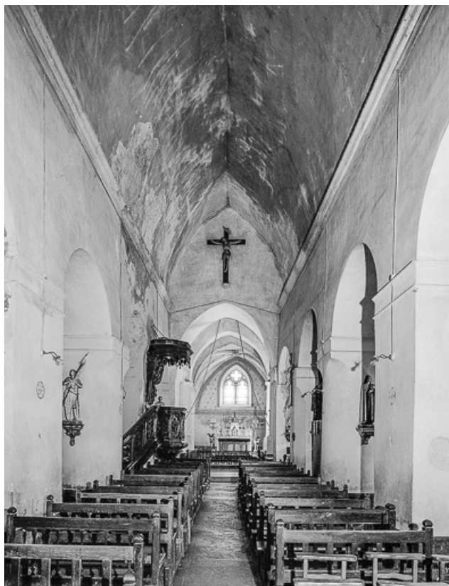
Intérieur : nef vue depuis l'entrée.
