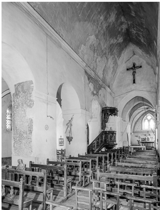
Intérieur : nef, élévation gauche.
