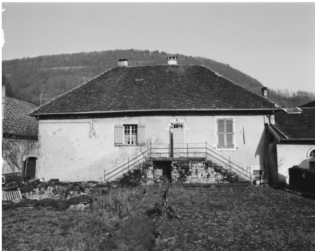
Façade antérieure vue de face.
