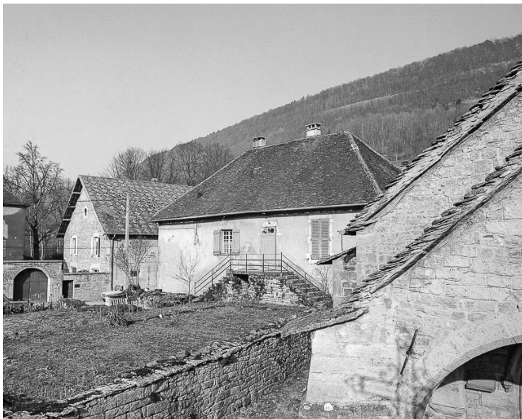
Façade antérieure : trois quarts droit.
