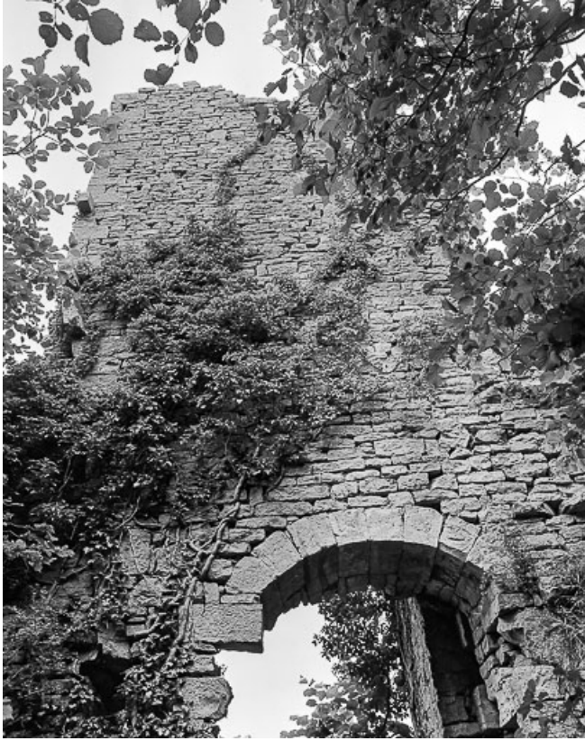
Vue extérieure du donjon.
