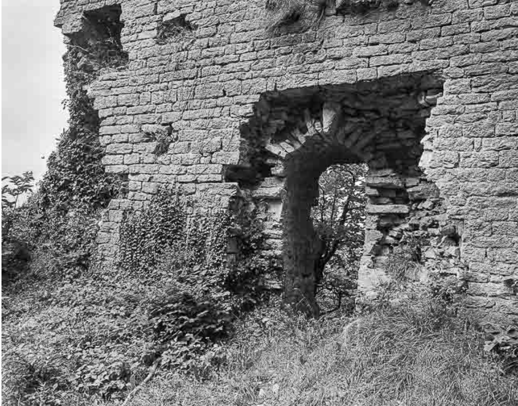
Vue extérieure du donjon : détail d'une porte.
