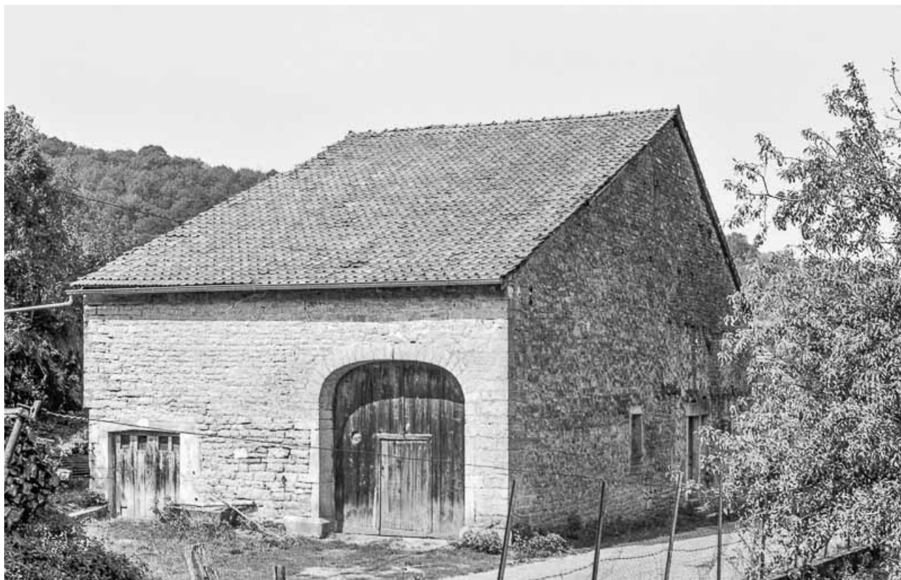
ferme cadastrée ZK 65 : façade latérale gauche.
