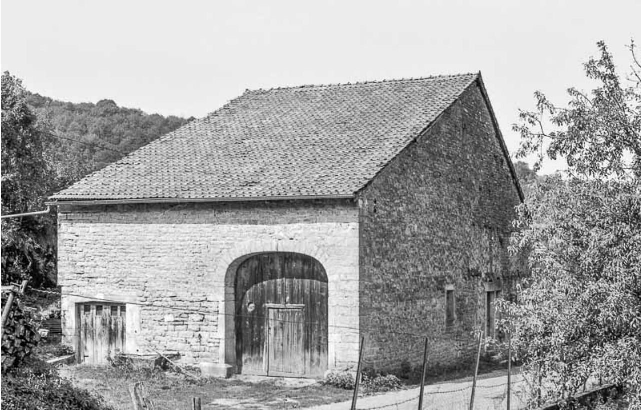
ferme cadastrée ZK 65 : façade latérale gauche.
