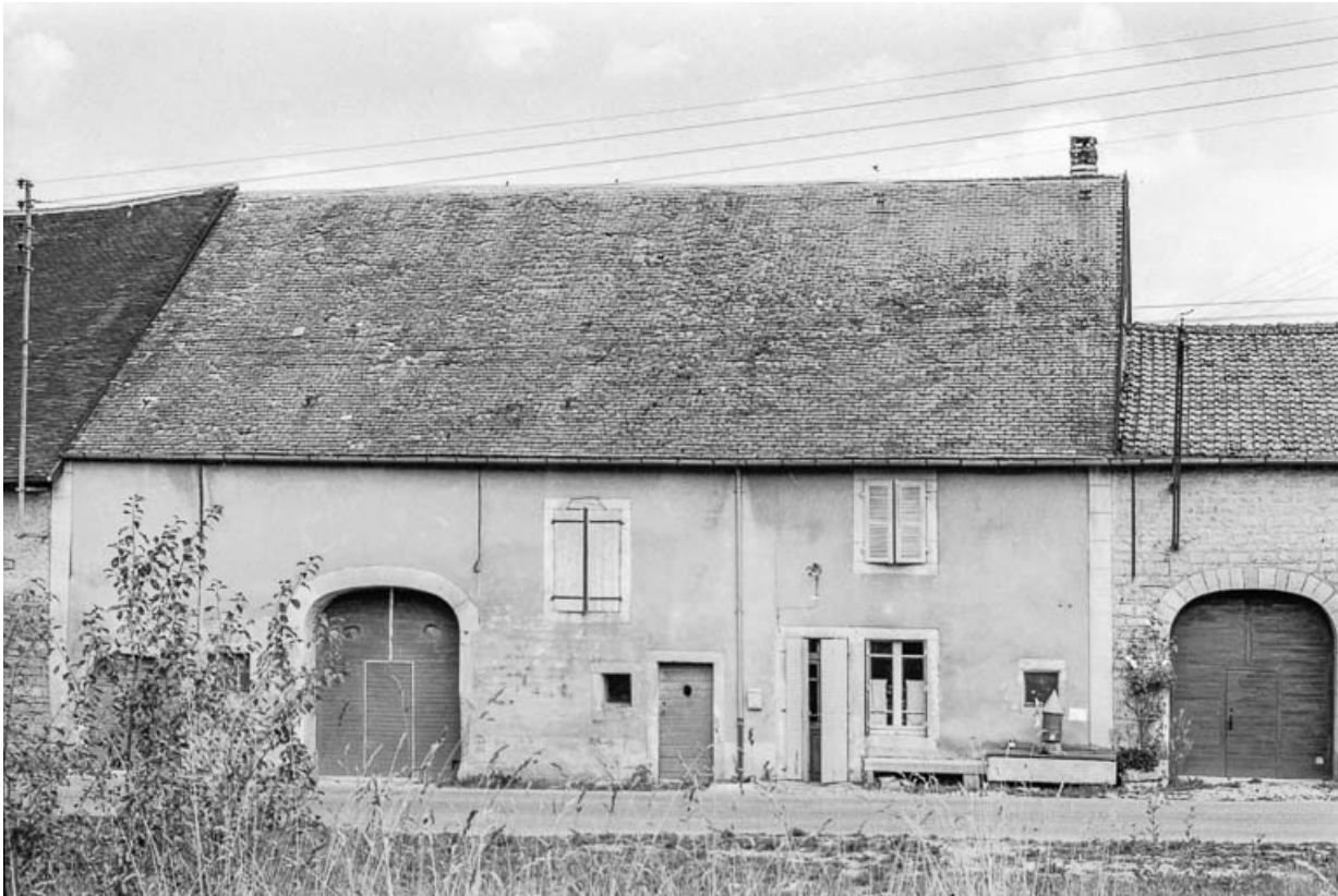
Façade antérieure : vue rapprochée.
