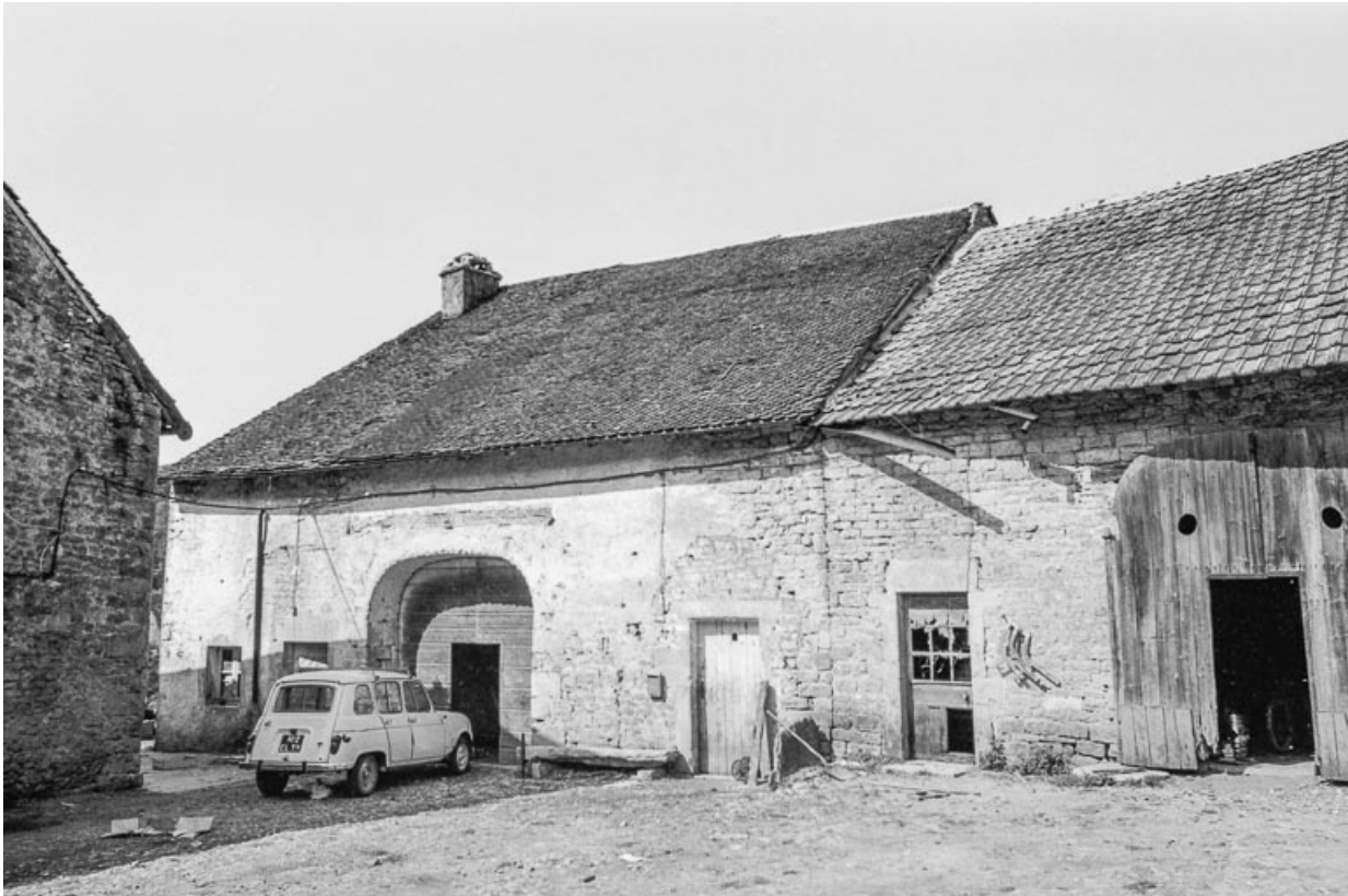
Ferme cadastrée ZK 40 : façade postérieure. 39, Publy
