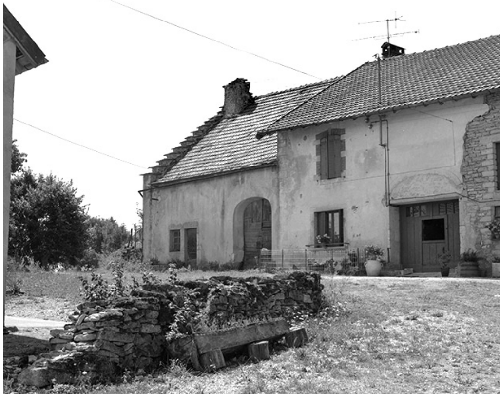
Façade antérieure. 39, Publy La Ruelle
