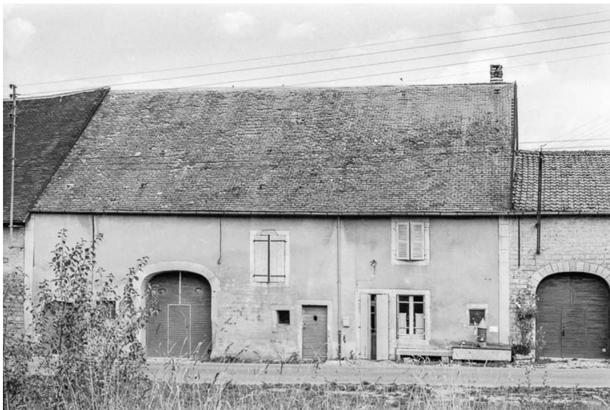
Façade antérieure : vue rapprochée.
