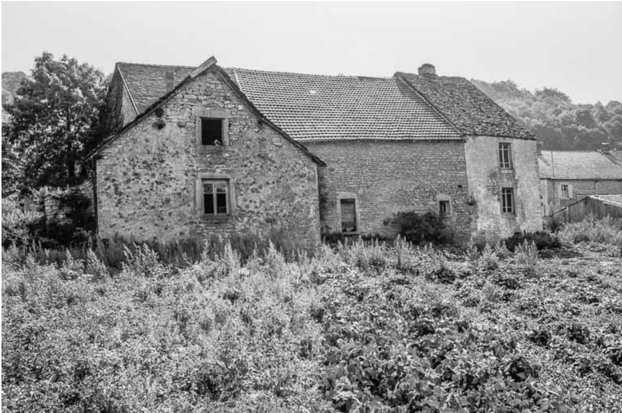
Ferme cadastrée ZK 40 : façade postérieure. 39, Publy
