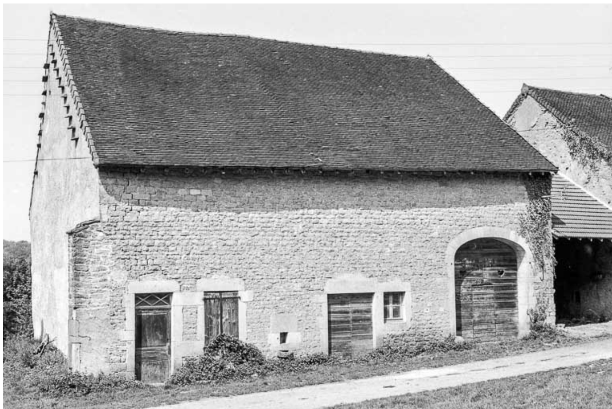
Ferme cadastrée ZK 35 : façade antérieure. 39, Publy
