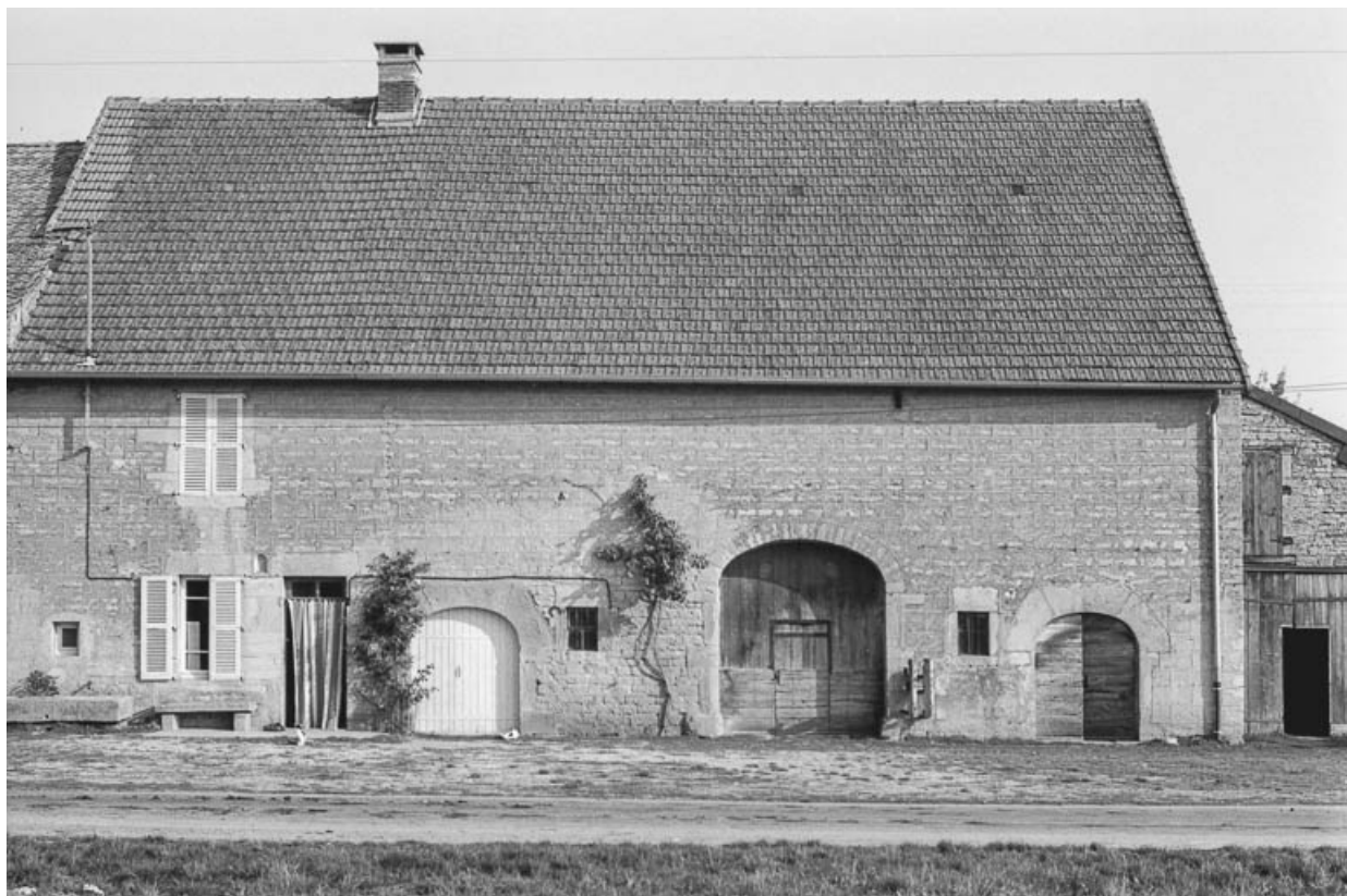
Ferme cadastrée A3 564 : façade antérieure.
