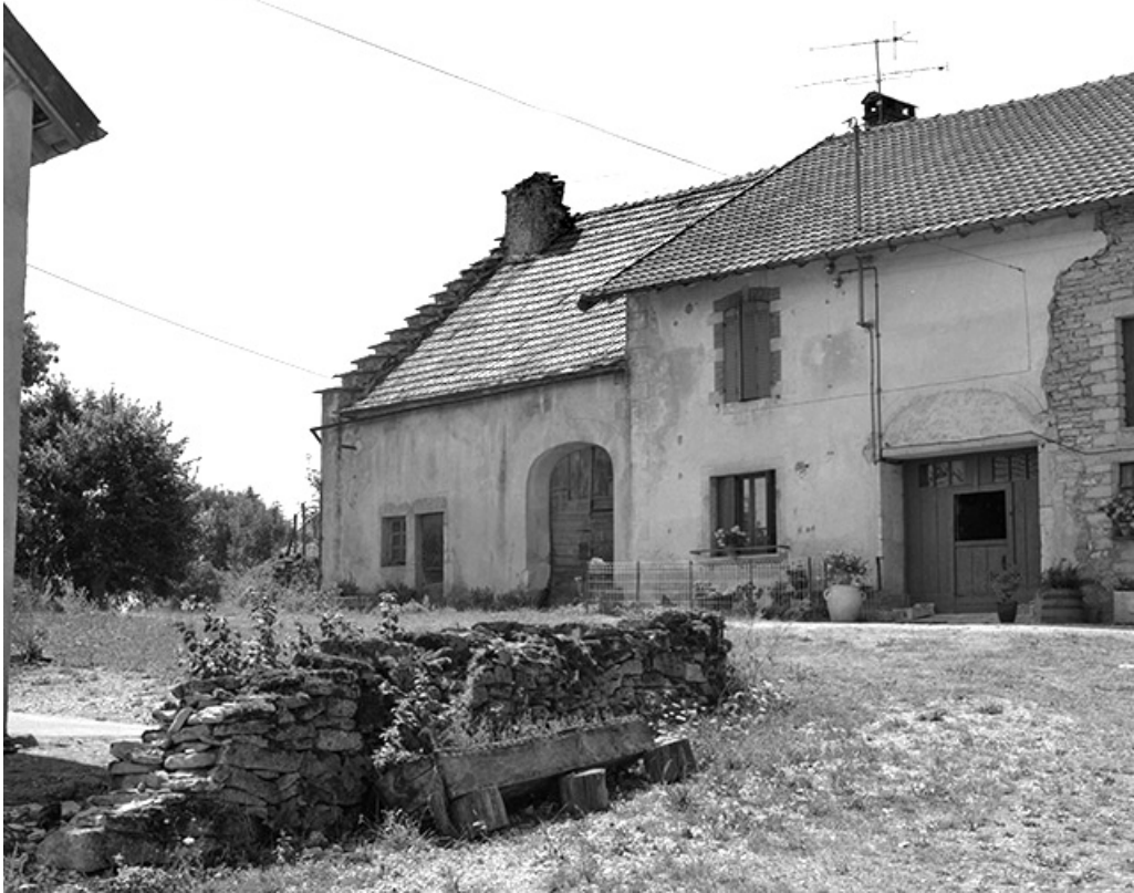
Façade antérieure. 39, Publy La Ruelle
