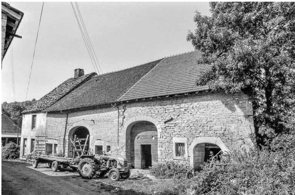
Ferme cadastrée ZK 40 : façade antérieure. 39, Publy
