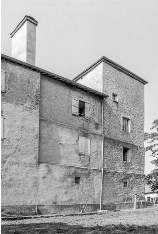
Face nord (la tour).
