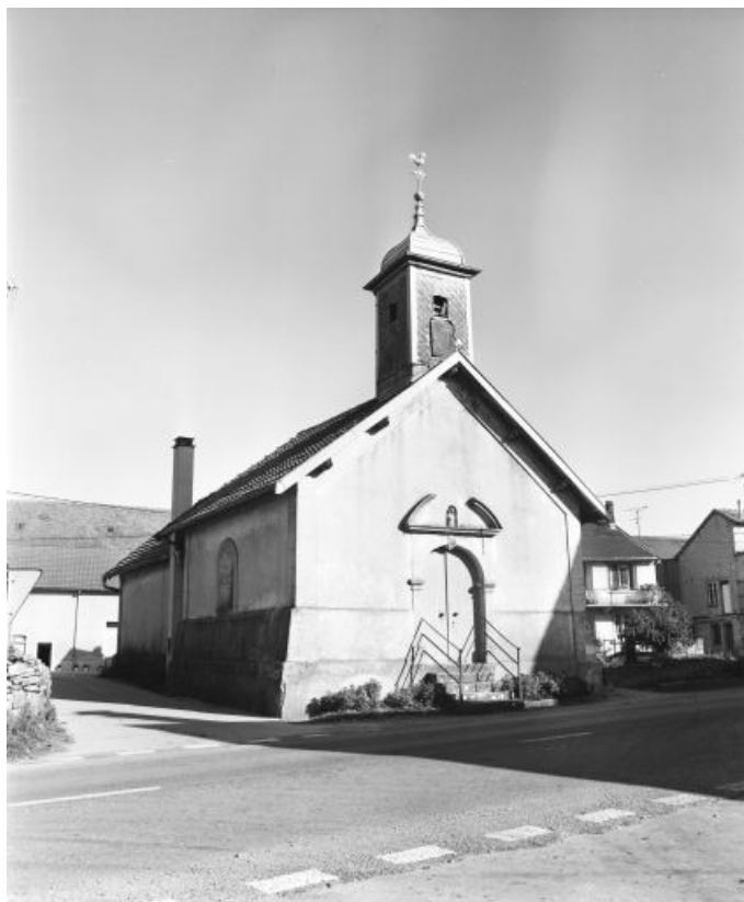
Vue de la façade antérieure.
