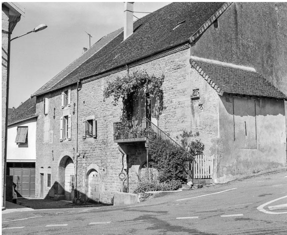
Face postérieure : vue de trois quarts droit. 39, Perrigny
