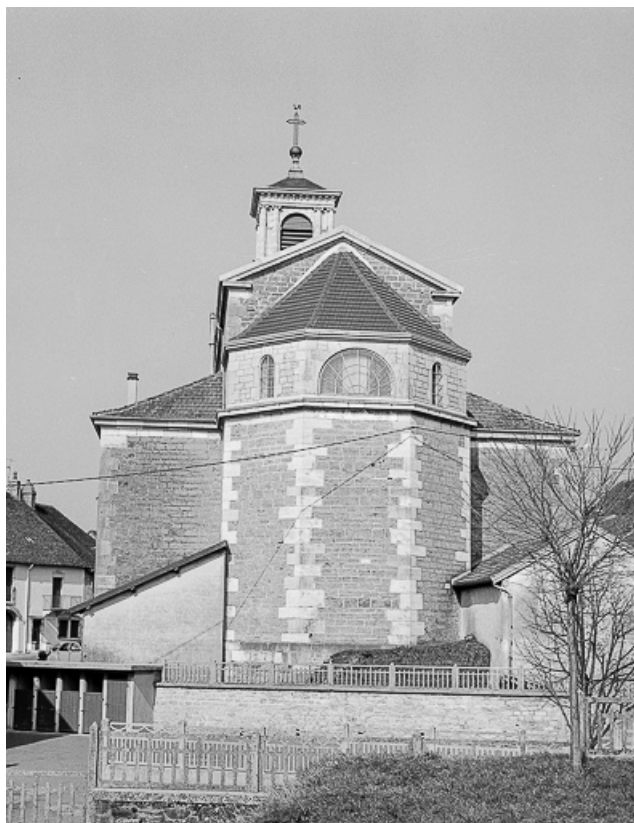
Extérieur : abside vue de face.
