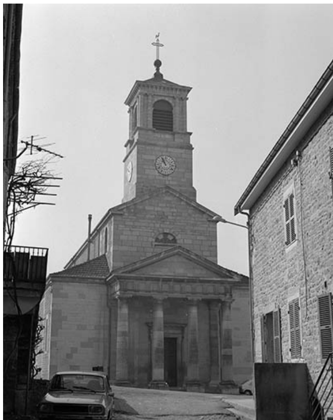
Extérieur : façade antérieure.
