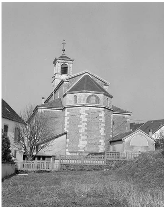
Extérieur : abside vue de trois quarts.
