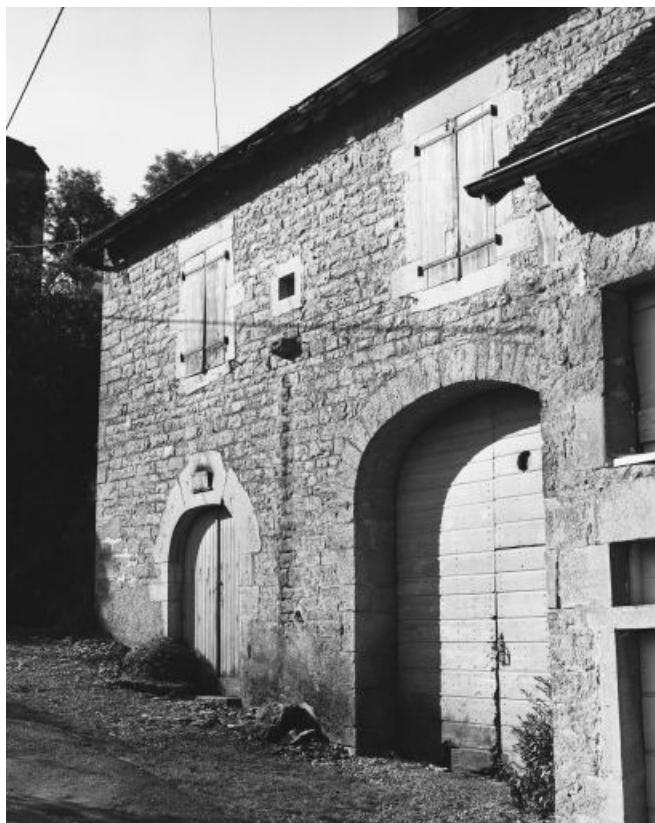
Façade antérieure de trois quarts droit. 39, Pannessières chemin des Vieux Monts
