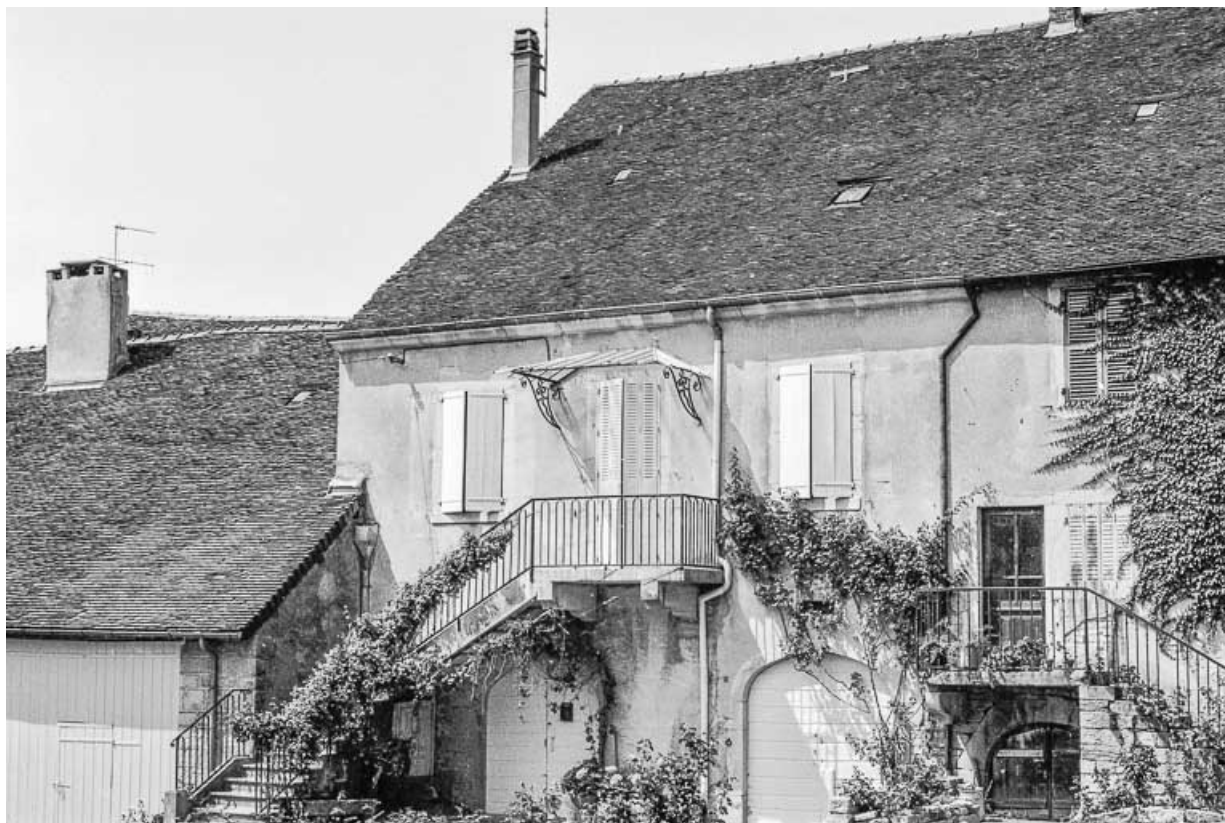
Façade antérieure : vue rapprochée.
