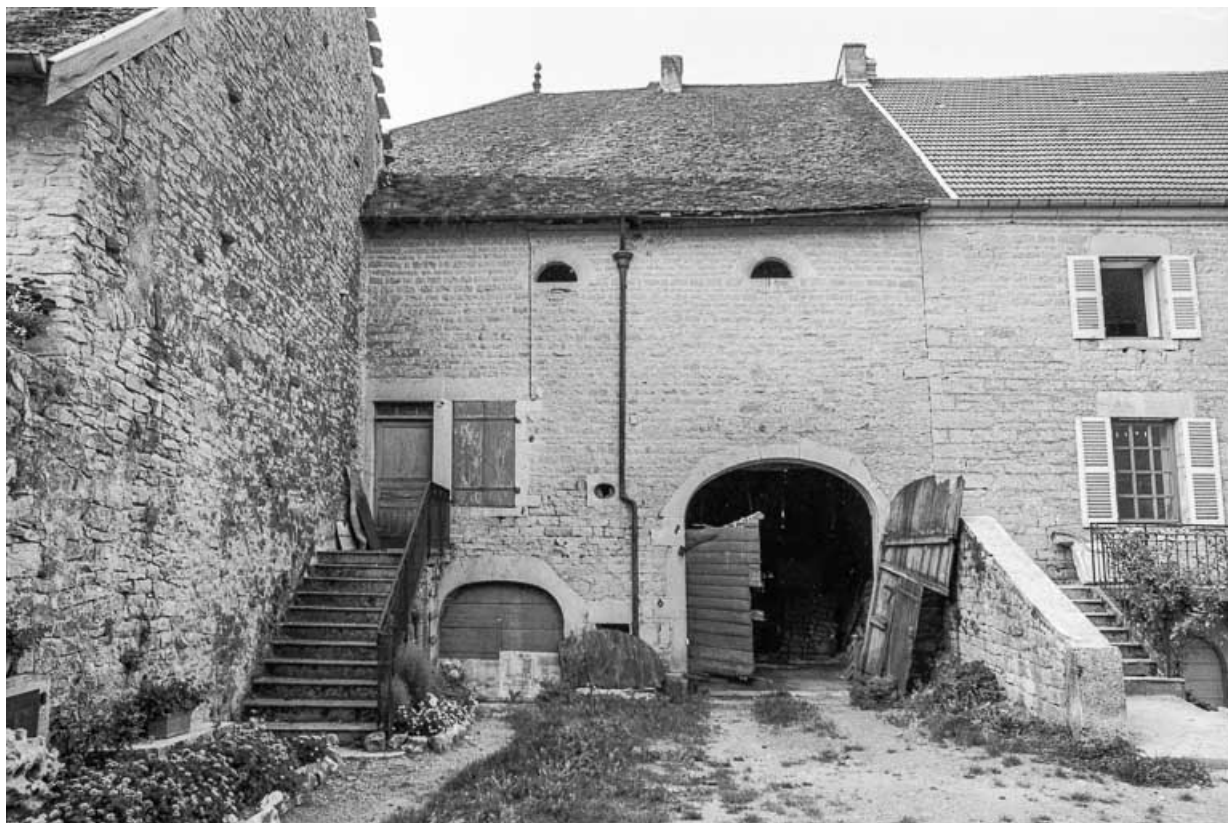
Ferme cadastrée AD 324 : façade antérieure. 39, Pannessières
