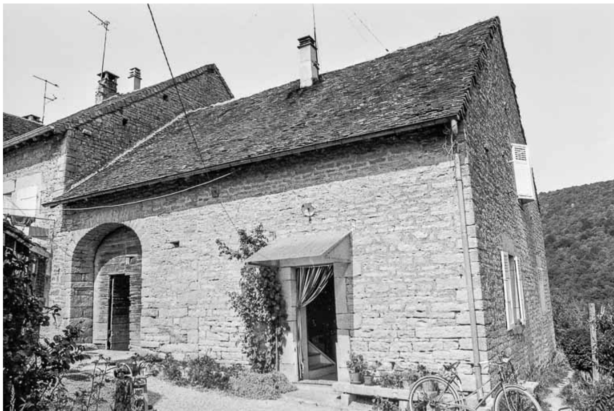
Maison cadastrée AD 109 : façades antérieure et latérale droite.
