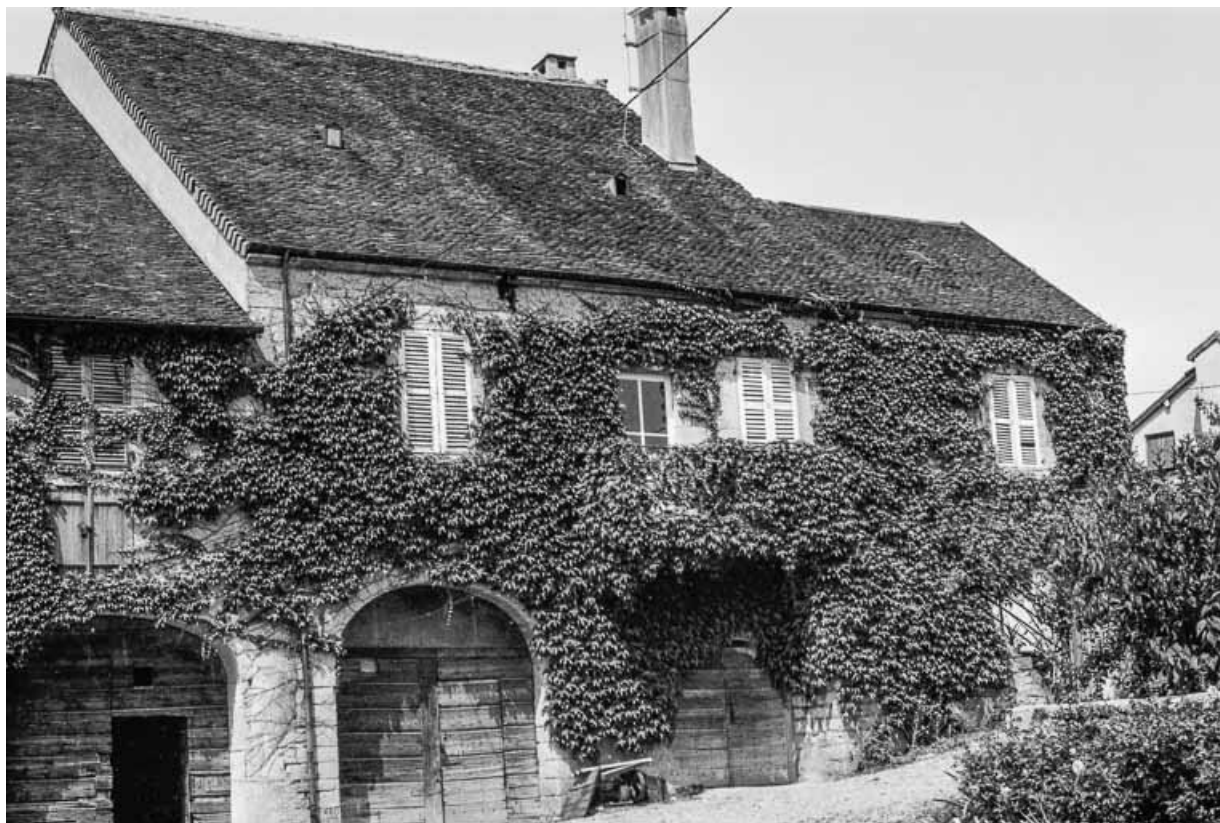
Maison de vigneron cadastrée AD 44 : façade antérieure. 39, Pannessières
