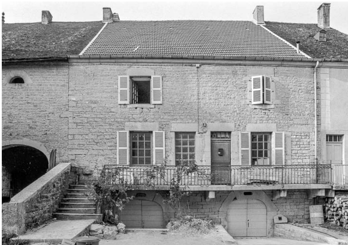
Maison de vigneron (?) cadastrée AD 325 : façade antérieure. 39, Pannessières
