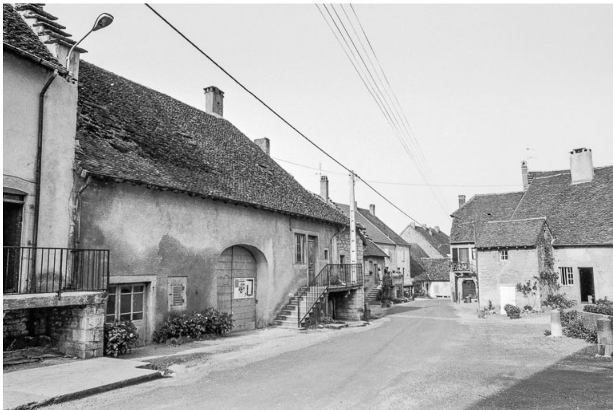
Vue générale de la rue principale.
