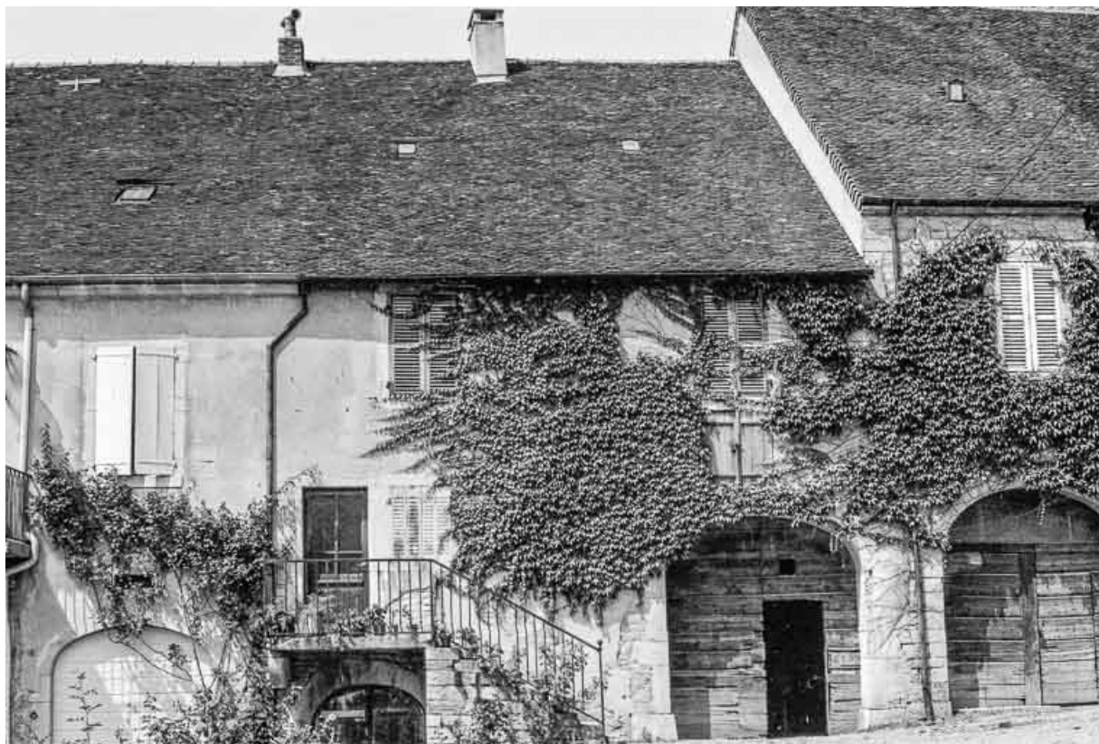
Maison de vigneron cadastrée AD 43 : façade antérieure. 39, Pannessières
