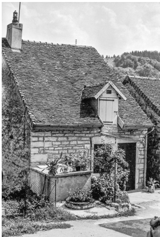
Maison cadastrée AD 114 : façade antérieure.
