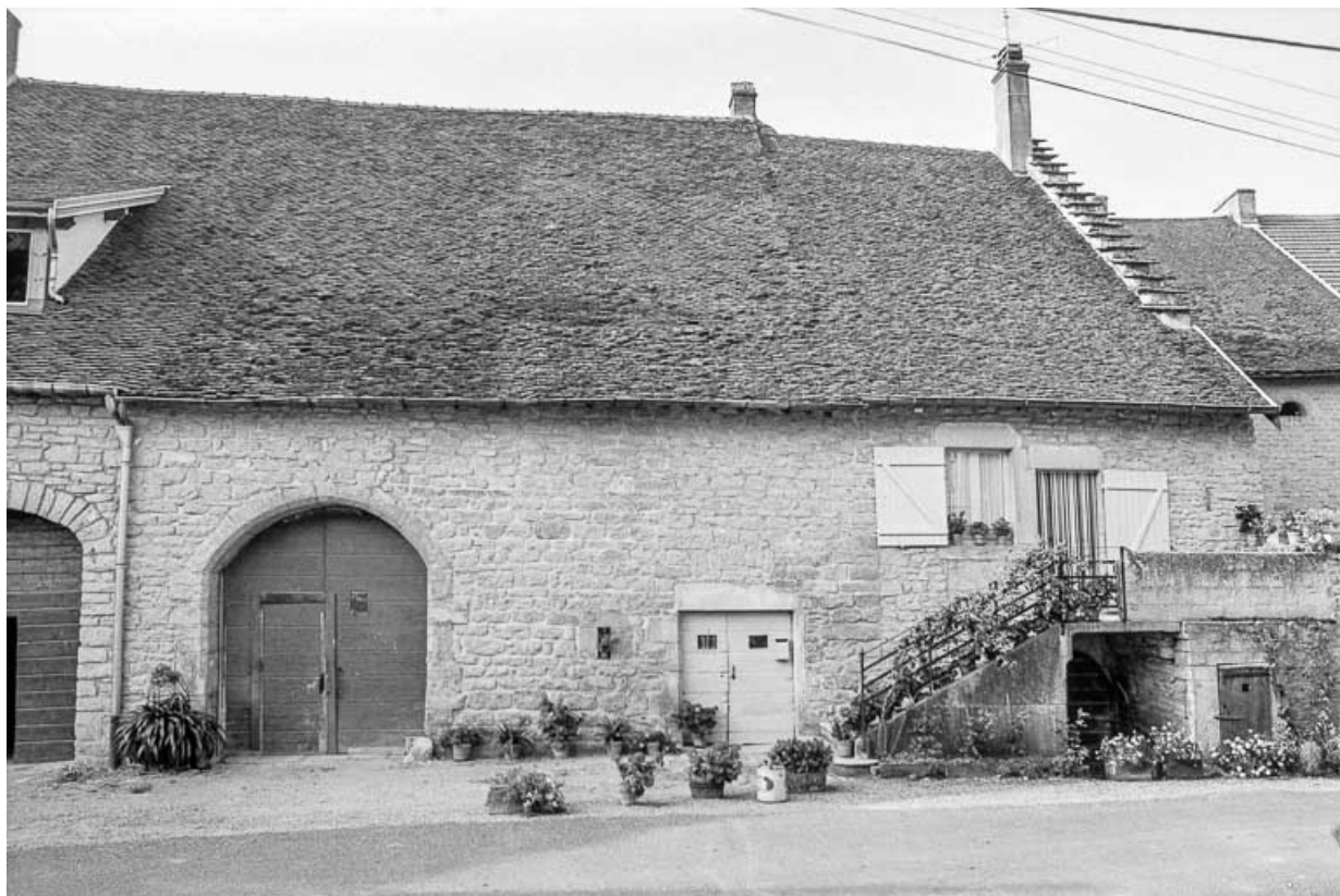
Ferme cadastrée AD 323 : façade antérieure. 39, Pannessières
