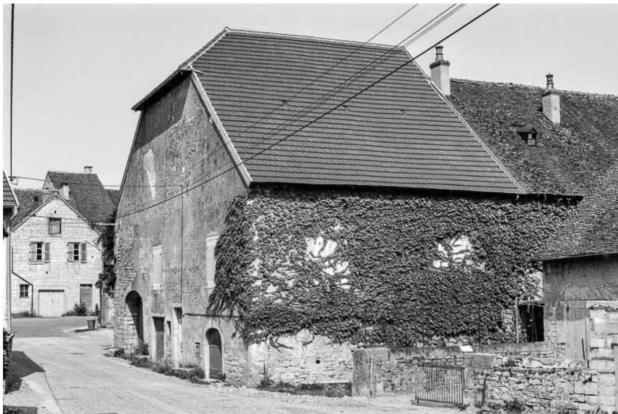
Ferme cadastrée AD 156 : façades antérieure et latérale droite. 39, Pannessières
