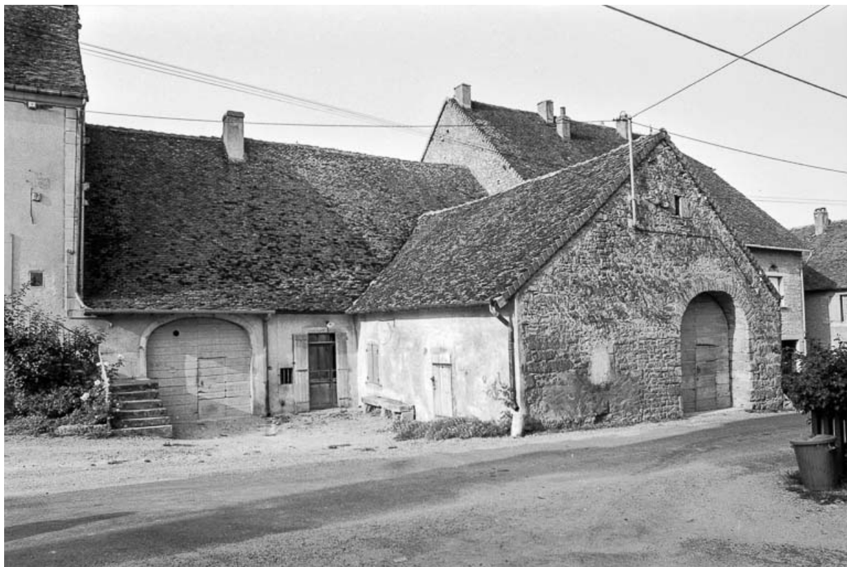
Ferme cadastrée AD 327 : façades antérieures.
