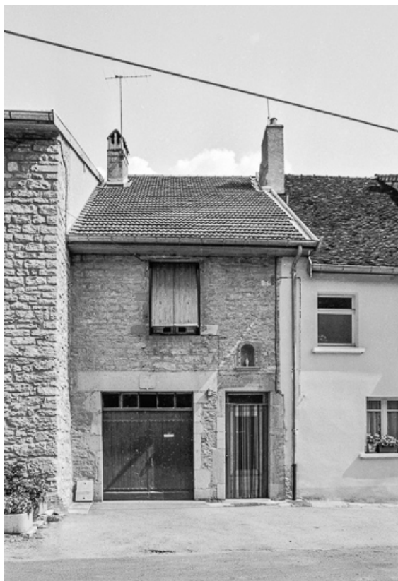
Maison cadastrée AD 140 : façade antérieure.
