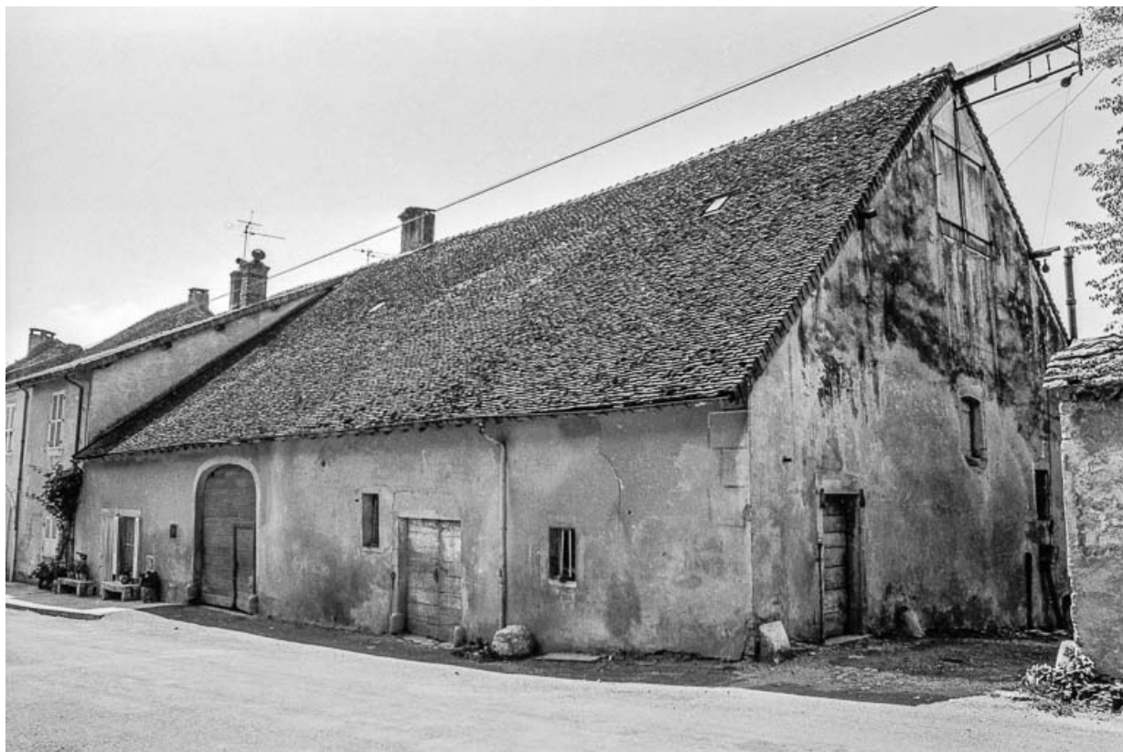
ferme cadastrée AD 306 : façades antérieure et latérale droite. 39, Pannessières
