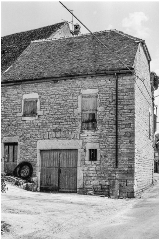
Maison cadastrée AD 39 : façades antérieure et latérale droite. 39, Pannessières
