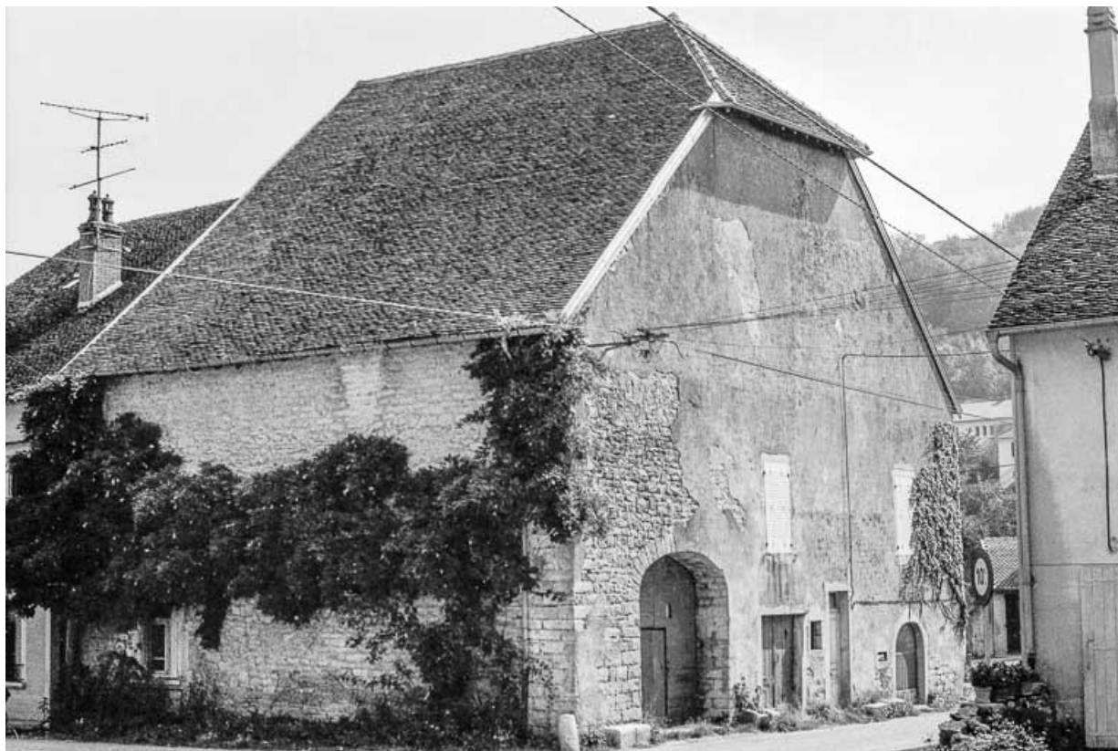
Ferme cadastrée AD 156 : façades antérieure et latérale gauche. 39, Pannessières
