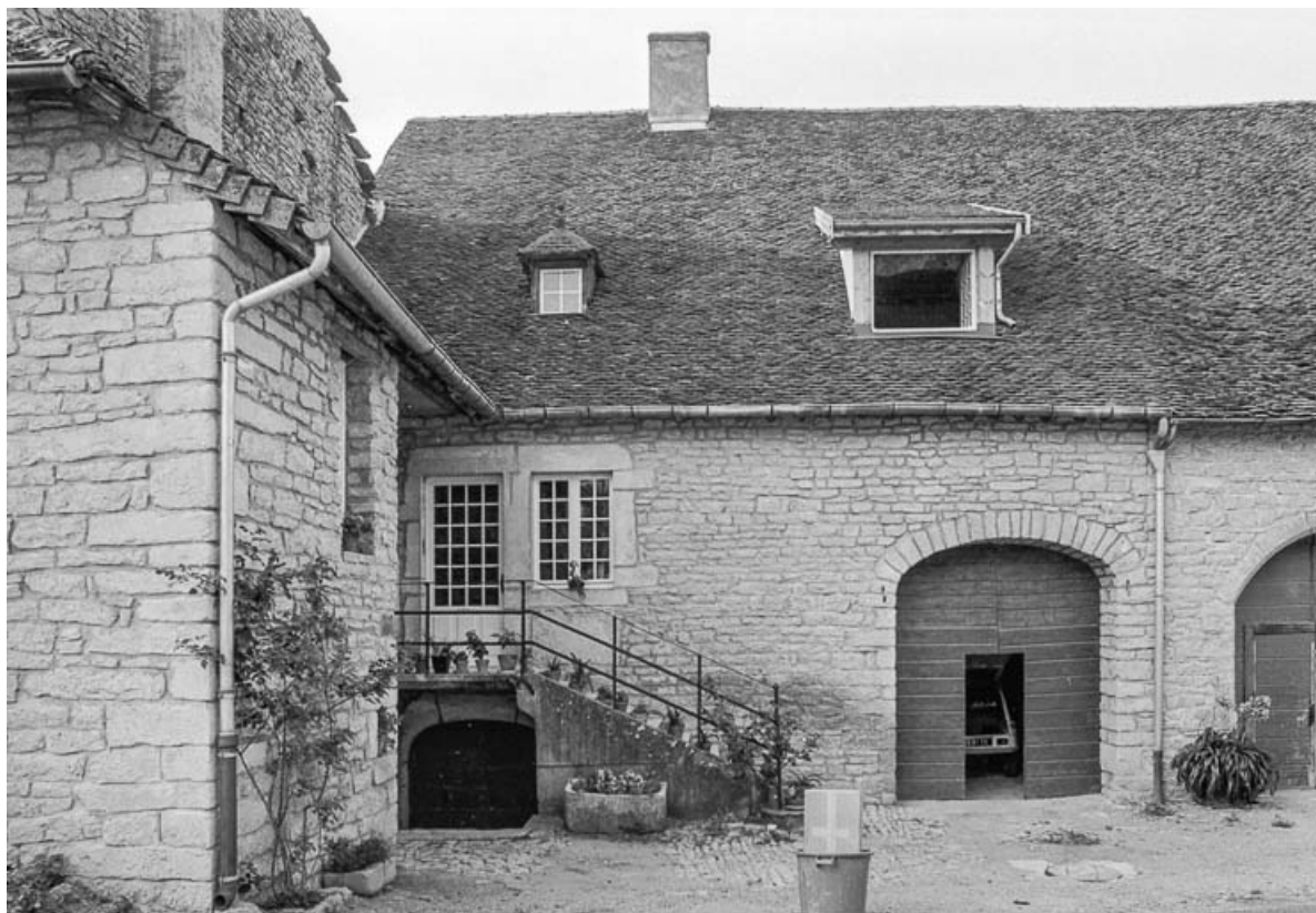
Ferme cadastrée AD 322 : façade antérieure. 39, Pannessières
