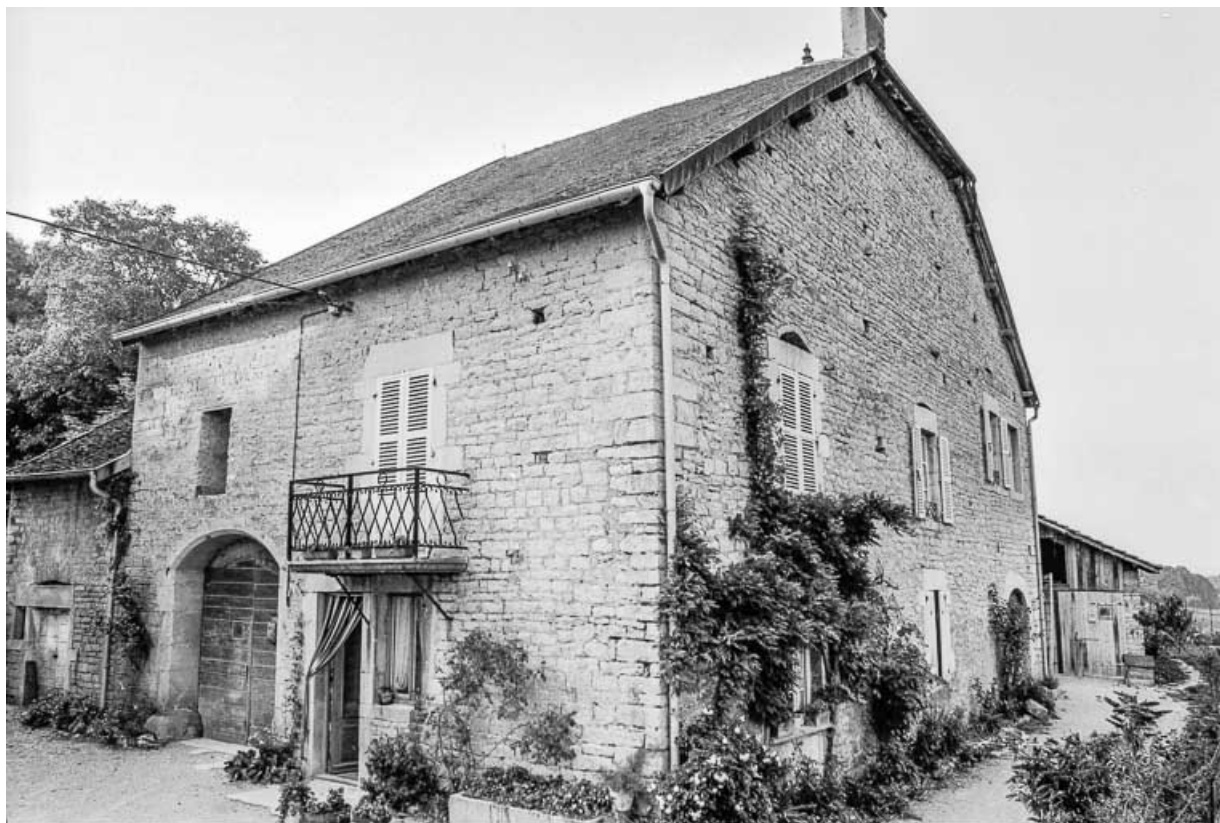
Ferme cadastrée AD 258 : façades antérieure et latérale droite. 39, Pannessières
