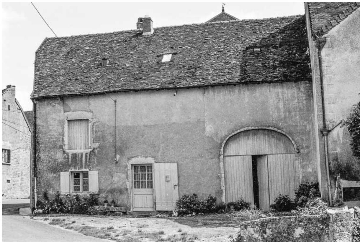
Ferme cadastrée AD 329 : façade antérieure. 39, Pannessières
