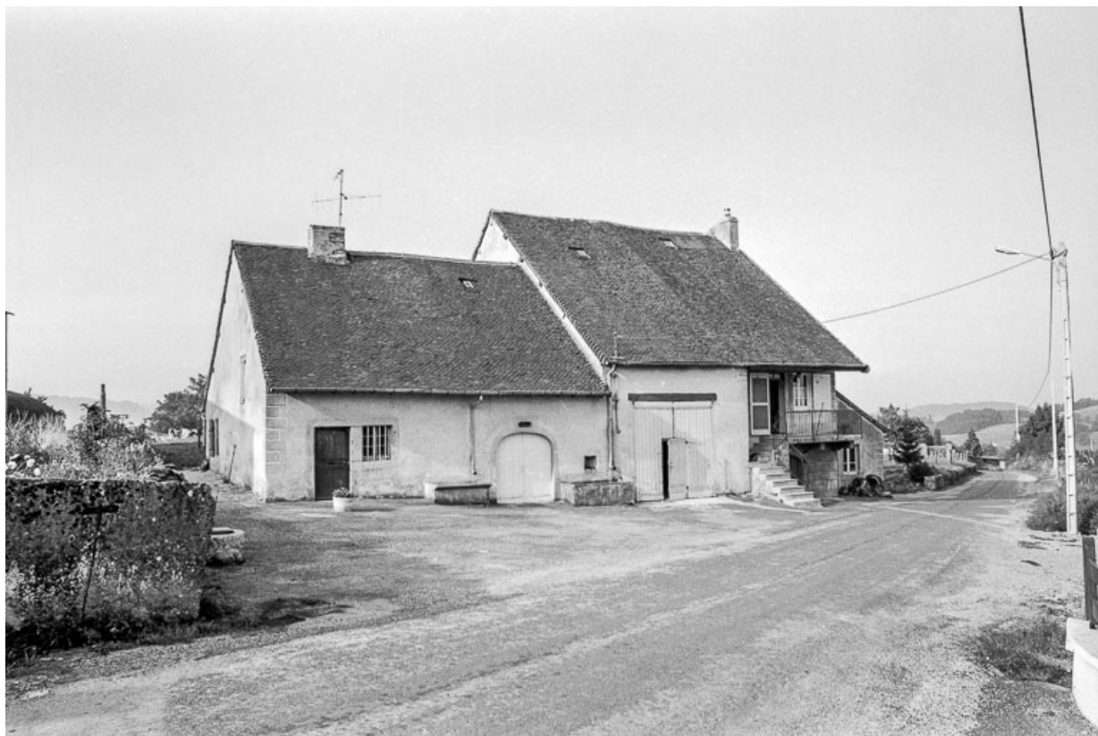
Ferme cadastrée AD 332 : façade antérieure. 39, Pannessières
