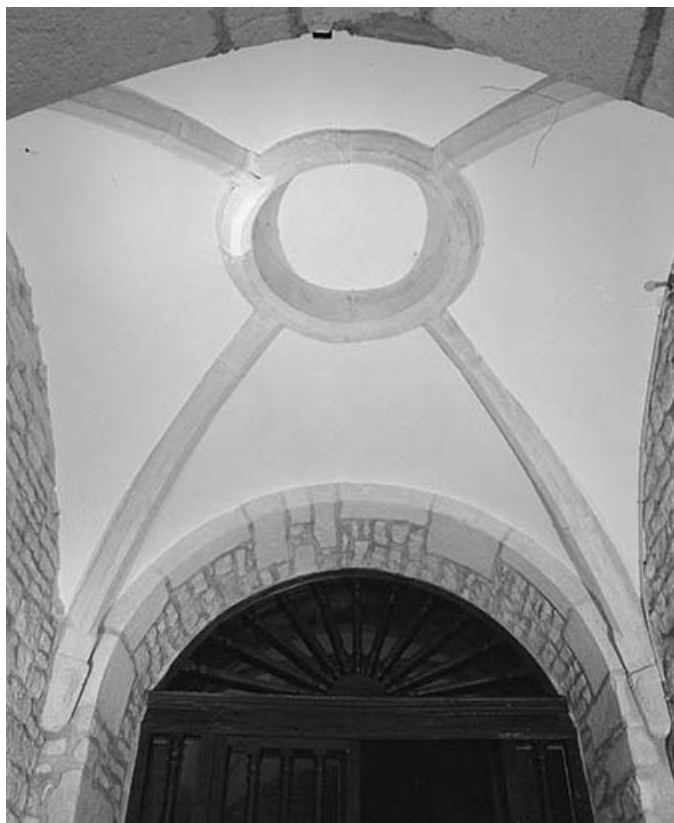
Intérieur : voûte du vestibule.
