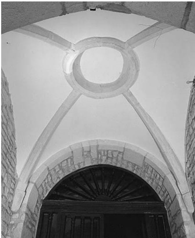
Intérieur : voûte du vestibule.
