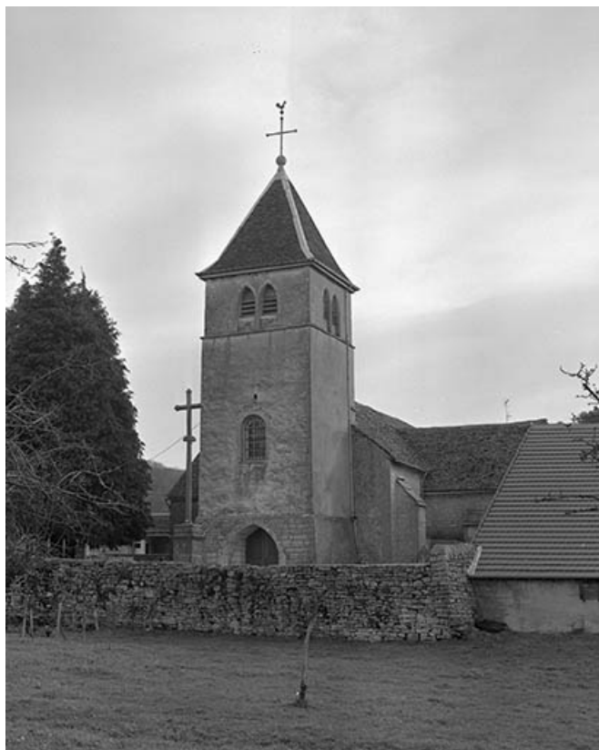
Extérieur : façade antérieure.
