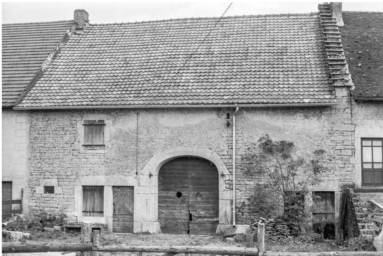
Façade antérieure : vue rapprochée.
