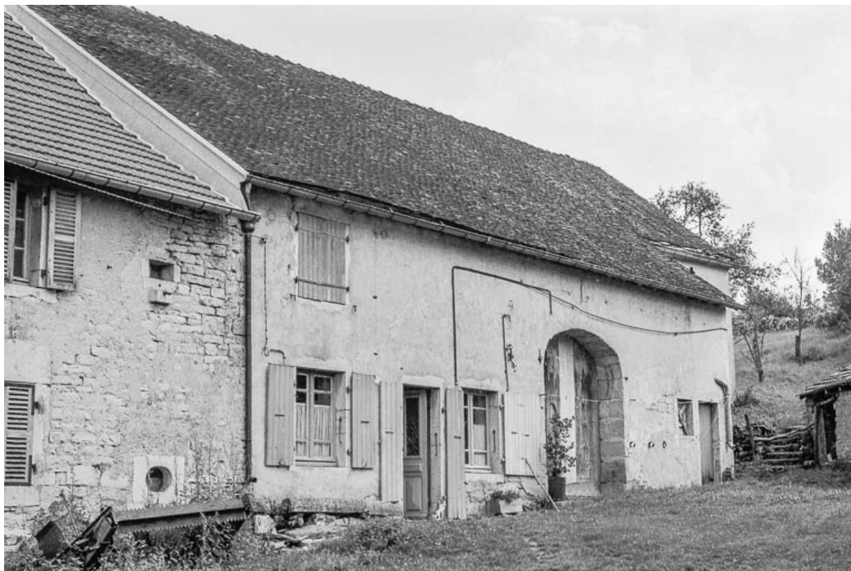
Ferme cadastrée C1 30 : façade antérieure vue de trois quarts gauche.
