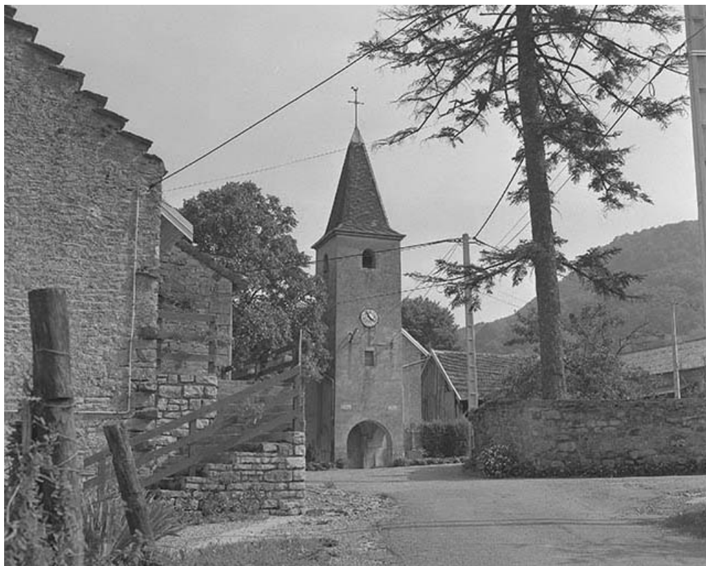
Extérieur : façade antérieure.
