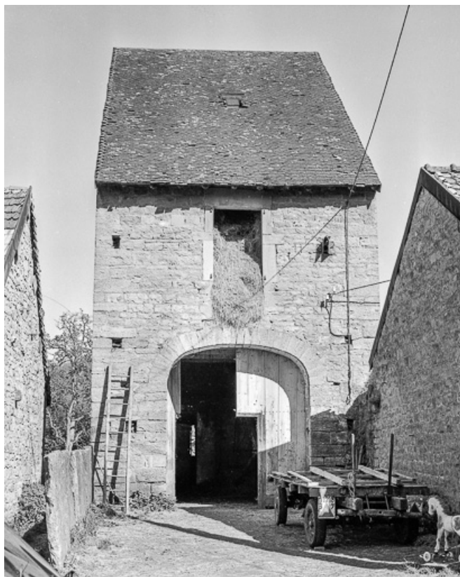
Ferme cadastrée AI 74 : grange. 39, Montaigu
