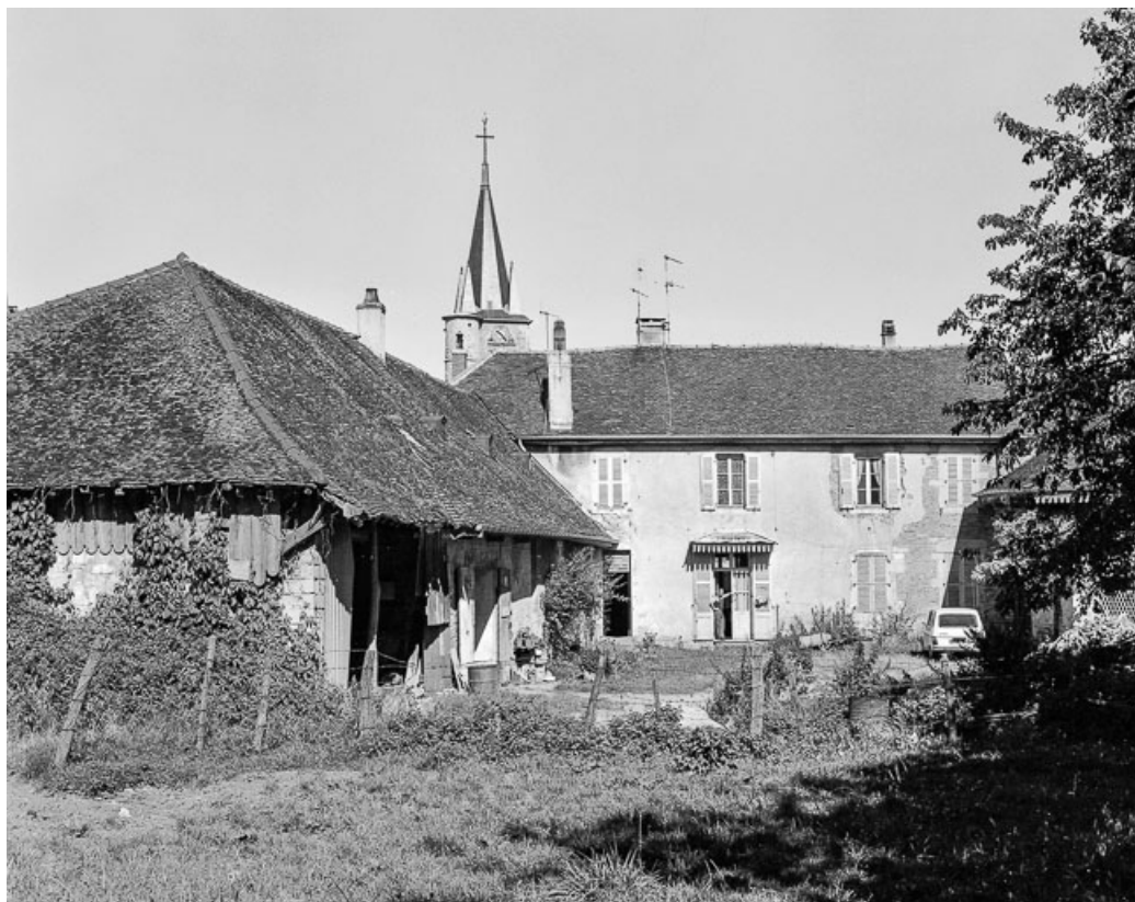
Maison cadastrée AC 251 : façade antérieure.
