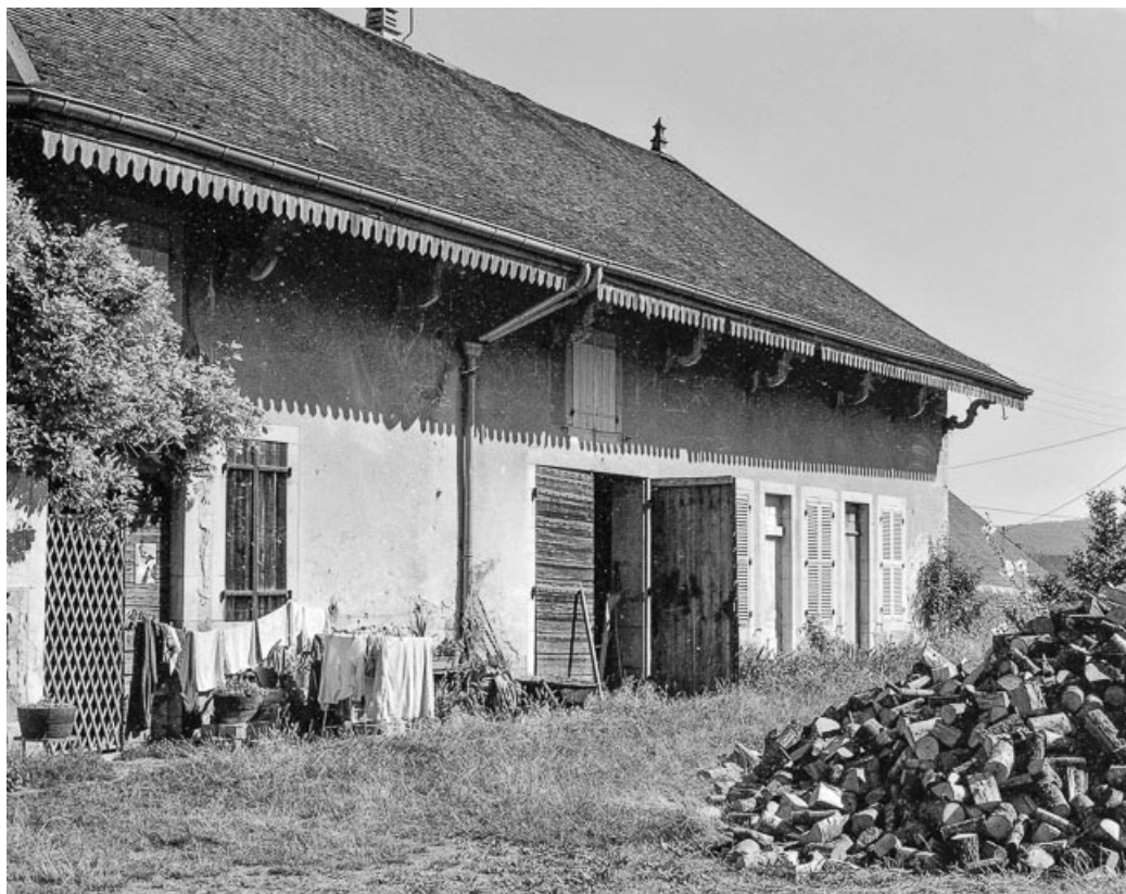
Maison cadastrée AC 251 ; façade postérieure. 39, Montaigu
