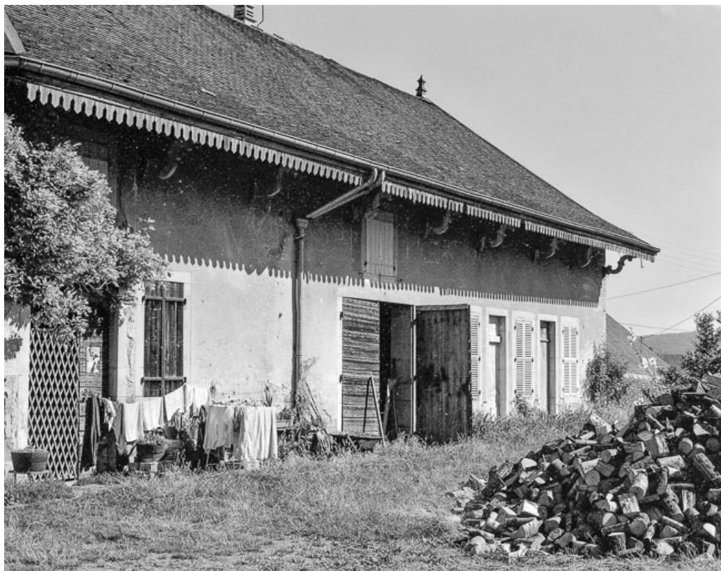
Maison cadastrée AC 251 ; façade postérieure. 39, Montaigu
