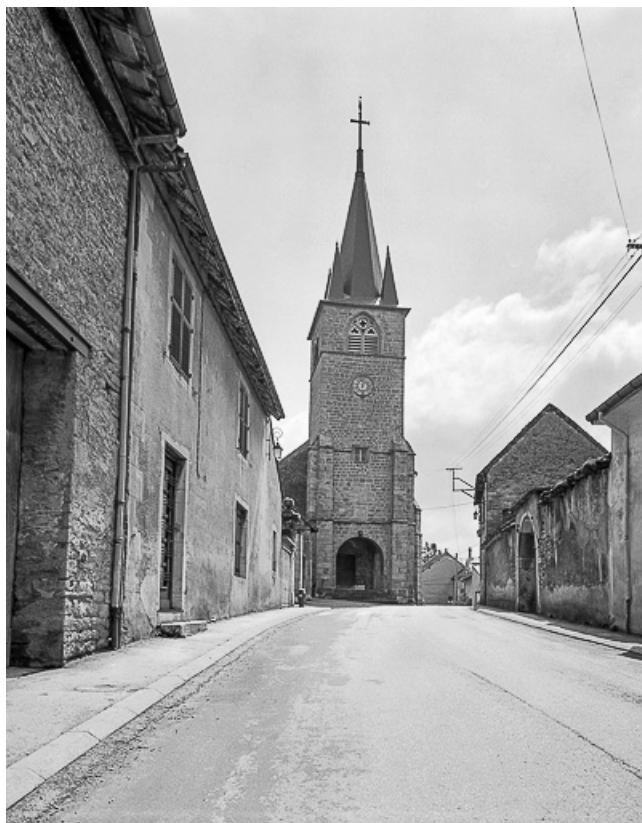
Extérieur : façade antérieure.
