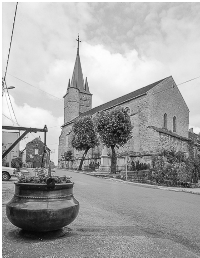
Extérieur : façade latérale droite et chevet.
