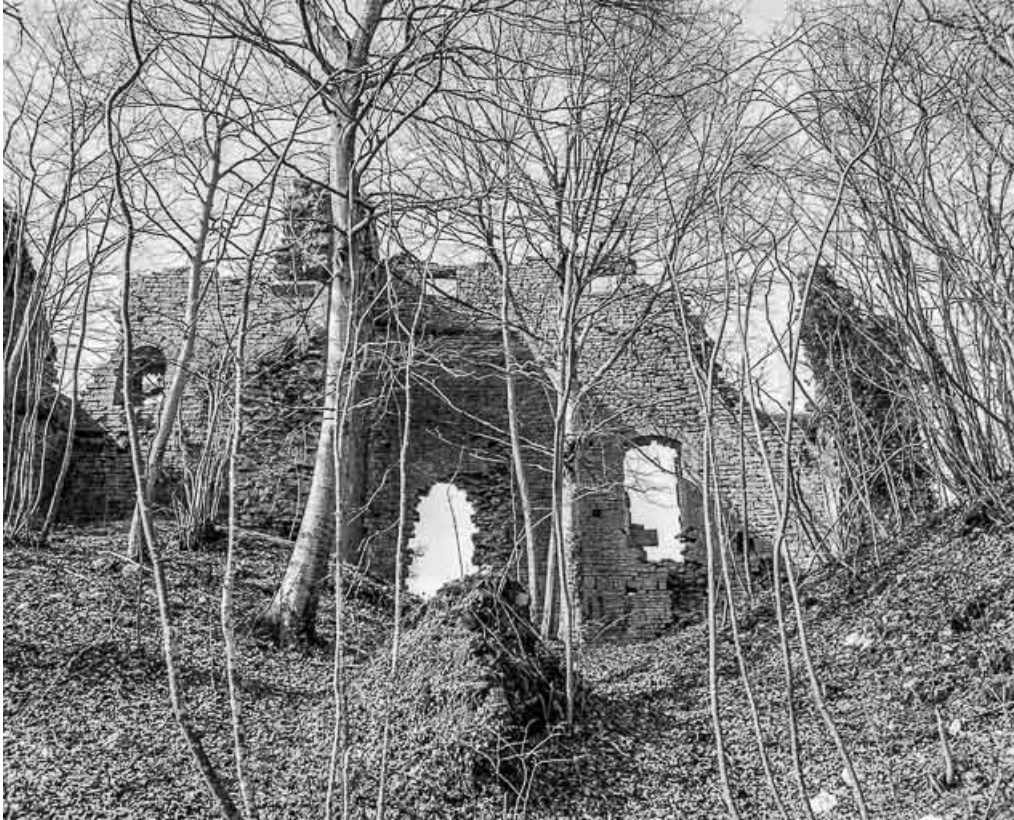
Vue générale des ruines du donjon.
