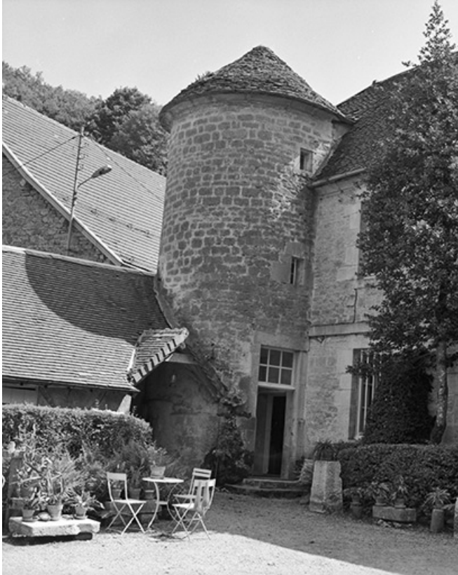
Le logis : tourelle sur la cour.
