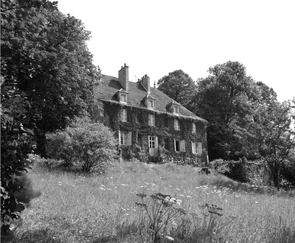
Le logis : façade occidentale vue de trois quarts gauche. 39, Mirebel
