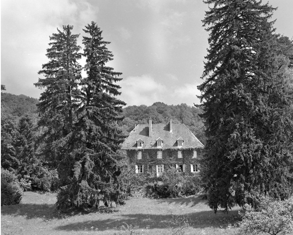
Le logis : façade occidentale vue de face. 39, Mirebel
