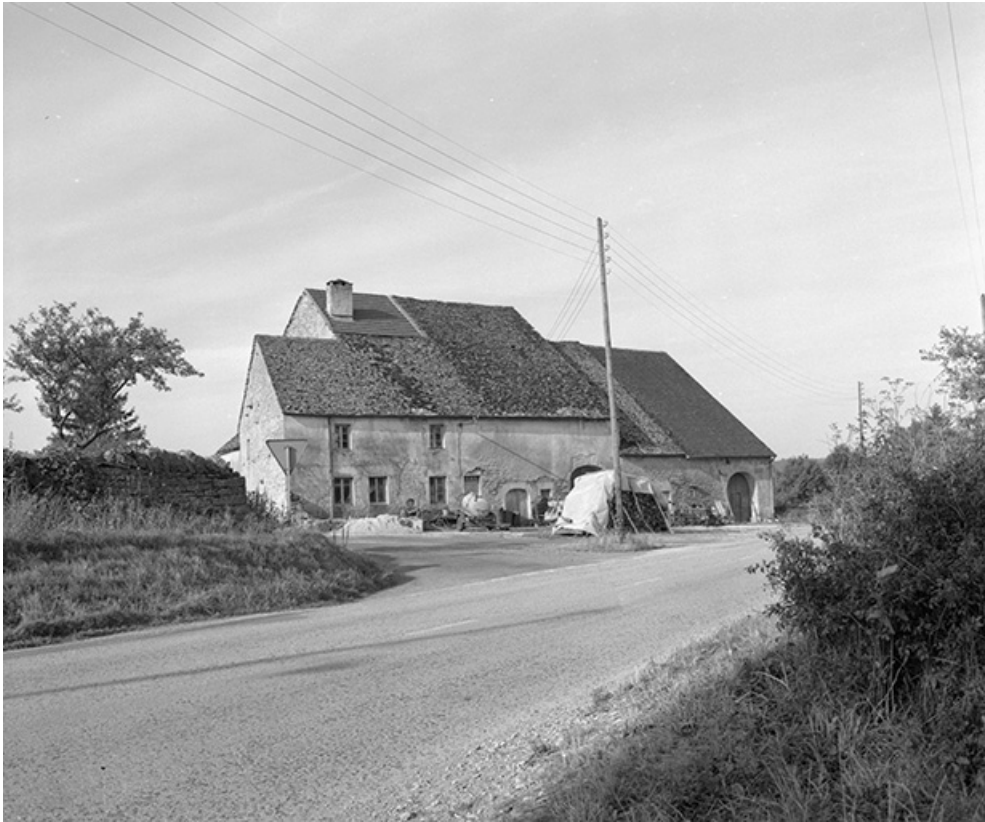
Façade antérieure : vue éloignée.
