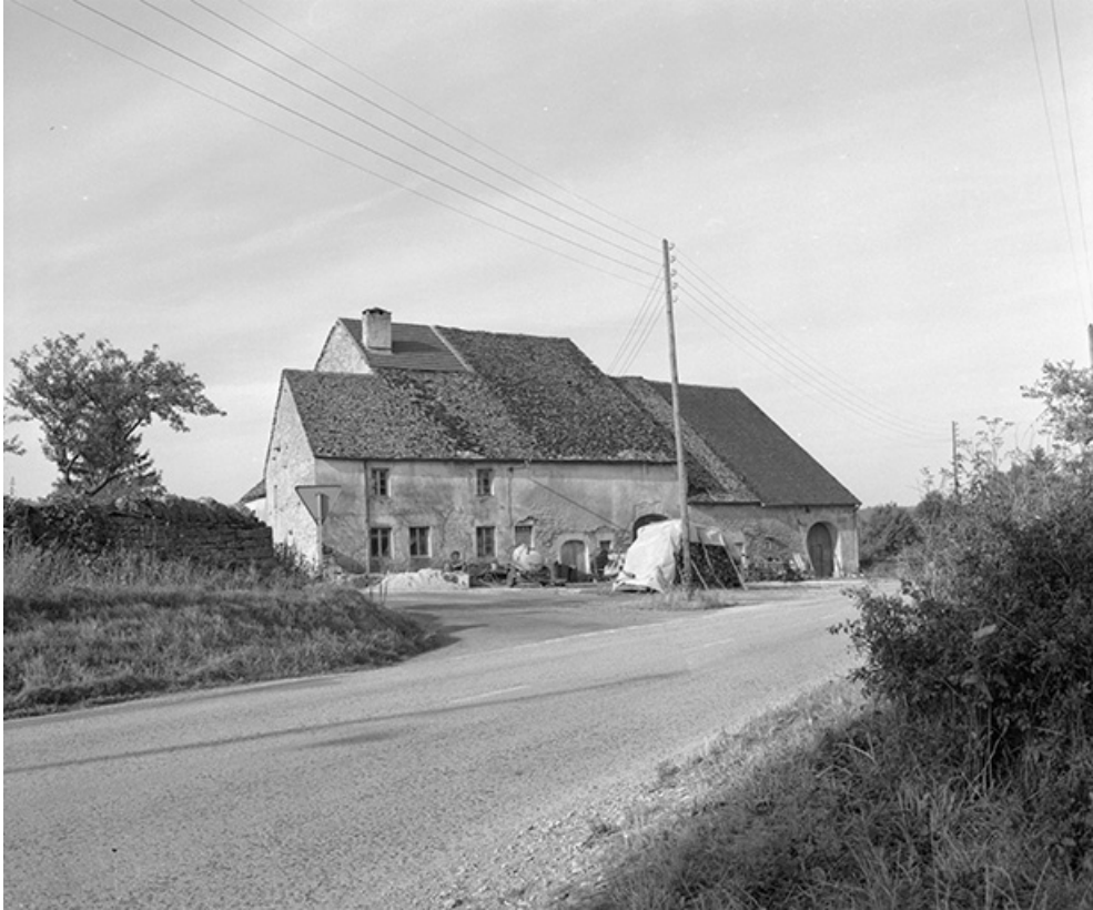
Façade antérieure : vue éloignée.
