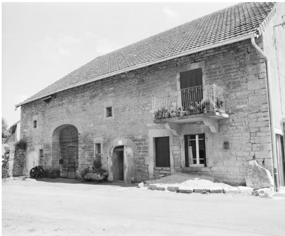
Façade antérieure vue de trois quarts droit en 1979.
