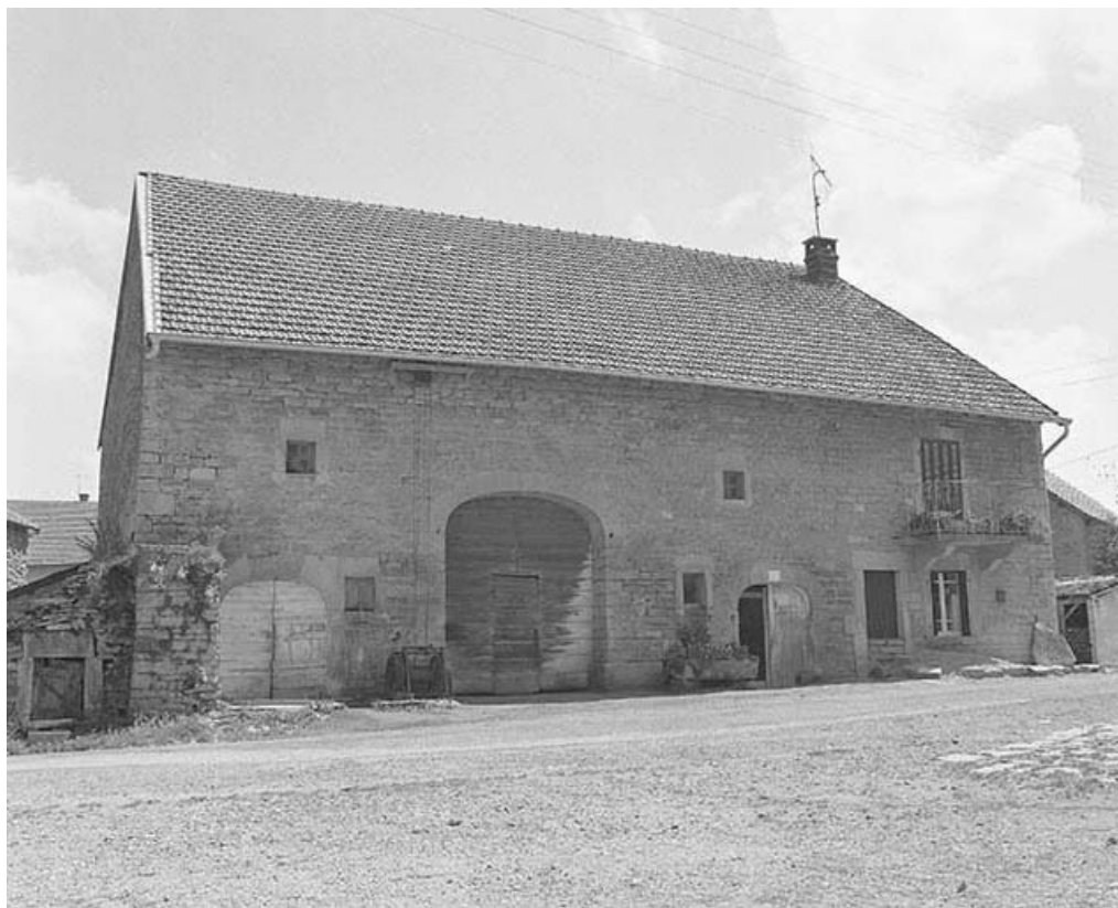
Façade antérieure vue de trois quarts gauche en 1979.
