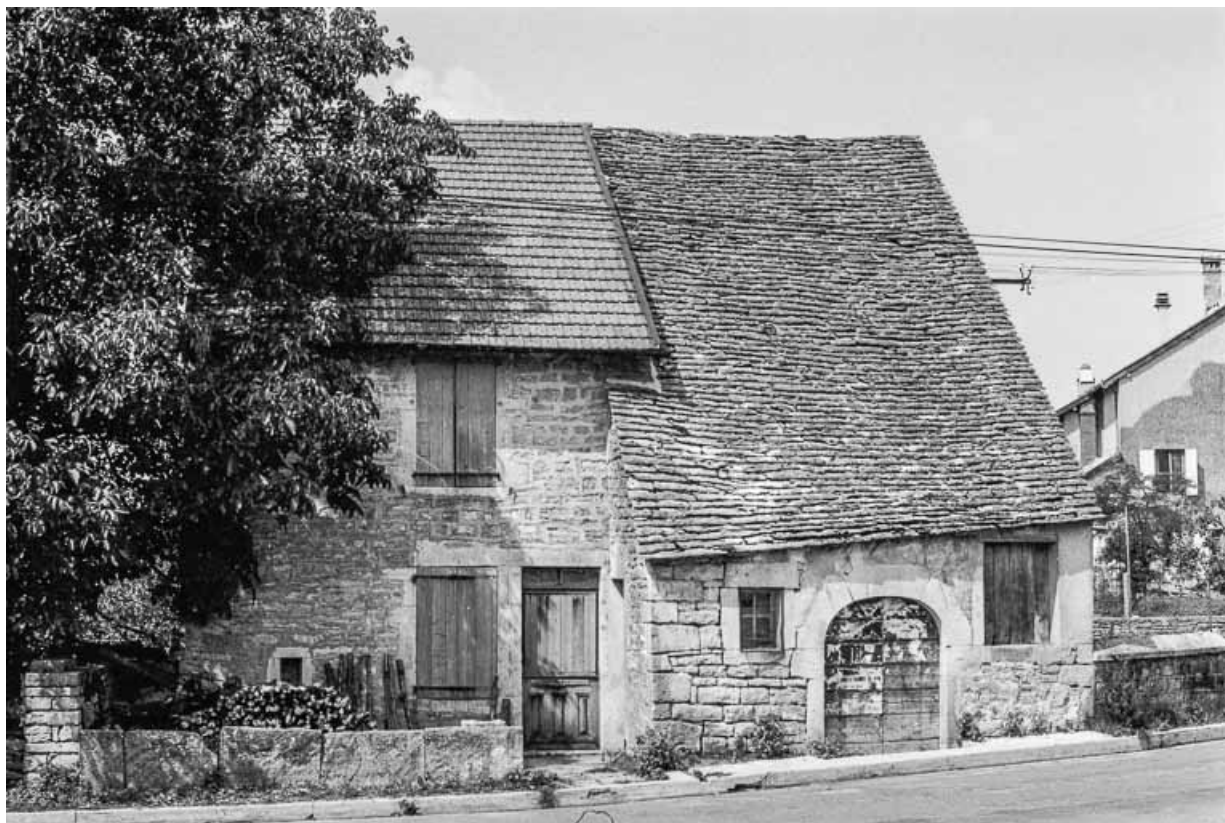
Ferme cadastrée 1951 E1 65 : façade antérieure. 39, Crançot
