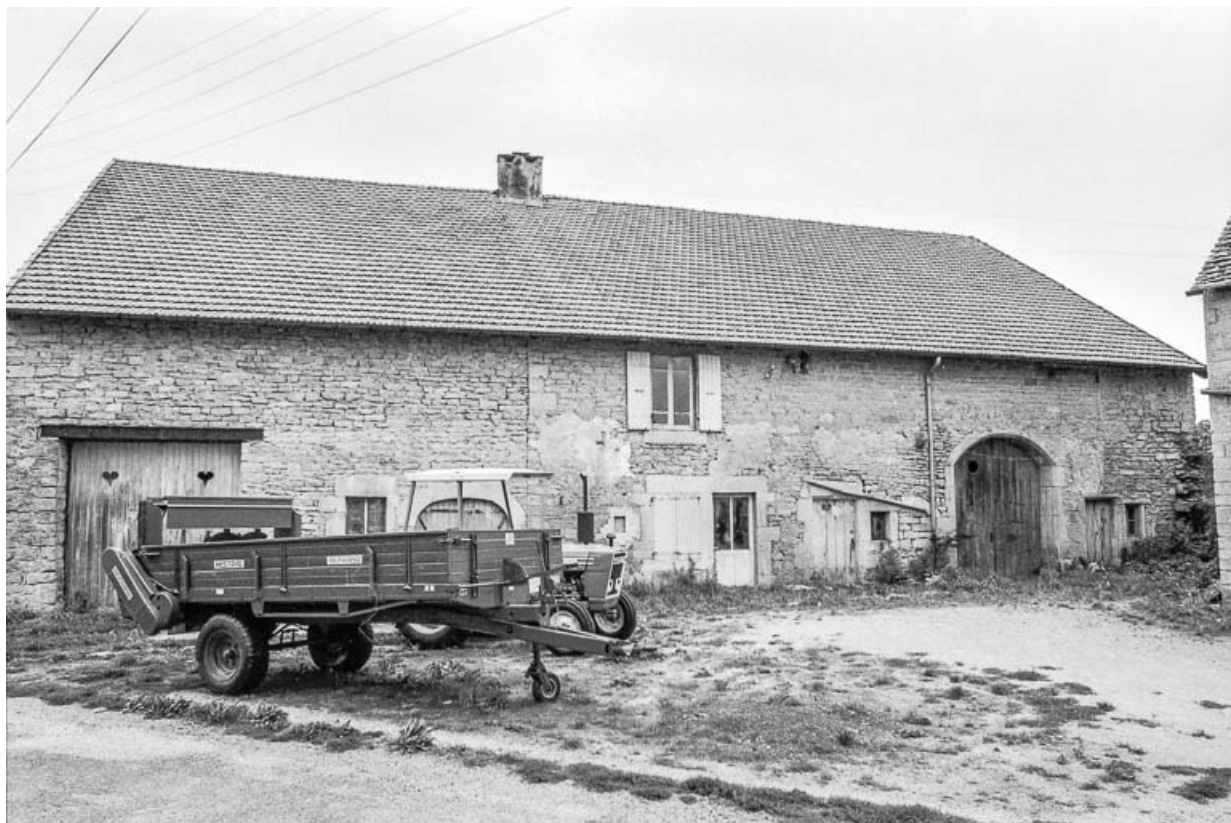
Ferme cadastrée 1951 E1 268 : façade antérieure. 39, Crañot
