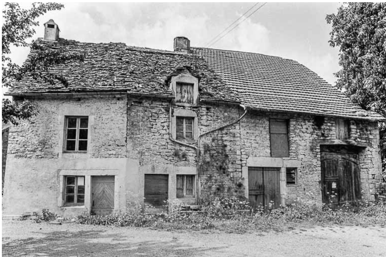
Ferme cadastrée 1951 E1 76 : façade antérieure.
