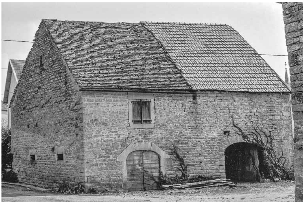
Ferme cadastrée 1951 E1 93 : bâtiment agricole. 39, Crañot
