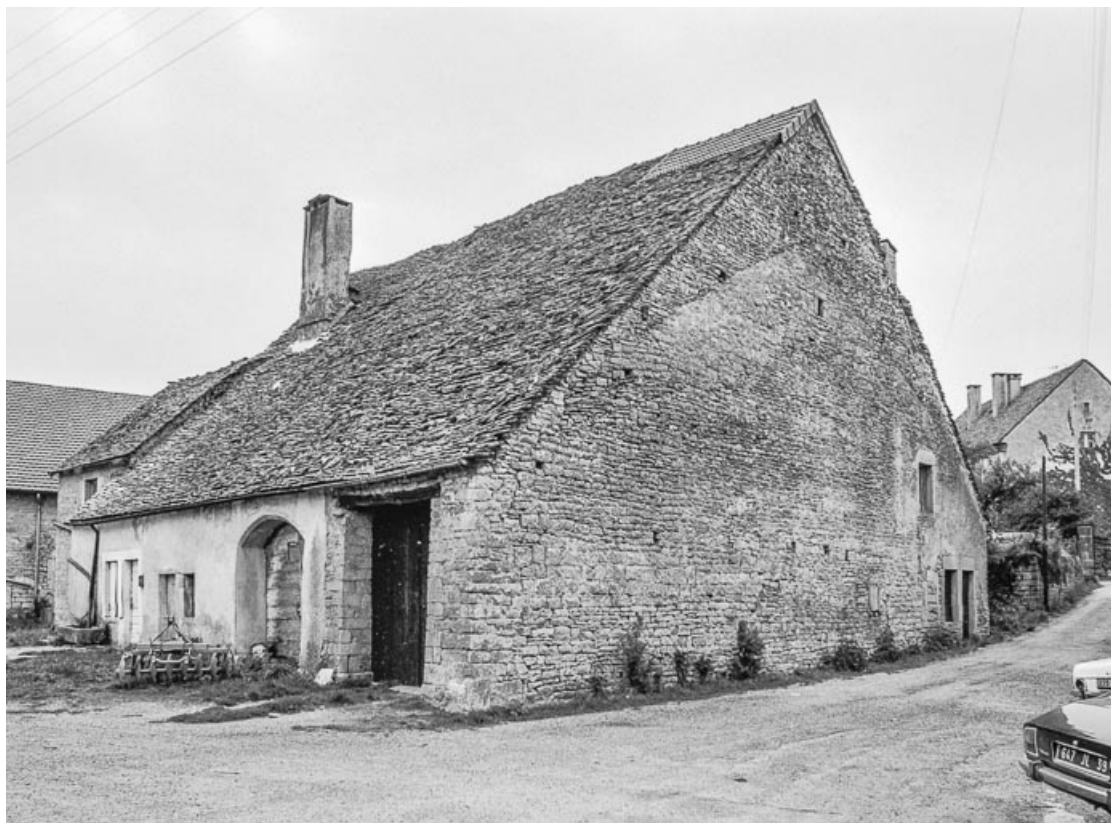
Ferme cadastrée 1951 E1 266 : façades antérieure et latérale droite. 39, Craçot
