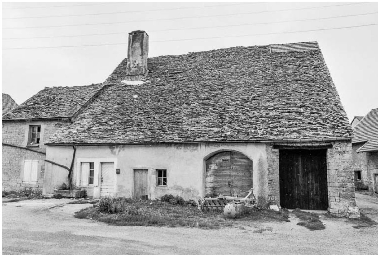
Ferme cadastrée 1951 E1 266 : façade antérieure. 39, Crañot
