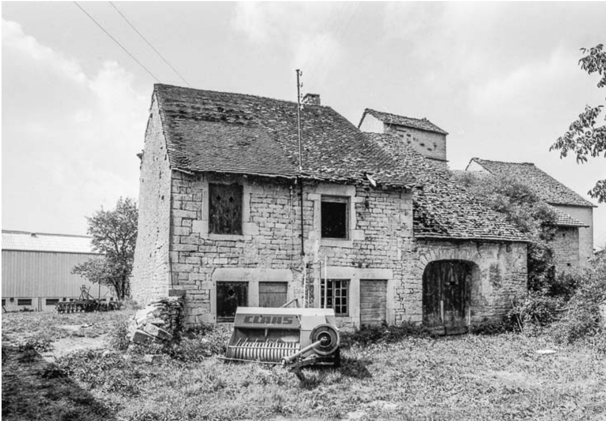
Ferme cadastrée 1951 E1 150 : vue d'ensemble.
