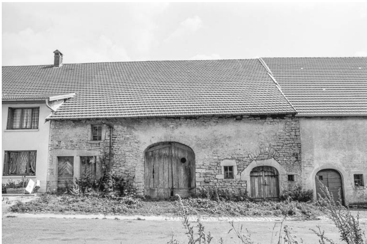
Ferme cadastrée 1951 E1 53 : façade antérieure. 39, Crañot
