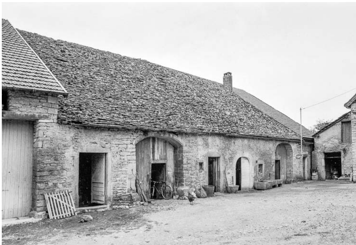
Ferme cadastrée 1951 E1 56-58 : façade sur la cour intérieure. 39, Craçot
