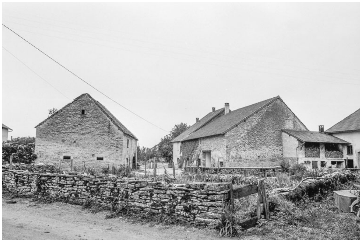
Ferme cadastrée 1951 E1 93 : vue d'ensemble.
