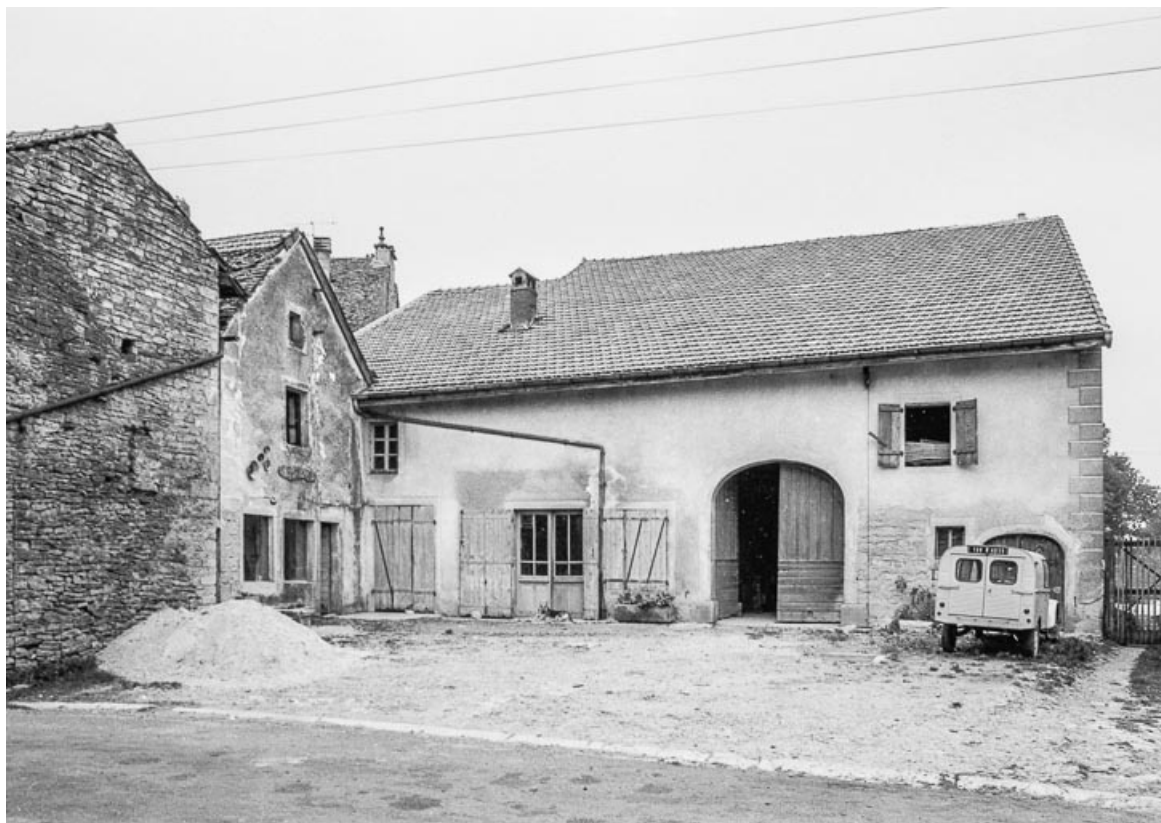
Ferme cadastrée 1951 E1 110 : façade antérieure. 39, Crañot
