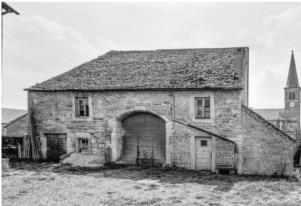
Ferme cadastrée 1951 E1 228-231 : façade sur cour avec l'église en arrière-plan. 39, Craçot
