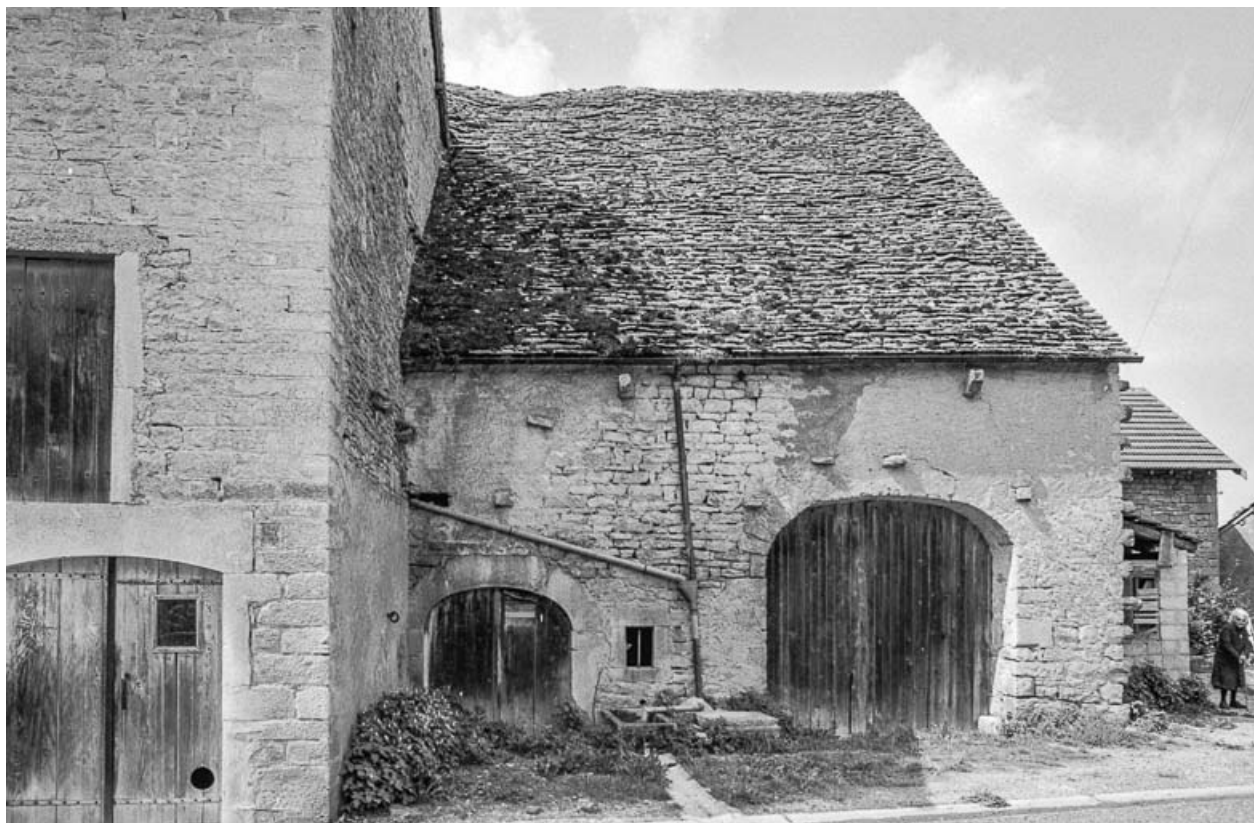
Ferme cadastrée 1951 E1 79 (droite) : façade sur rue. 39, Crançot
