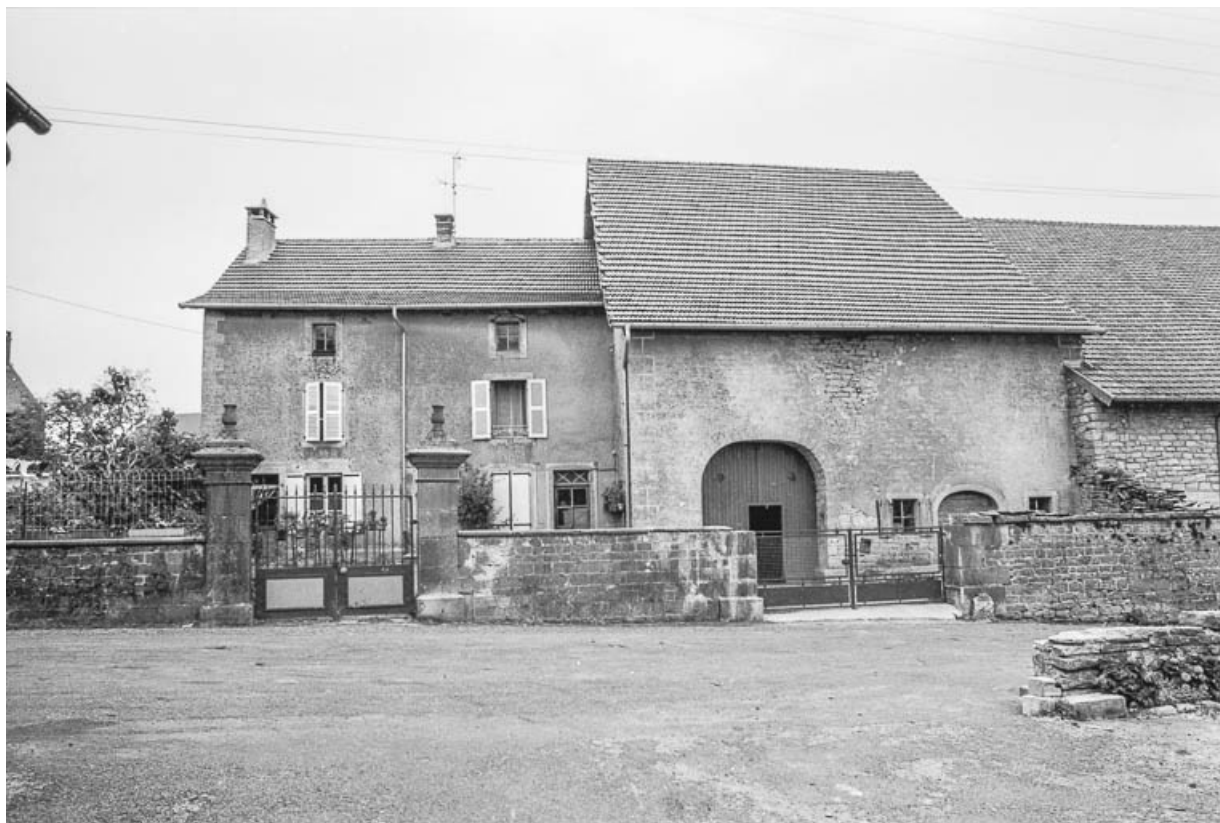
Ferme cadastrée 1951 E1 130 : façade antérieure.
