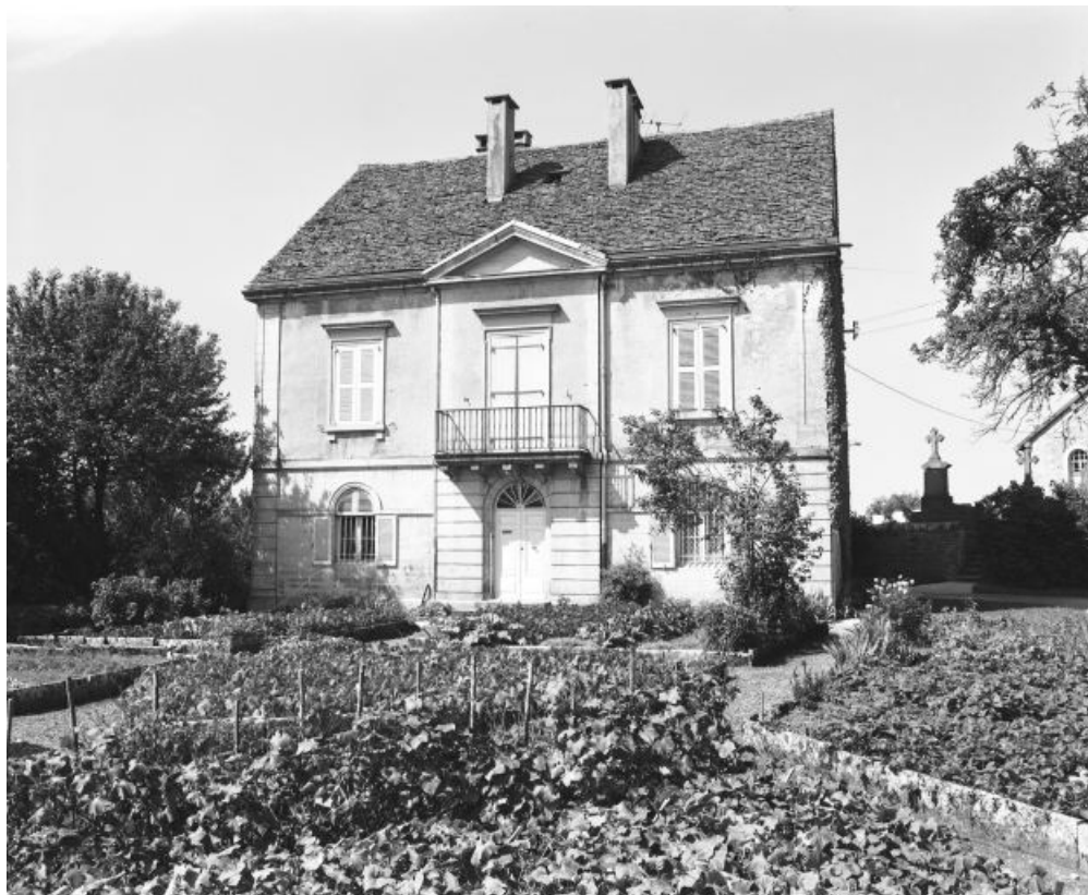
Façade antérieure vue de face.
