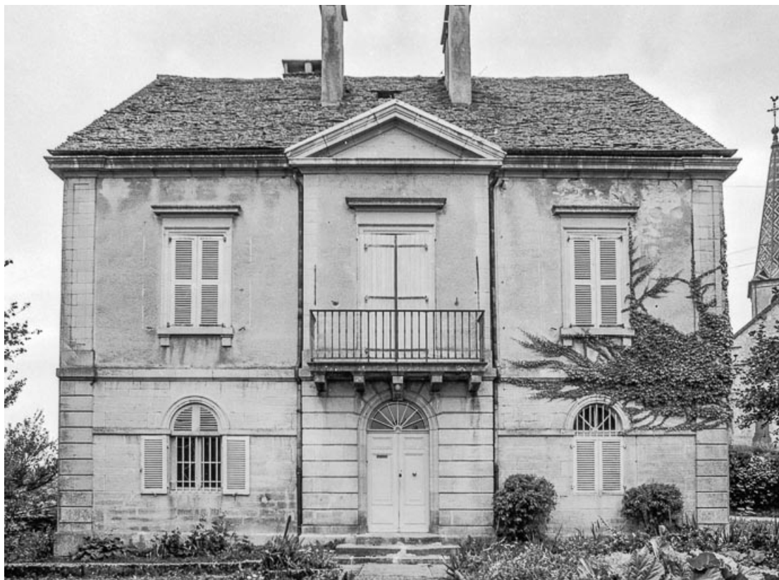
Façade antérieure vue rapprochée de face.
