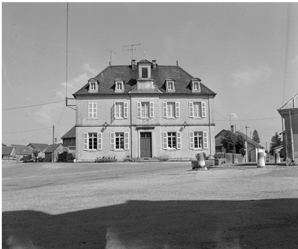
Façade antérieure vue depuis la rue. 39, Crañot
