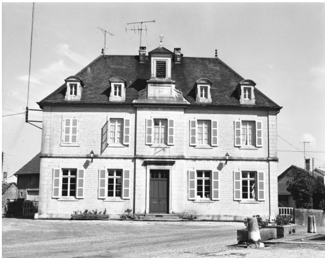
Façade antérieure : vue rapprochée.
