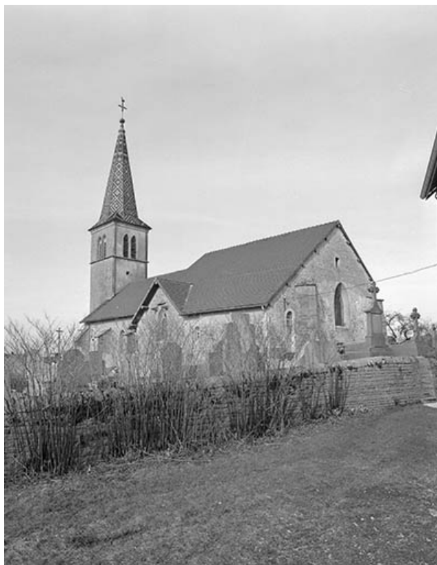
Extérieur : face latérale droite et chevet.
