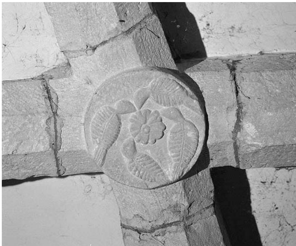
Intérieur : clé de voûte du chœur.
