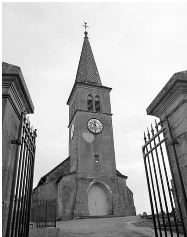
Extérieur : façade antérieure.
