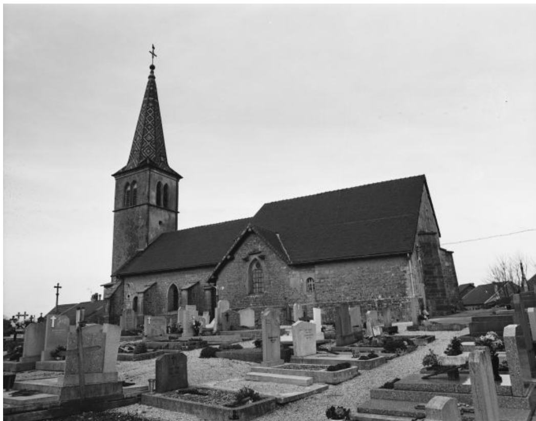
Façade latérale droite.
