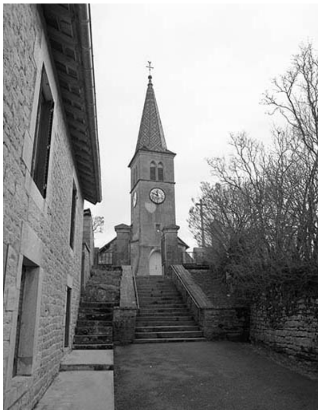
Extérieur : façade antérieure.
