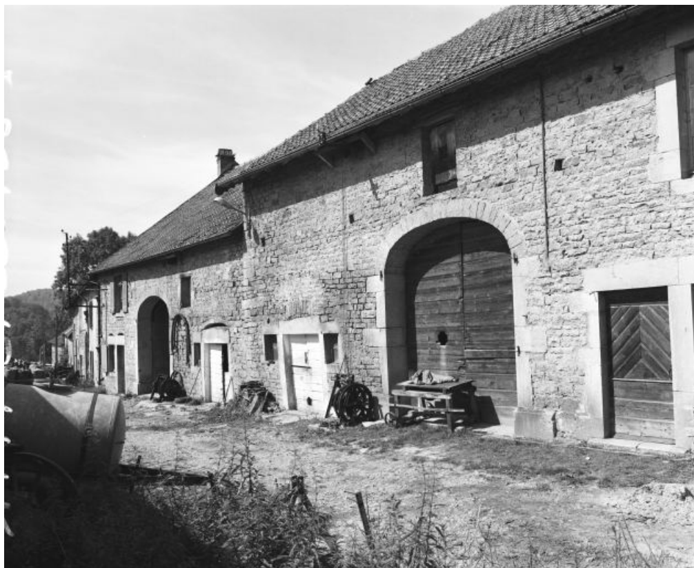
Vue d'ensemble de l'îlot formé par les fermes section A, 2e feuille, parcelles 258 à 263, vu depuis le nord.
