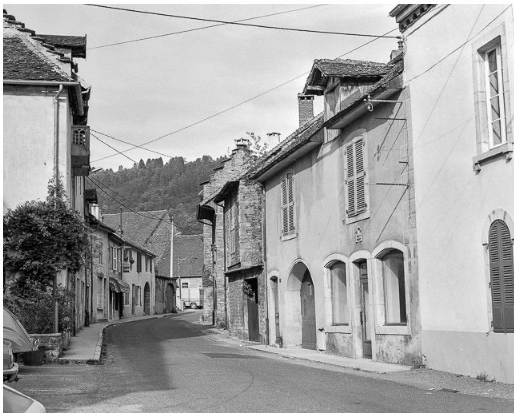
Maisons de la rue Haute : façades sur rue. 39, Conliège
