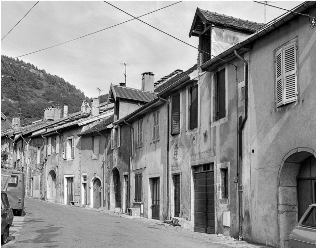
Maisons de la rue Haute : façades sur rue. 39, Conliège
