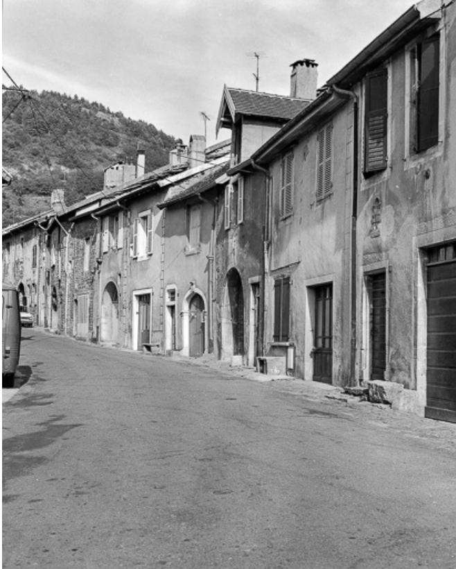
Maisons de la rue Haute : façades sur rue. 39, Conliège
