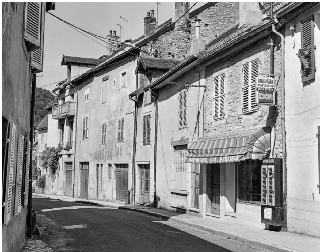
Maisons de la rue Haute et boulangerie : façades sur rue. 39, Conliège
