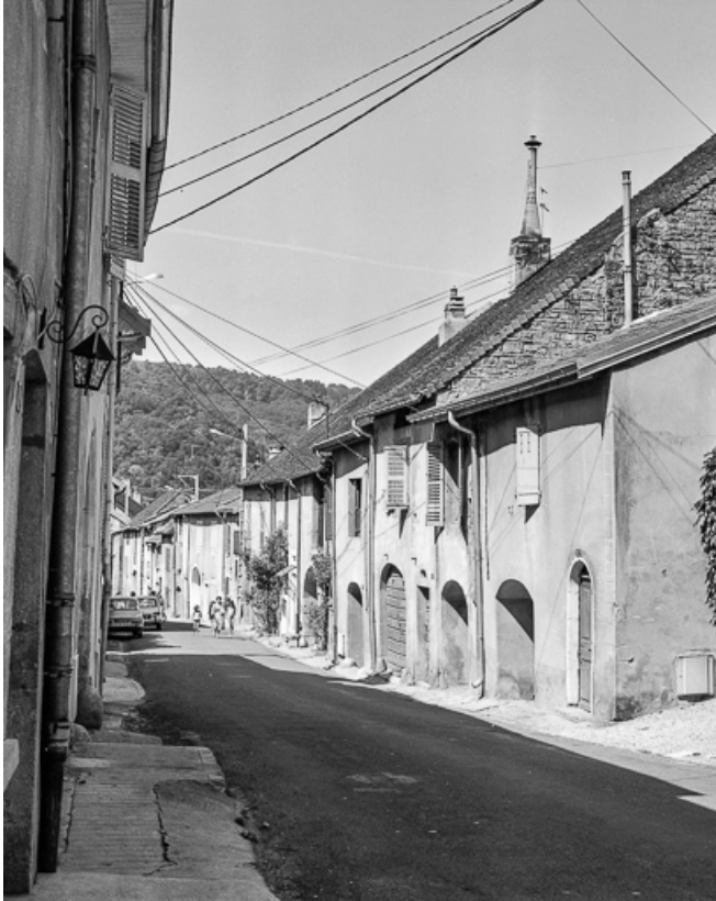
Maisons de la rue Haute : façades sur rue. 39, Conliège
