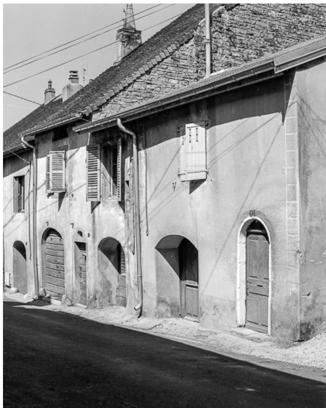
Maisons : façades sur rue.
