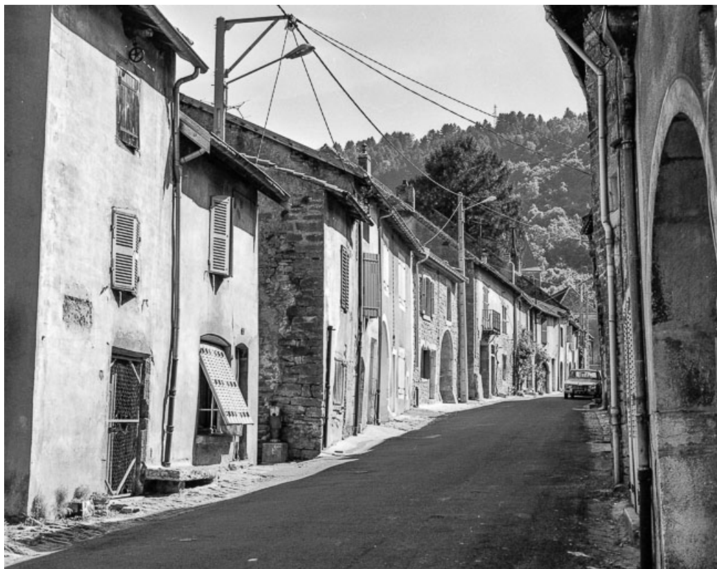
Maisons de la rue Haute : façades sur rue.
