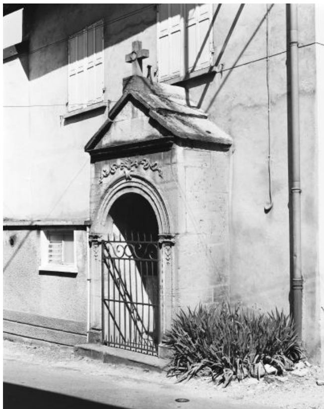
Vue d'ensemble de trois quarts droit.
