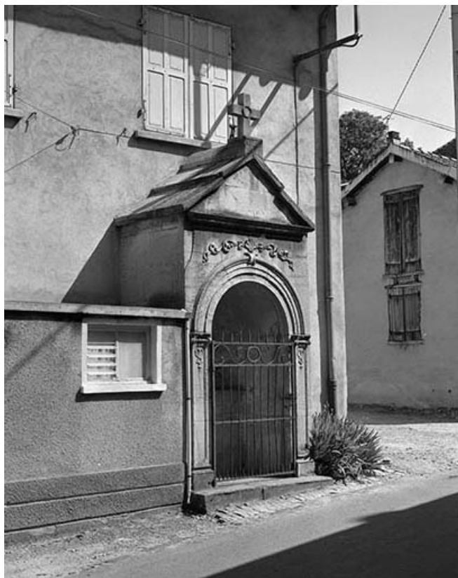
Vue générale de trois quarts gauche.
