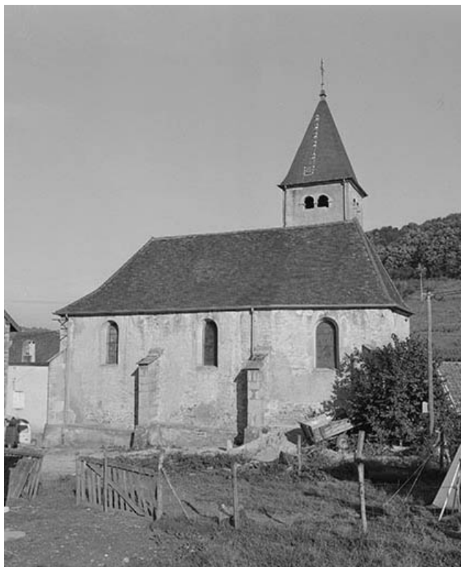
Extérieur : face latérale droite.
