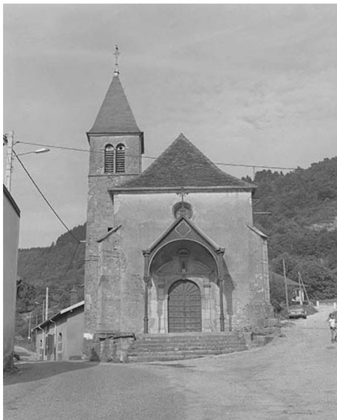
Extérieur : façade antérieure.
