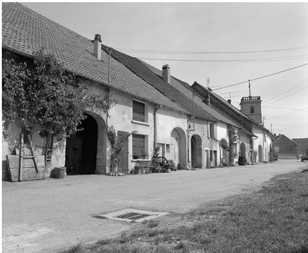
Ferme : façades sur rue.
