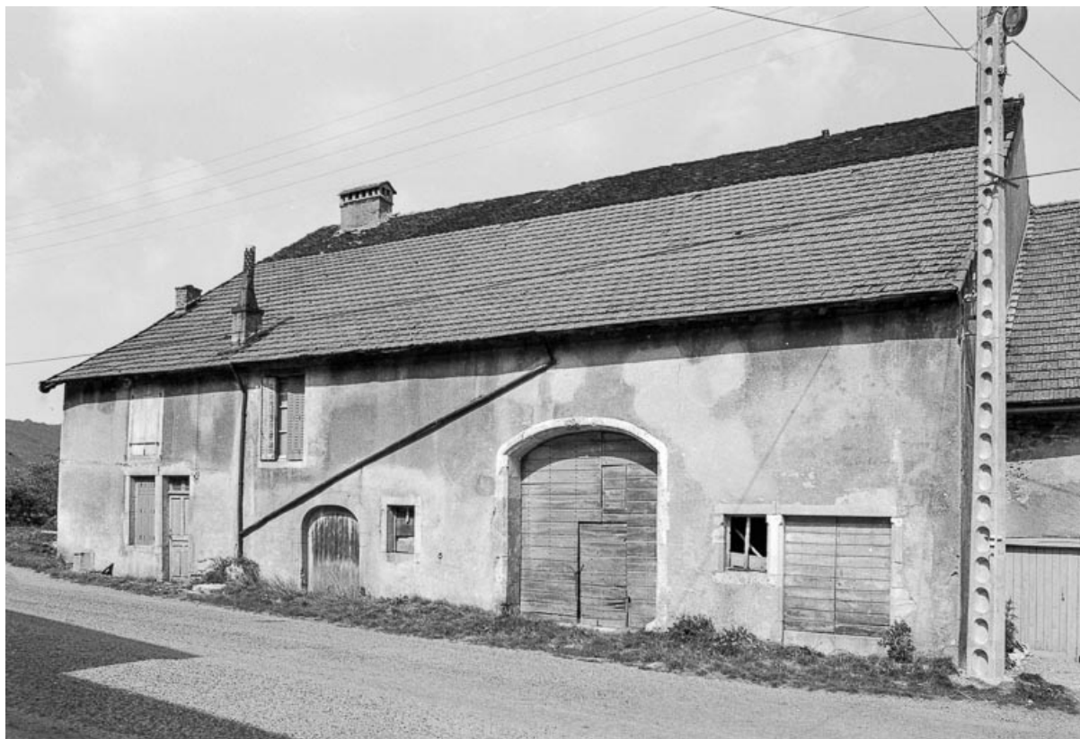
Ferme cadastrée C2 180 : façade antérieure. 39, Châtillon
