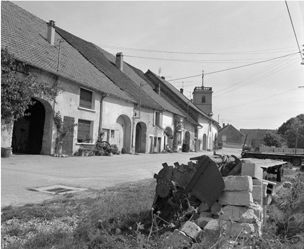
Fermes : façades sur rue.
