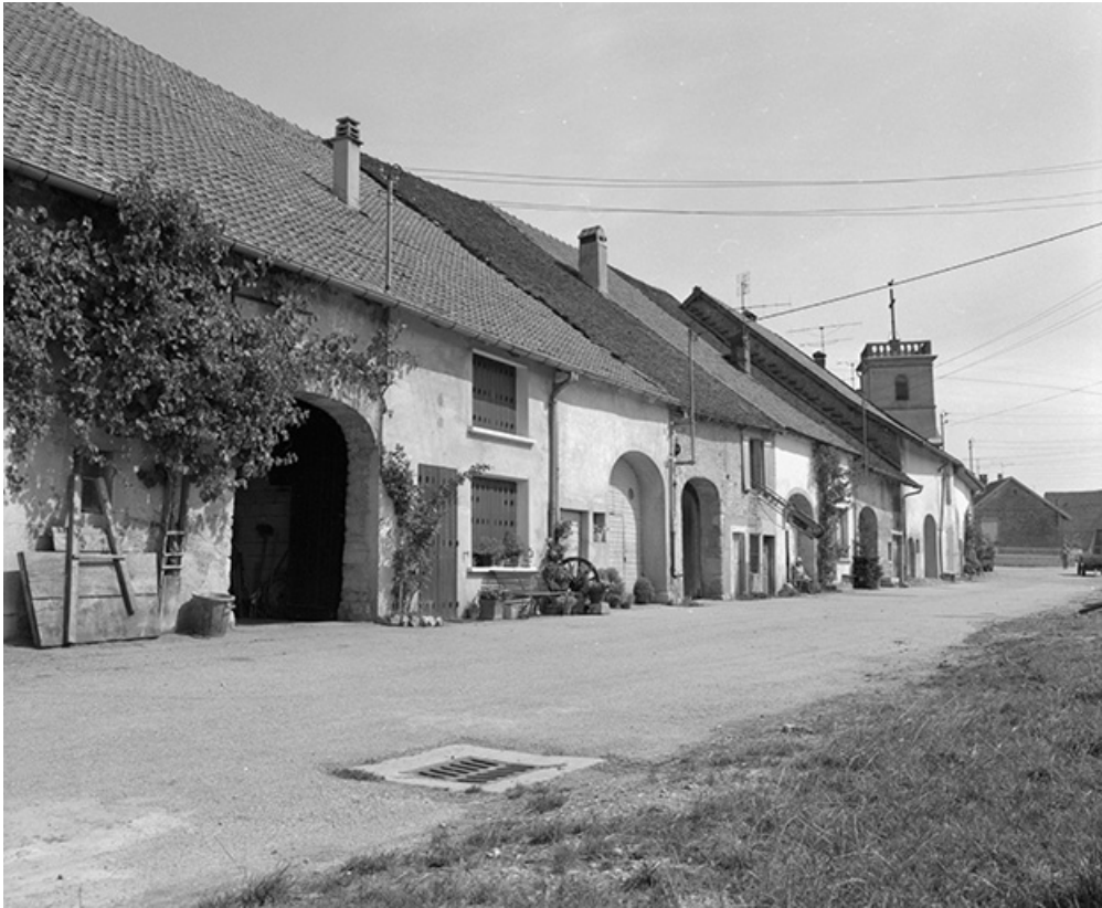
Fermes : façades sur rue.
