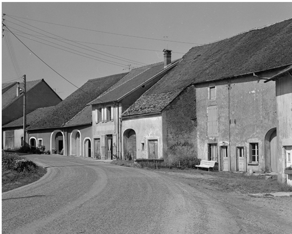
Ferme : façades sur rue.
