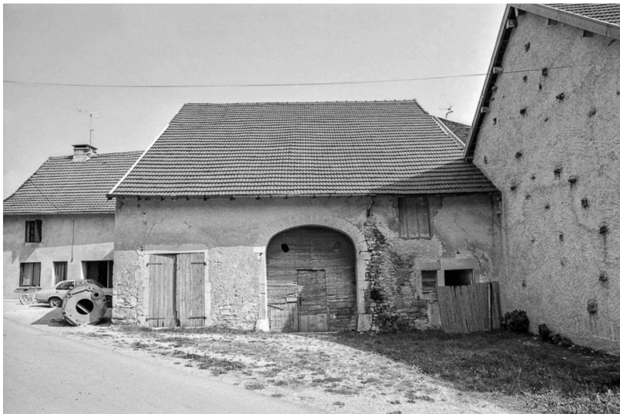
Ferme située au lieudit Sous les Barres, cadastrée C2 330 : façade postérieure (?). 39, Châtillon
