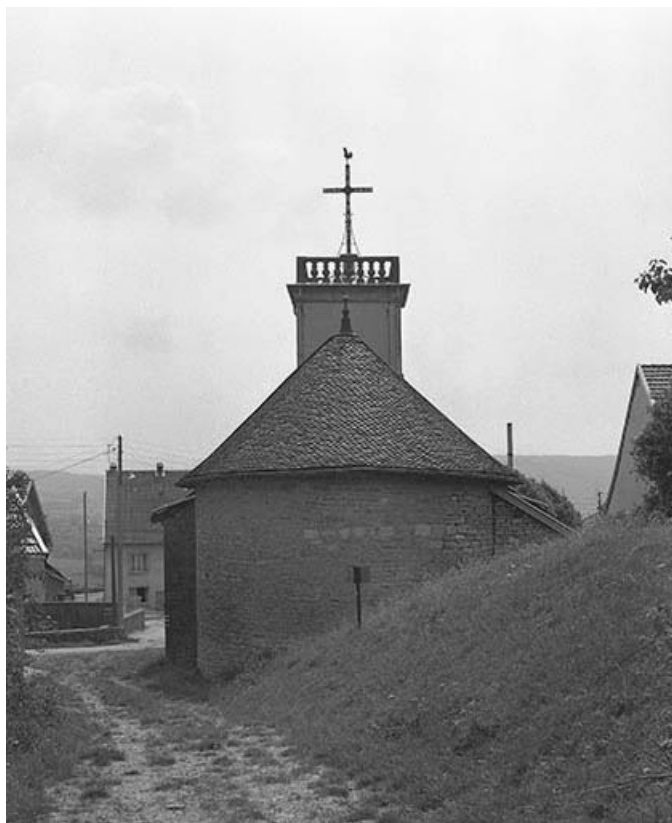
Extérieur : abside, vue de face.
