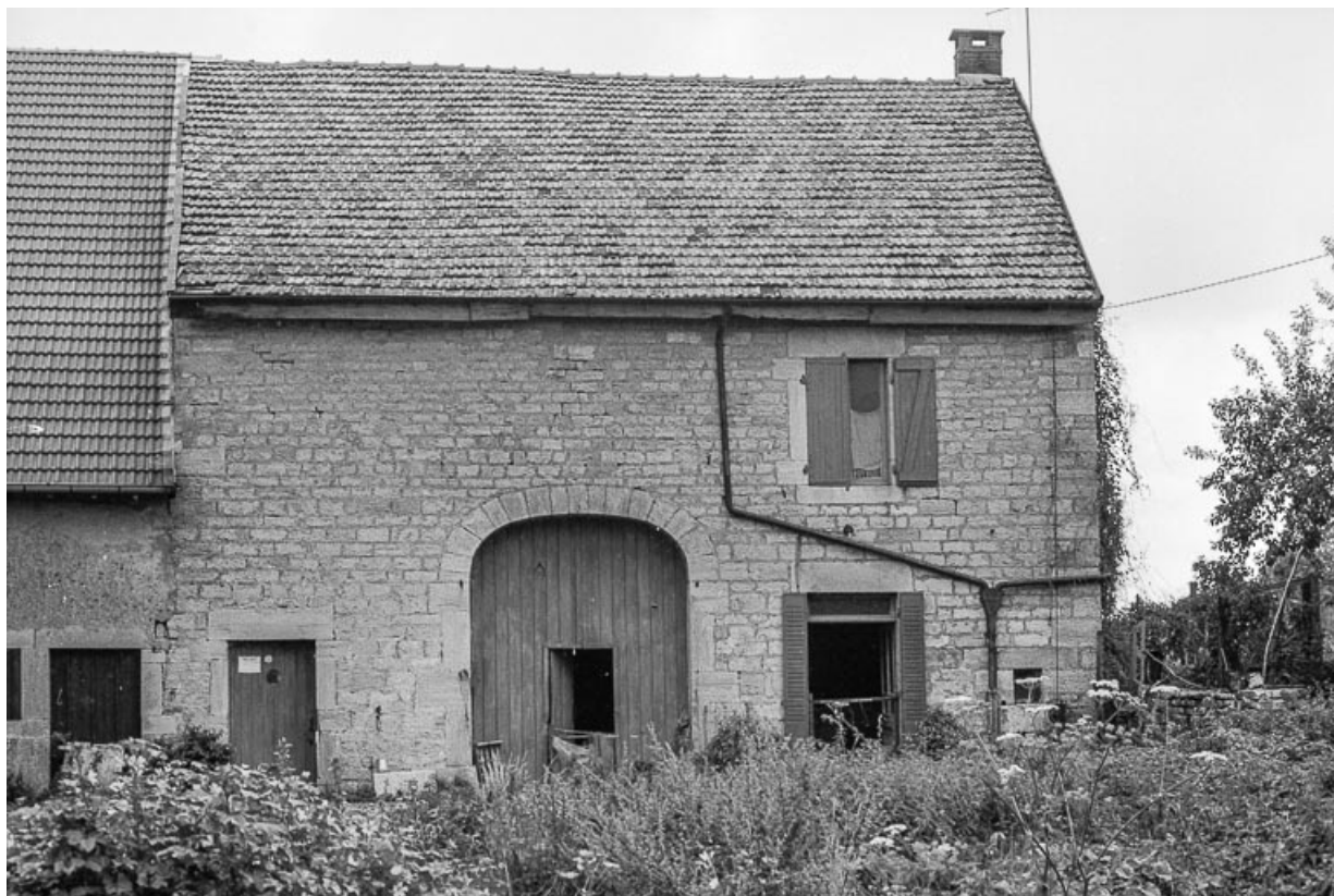
Façade antérieure : vue rapprochée. 39, Briod
