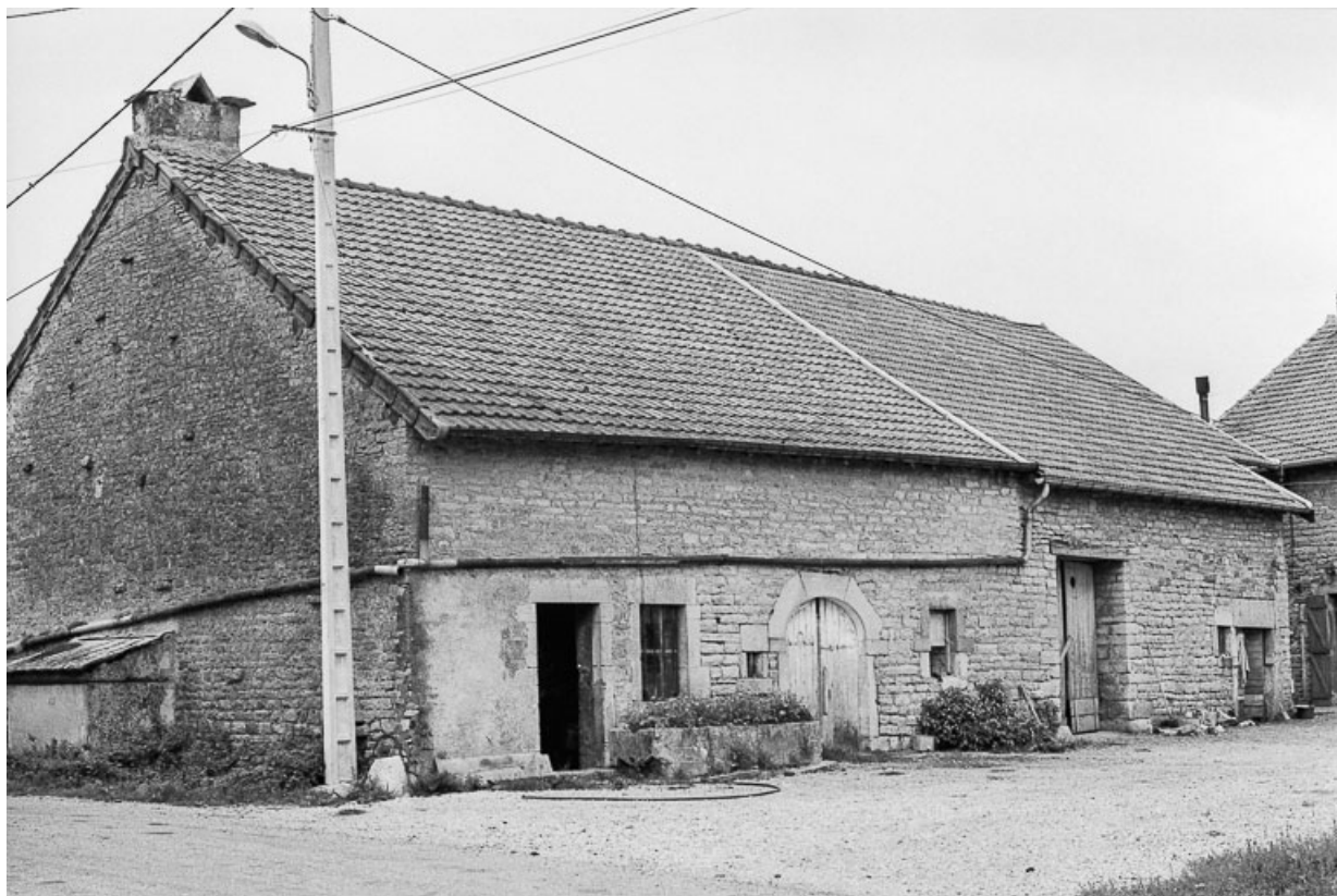
Ferme cadastrée B2 157 : façade sur rue. 39, Briod
