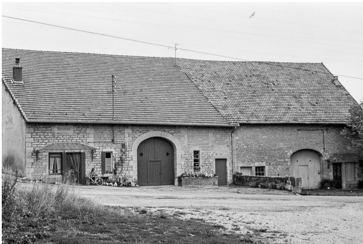
Ferme cadastrées B2 181 et 182 : façades antérieures. 39, Briod
