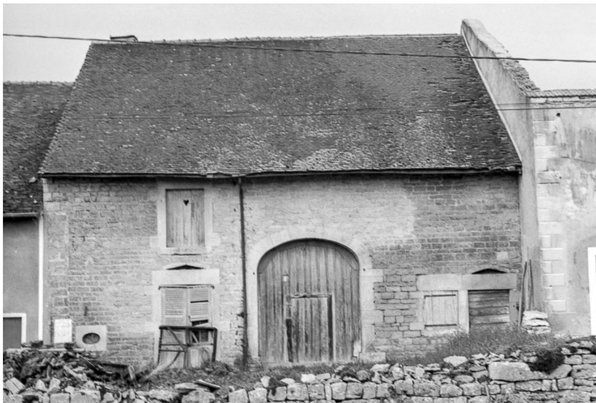
Ferme cadastrée B2 134 : façade postérieure (?). 39, Briod
