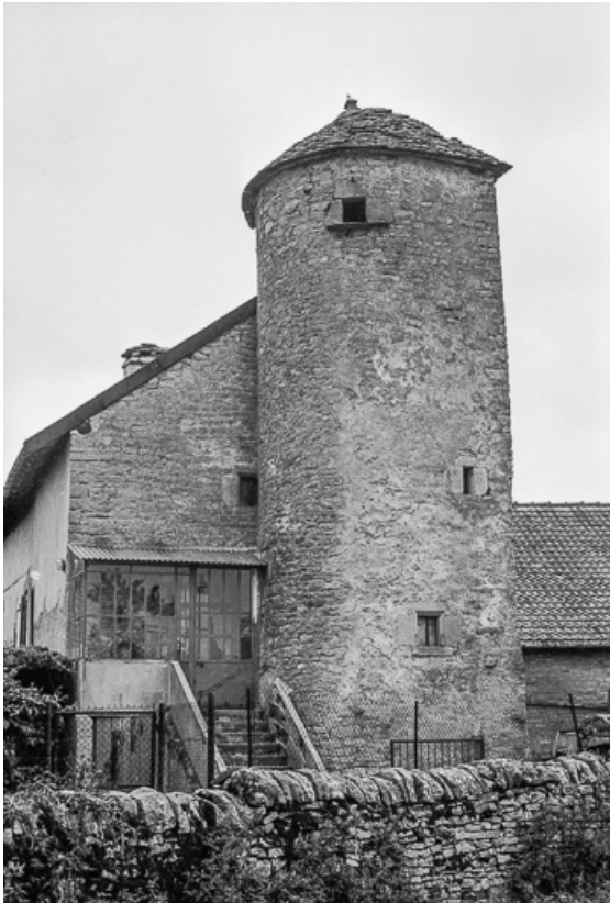
Ferme : tour et mur en pierre sèche. 39, Briod
