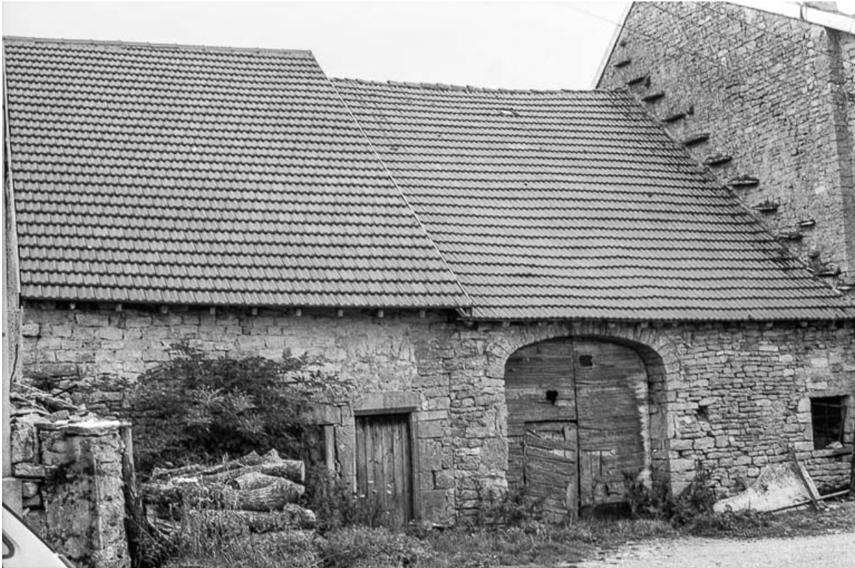
Ferme cadastrée B2 176 : façade postérieure. 39, Briod
