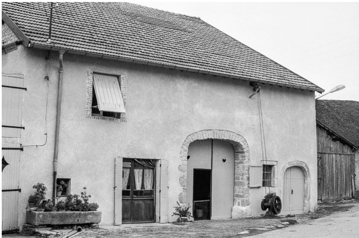
Ferme cadastrée B2 113 : façade antérieure.
