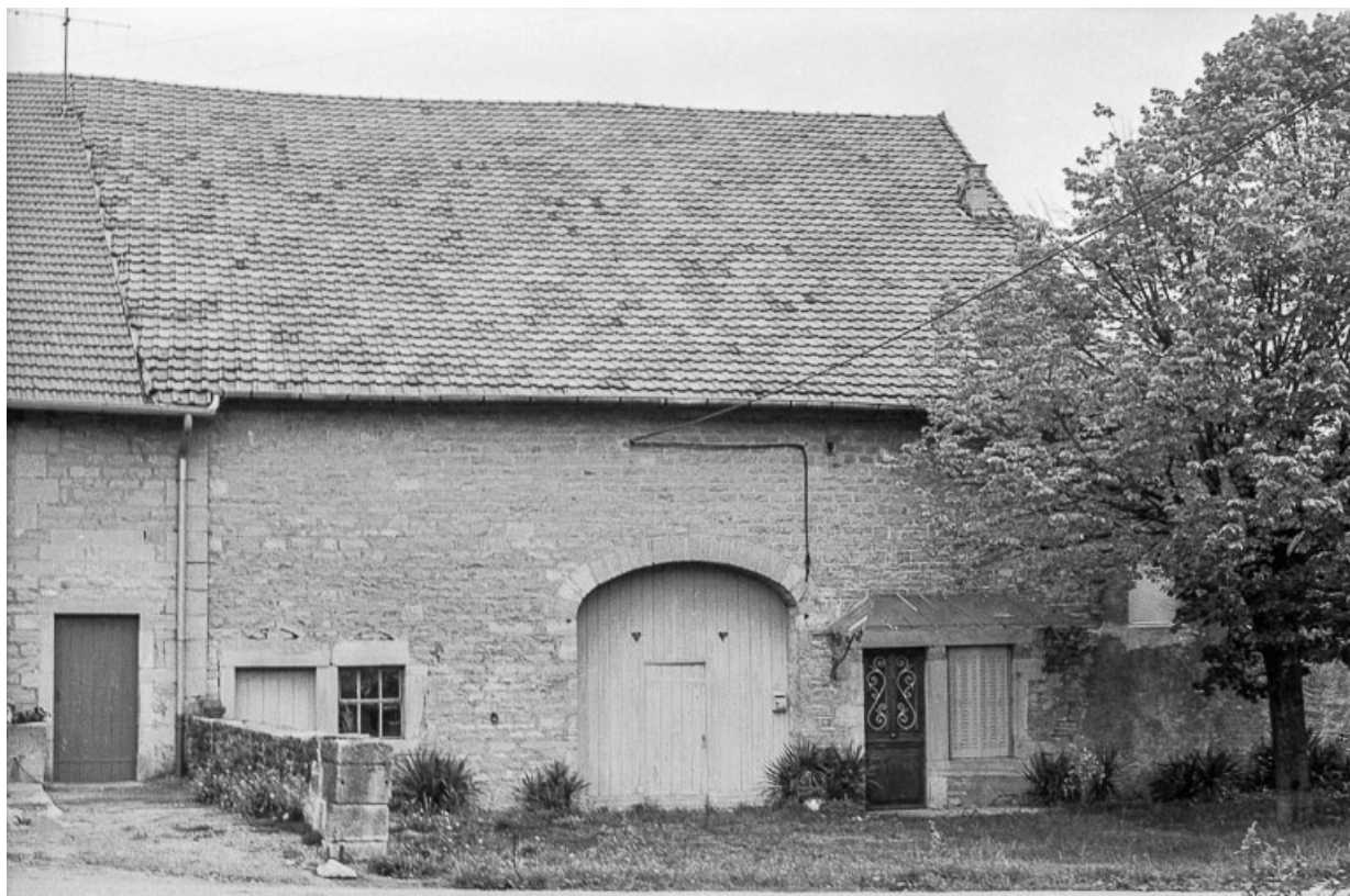
Ferme cadastrée B2 181 : façade antérieure.
