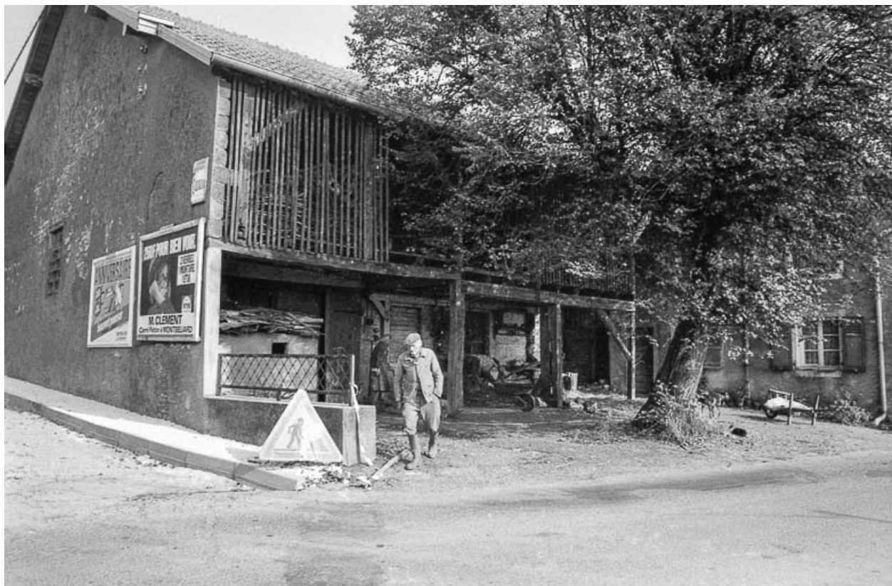
Façade antérieure : détail. 25, Taillecourt
